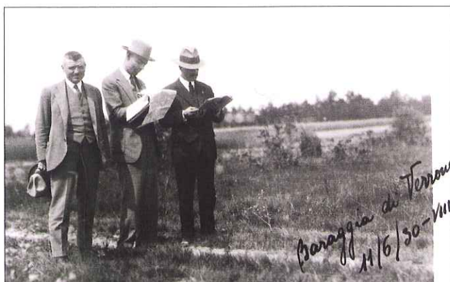
1930 - Sopralluogo nella Baraggia di Verrone: al centro l'Ing. Monti ed alla sua destra il Geom. Stefano Maceraudi dell'Associazione Irrigazione Ovest Sesia
