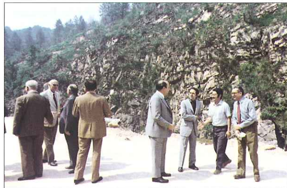
1972 - Il Prefetto di Vercelli Antonino Giuffrida in visita al cantiere dell'Ostola con Monti e Forzani, Giuffrida e Iacopino
