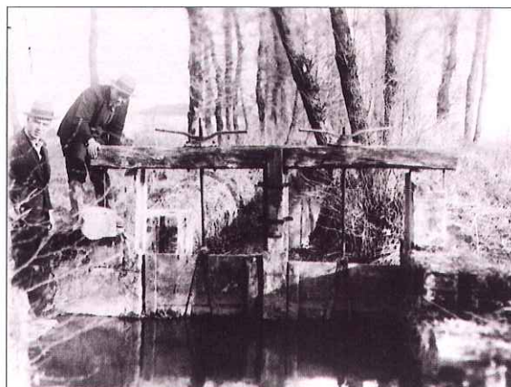
1932 - Ancora l'ing. Monti in uno dei tanti sopralluoghi che servirono per lo sviluppo degli studi sulla Baraggia
