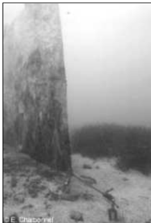
Figura 5.4: Uno schermo in geotessile (a sinistra) che protegge una prateria di Posidonia oceanica (a destra) in un lavoro sottomarino in Francia. (foto E. Charbonnel)
