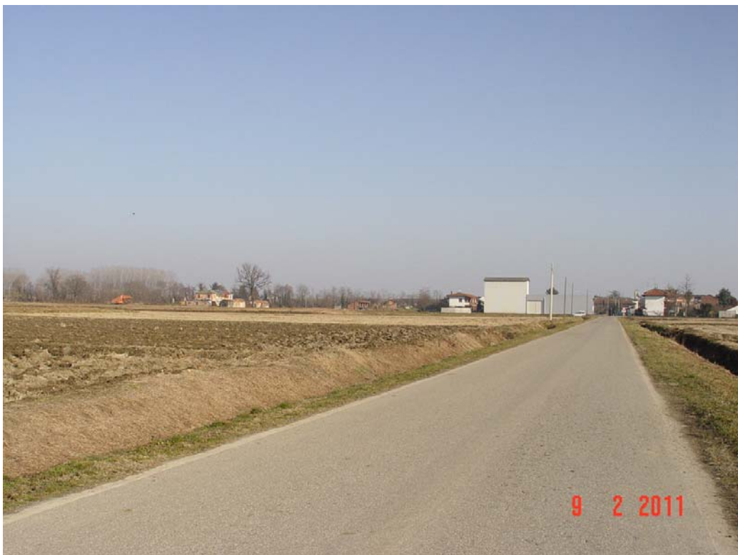
Vista delle aree in Greggio interessate dalla realizzazione del nuovo serbatoio pensile e della viabilità esistente interessata dalla posa della tubazione primaria
