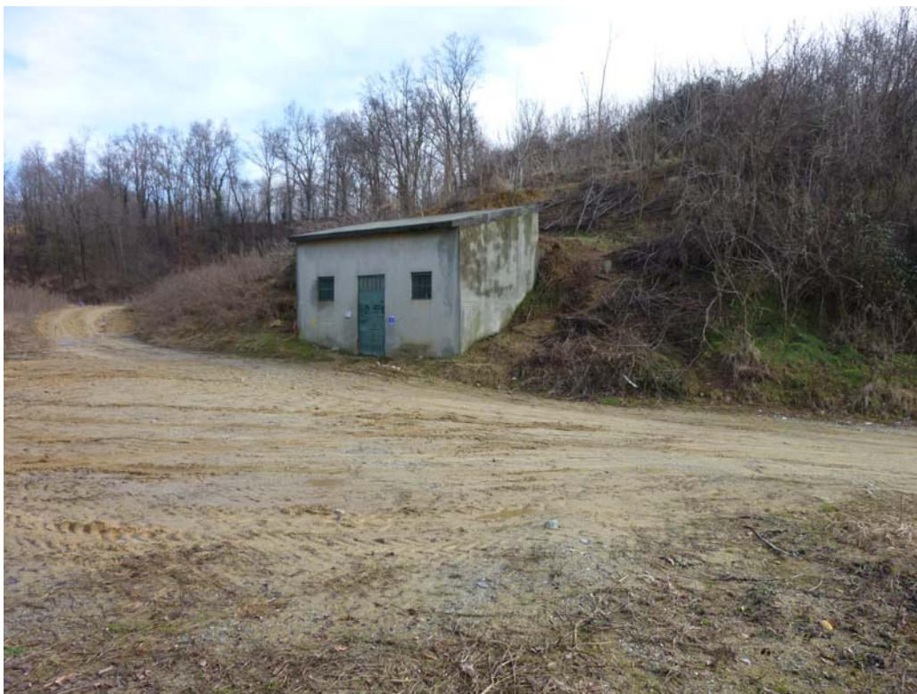
Vista delle aree in Quaregna interessate dall'ampliamento delle vasche di accumulo
