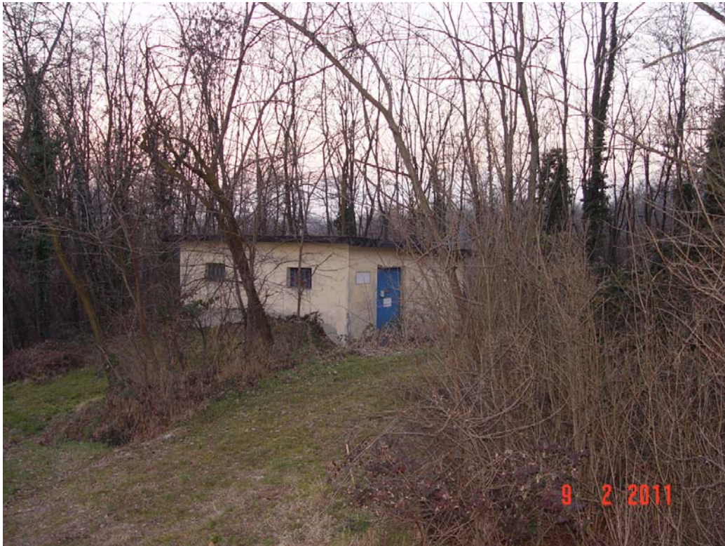
Vista delle aree in Brusnengo (Madonna degli Angeli) interessate dall'ampliamento delle vasche di accumulo
