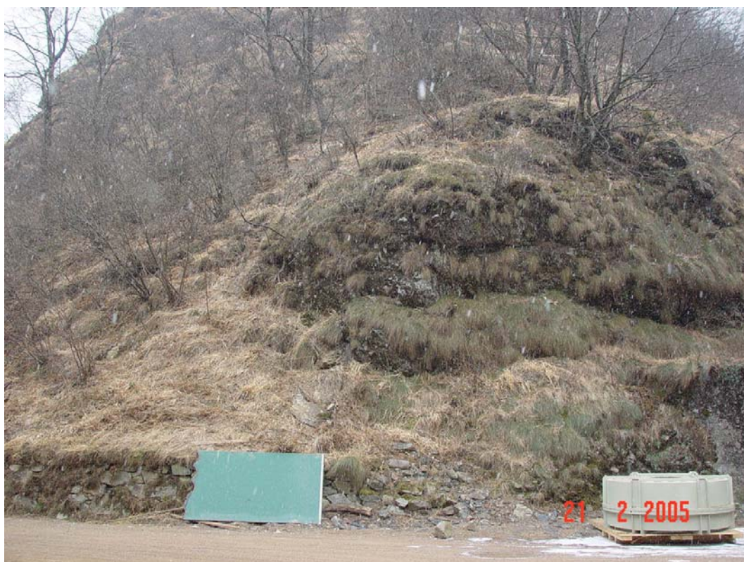
Punto d'imbocco della nuova galleria di derivazione
