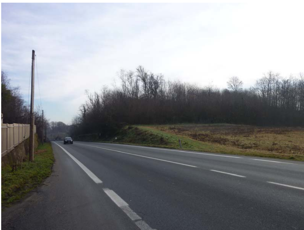
Vista delle aree in Dorzano interessate dalla realizzazione della centrale idroelettrica e dall'impianto di potabilizzazione
