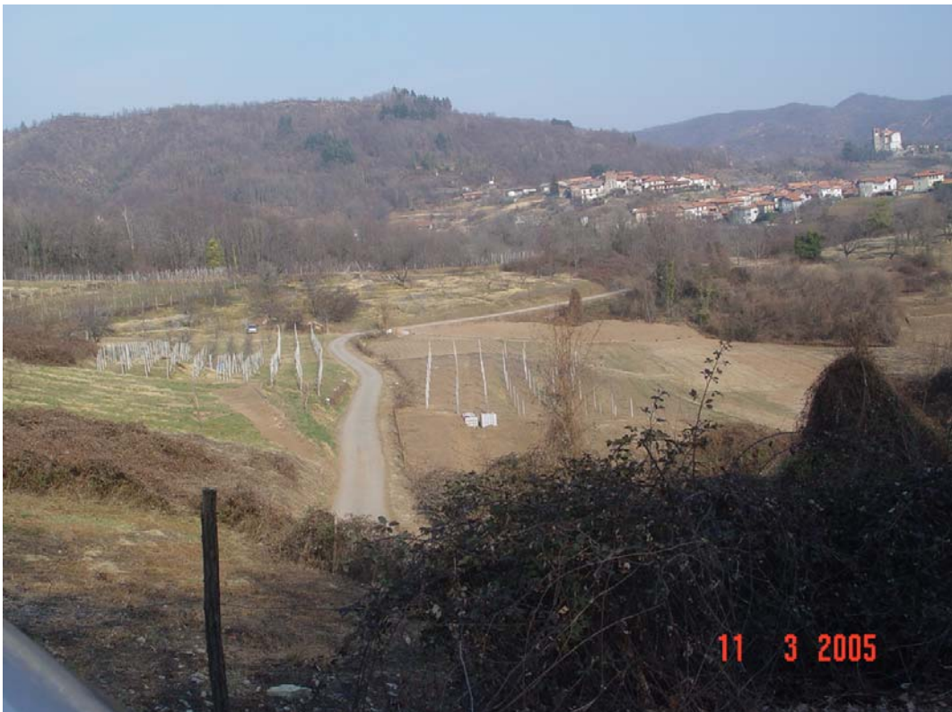
Vista delle aree nella zona di Roasio interessate dalla posa della condotta
