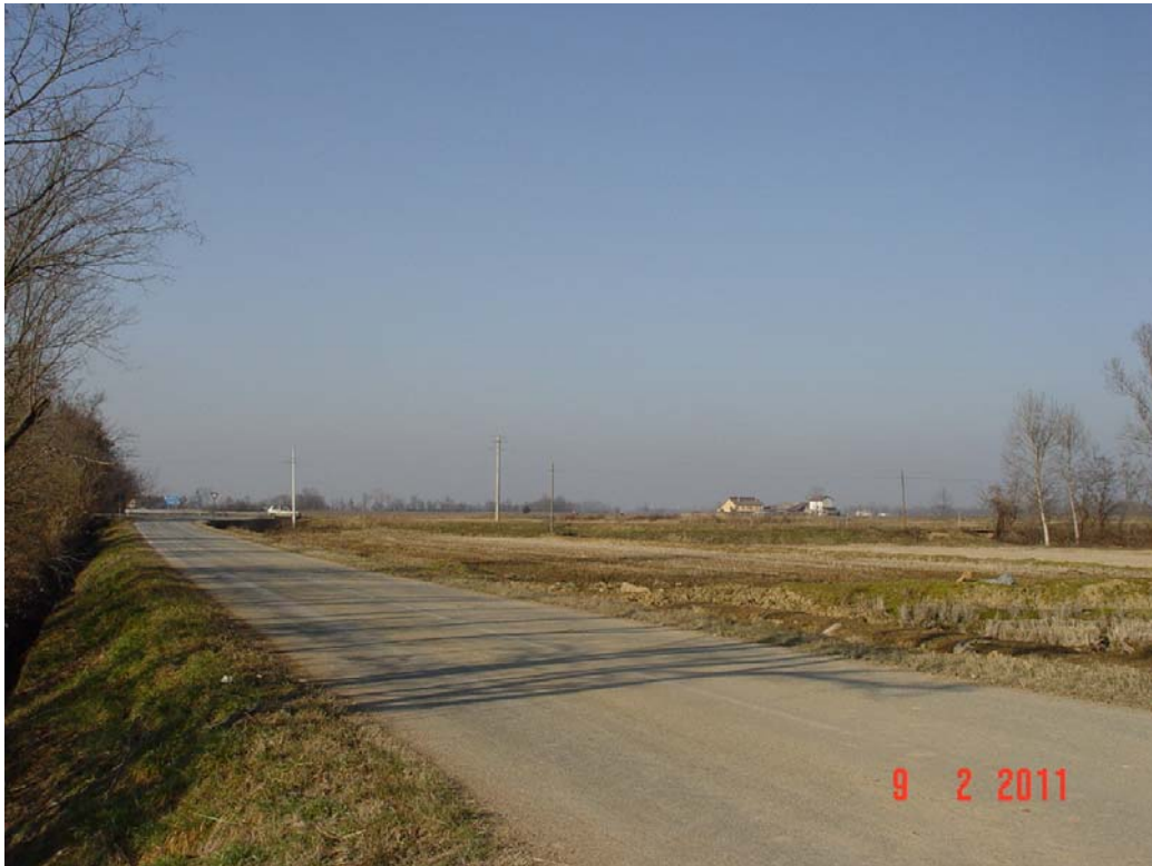
Vista delle aree in San Giacomo V.se interessate dalla realizzazione del nuovo serbatoio pensile e della viabilità esistente interessata dalla posa della tubazione primaria
