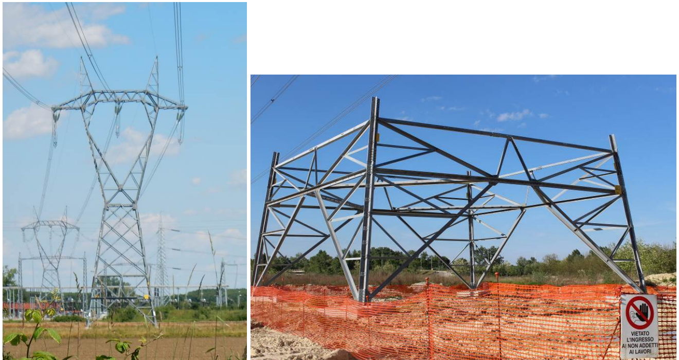
Figura 4.1. Esempio della base di un sostegno reticolare a traliccio
