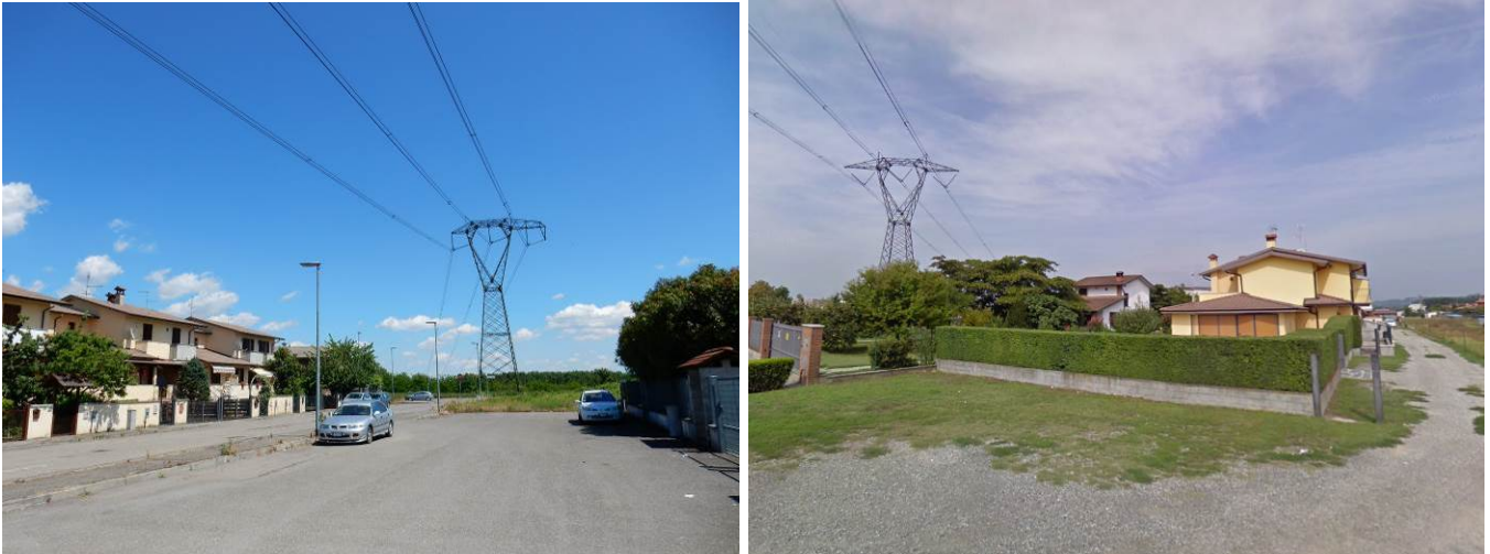
Figura 2.36. Linea ad alta tensione esistente in prossimità delle lottizzazioni di Via Carlo Porrini ( a sin ) e di Via Paolo Borsellino ( a dx ) a Chignolo Po [© Google Maps]
