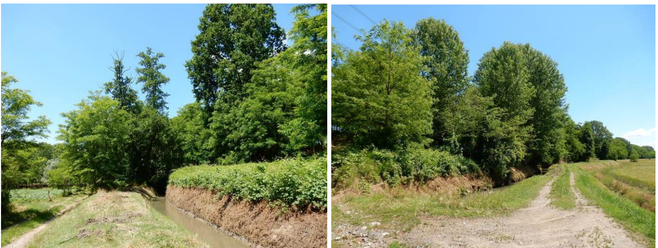
Figura 2.41. Particolari della fascia boscata con canale di scolo in prossimità del sostegno n. 061
