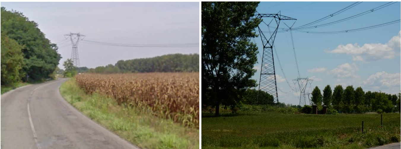
Figura 2.37. Linea ad alta tensione esistente che affianca la SP 32 ( a sin ) [© Google Maps] e interessa un'area boscata in prossimità dell'intersecazione con la SP 234 ( a dx )
