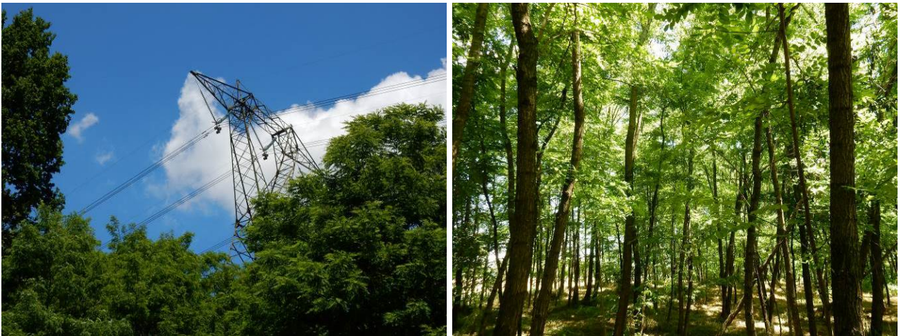
Figura 2.40. Linea ad alta tensione esistente con particolare del sostegno n. 061 (a sin) e caratterizzazione del sottobosco (a dx)
