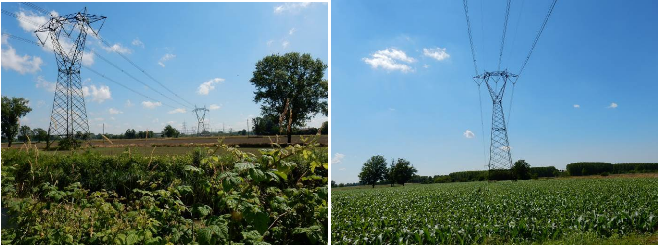
Figura 2.34. Linea ad alta tensione esistente Lacchiarella – Chignolo Po che attraversa alcuni campi con presenza di vegetazione ripariale ai margini ( a sin ) e un campo a mais con un pioppeto d'impianto sullo sfondo ( a dx )
