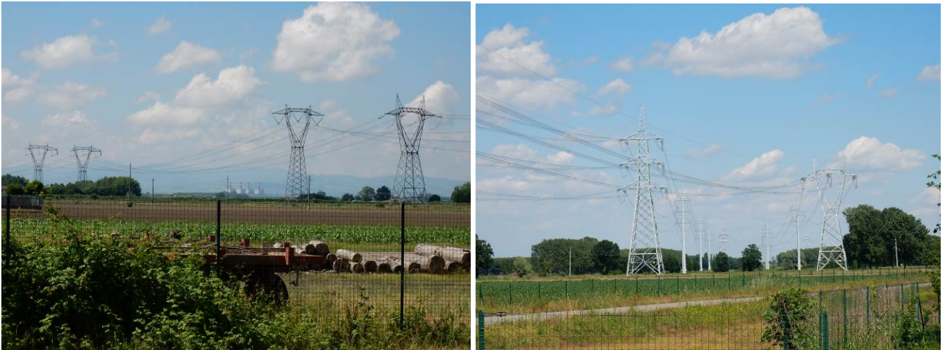
Figura 2.32. Linea ad alta tensione esistente La Casella – Chignolo Po e sullo sfondo la centrale termoelettrica “Amaldi” in Comune di Castel San Giovanni (a sin) e linea ad alta tensione esistente Chignolo Po – Maleo (a dx)
