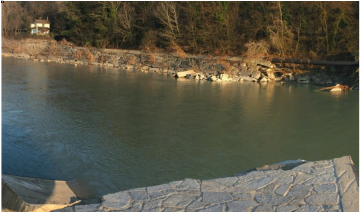
La scogliera e l'edificio di guardiania in sponda destra
