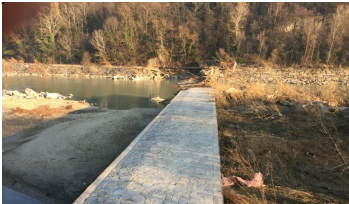
Il coronamento della traversa e la scogliera in sponda destra
