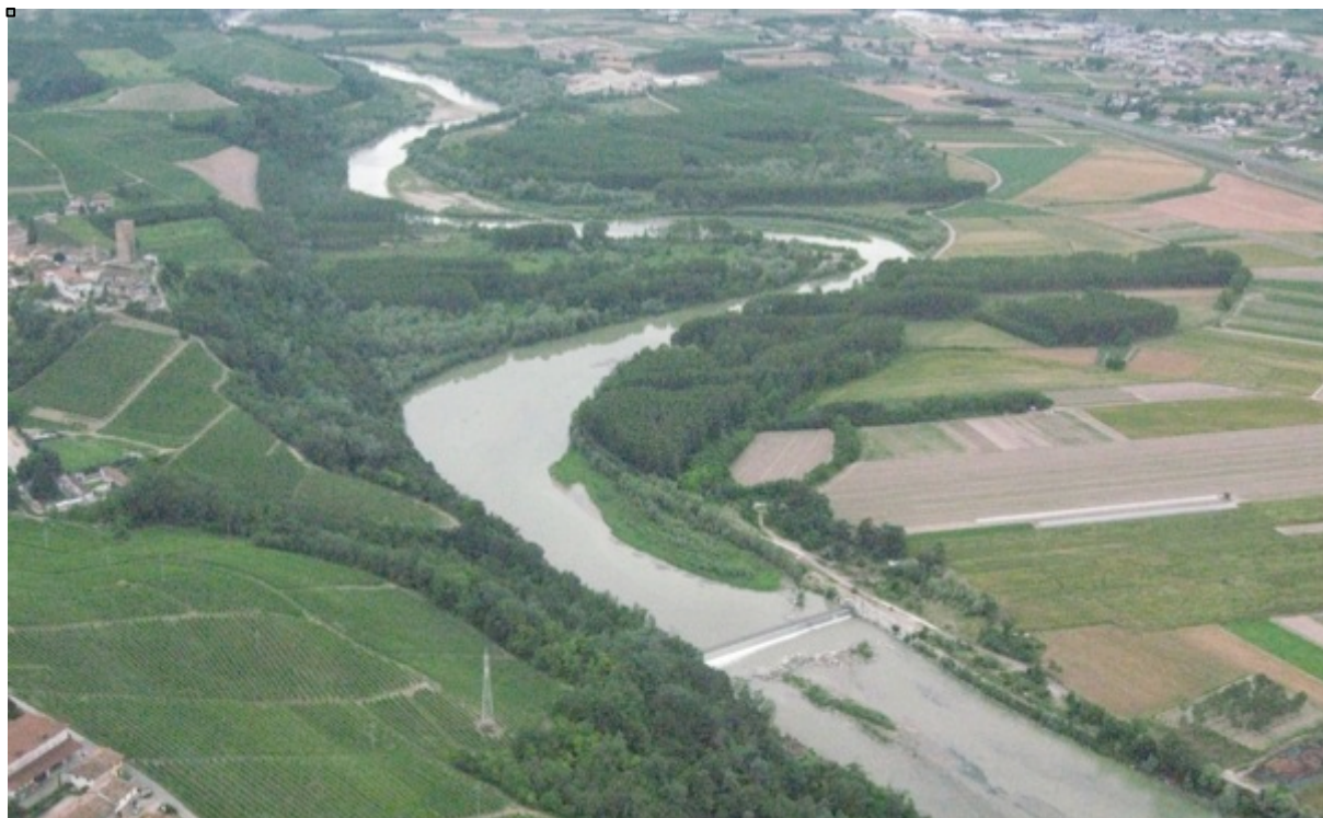
Foto Capellino da aereo con traversa efficiente - 2006
