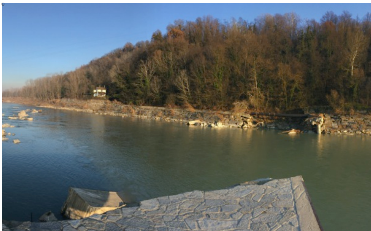
Scogliera in sponda destra e edificio di guardiania del Canale San Marzano
