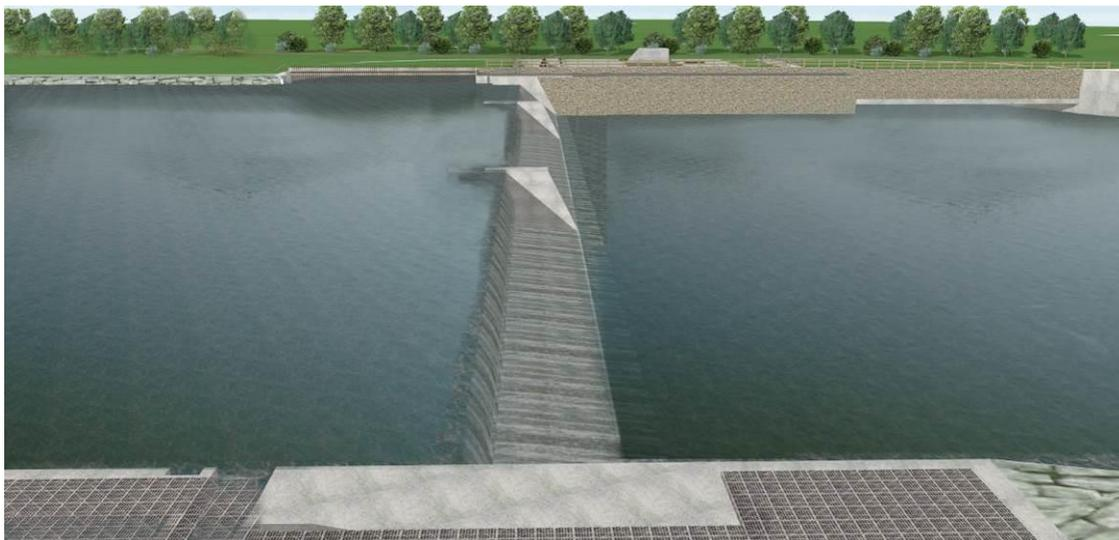
*Foto 44: vista di progetto del Fiume Tanaro dalla sponda destra orografica i corrispondenza dello sbarramento in progetto e sullo sfondo l'impianto di produzione idroelettrica con a sinistra l'imbocco dell'opera di presa e a destra lo sbocco dell'opera di restituzione.*
