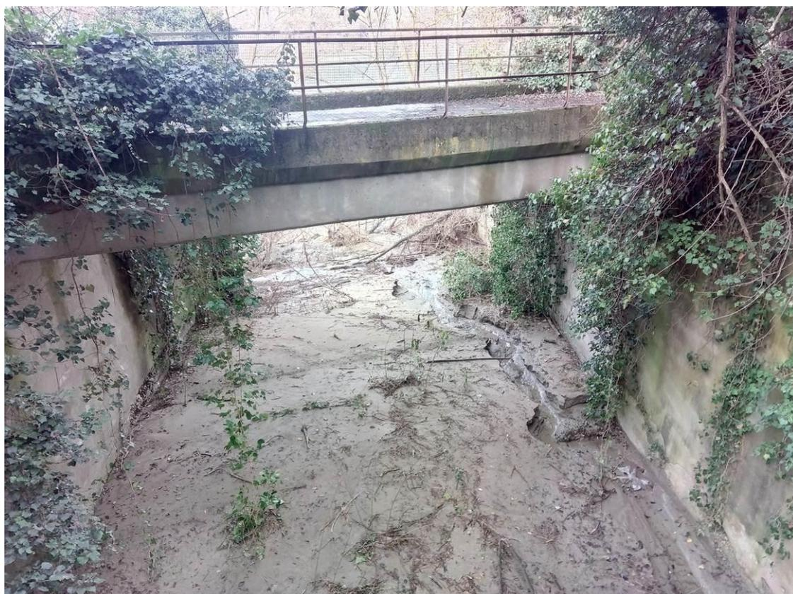
*Foto 10: vista dello scaricatore di fondo e di troppo pieno della vasca di sedimentazione del canale irriguo San Marzano*
