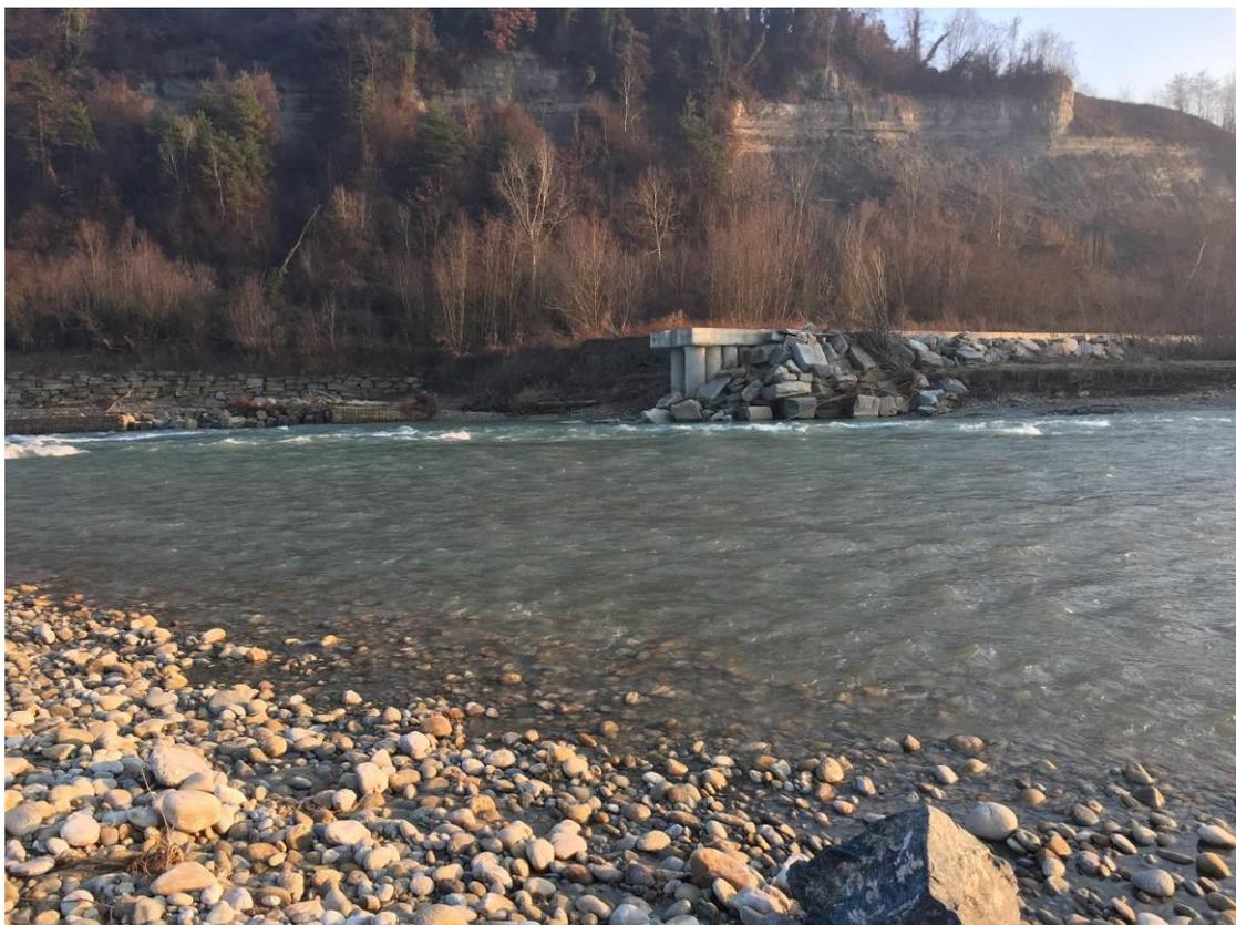
*Foto 7: vista dell'alveo del Fiume Tanaro con pennello fluviale realizzato nel 2011 ai piedi della collina nel progetto di consolidamento della Rocca di Barbaresco*
