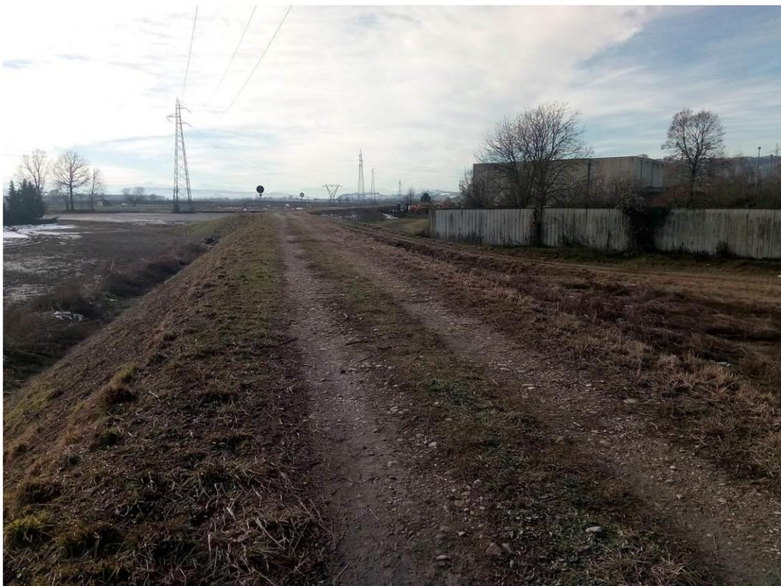
*Foto 17: vista dell'argine della fascia B del PAI a protezione dell'area industriale di Castagnito*
