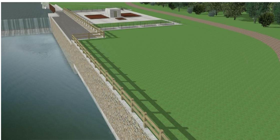
*Foto 45: vista di progetto della sponda sinistra del Fiume Tanaro presso l'opera di restituzione con in primo piano la rifinitura del muro di sponda con pietra di langa e delimitazione della scala di rimonta ittiofauna tramite steccato in legno. Sullo sfondo in evidenza le botole di accesso all'impianto.*
