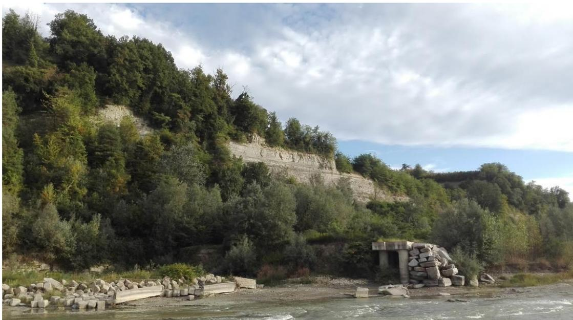
*Foto 23: vista dell'alveo del Fiume Tanaro con pennello fluviale a valle della collina di Barbaresco*
