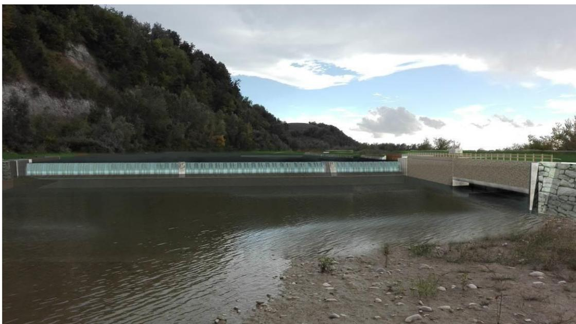
*Foto 43: vista di progetto del Fiume Tanaro a valle dell'area dove è previsto l'impianto con fotoinserimento dello sbarramento, della scala di rimonta ittiofauna in sponda sinistra e dell'opera di restituzione.*
