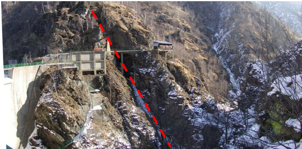
Foto 5.12 – Le faglie presenti sulla spalla sinistra della diga esistente
