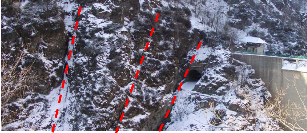
Foto 5.11 – Le faglie presenti sulla spalla destra della diga esistente
