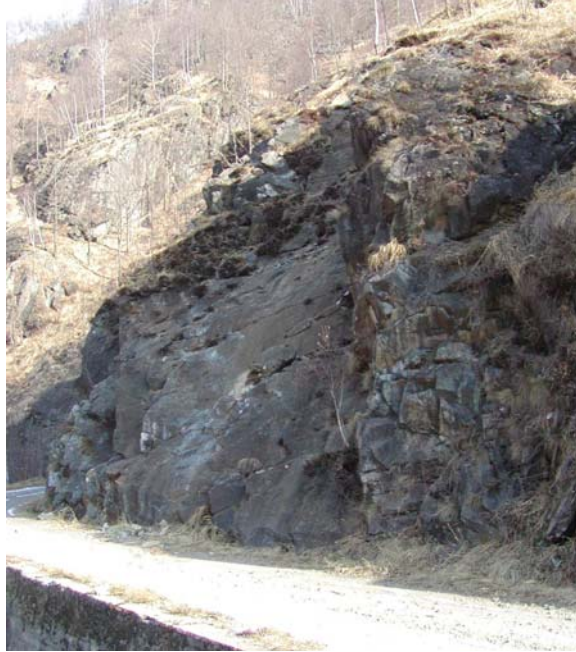
Foto 6.2 – Scivolamento di un cuneo di roccia sulla stradina di accesso alla diga
