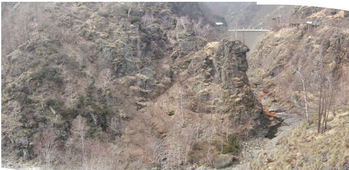
Foto 5.3– Lo sperone roccioso in sponda destra
