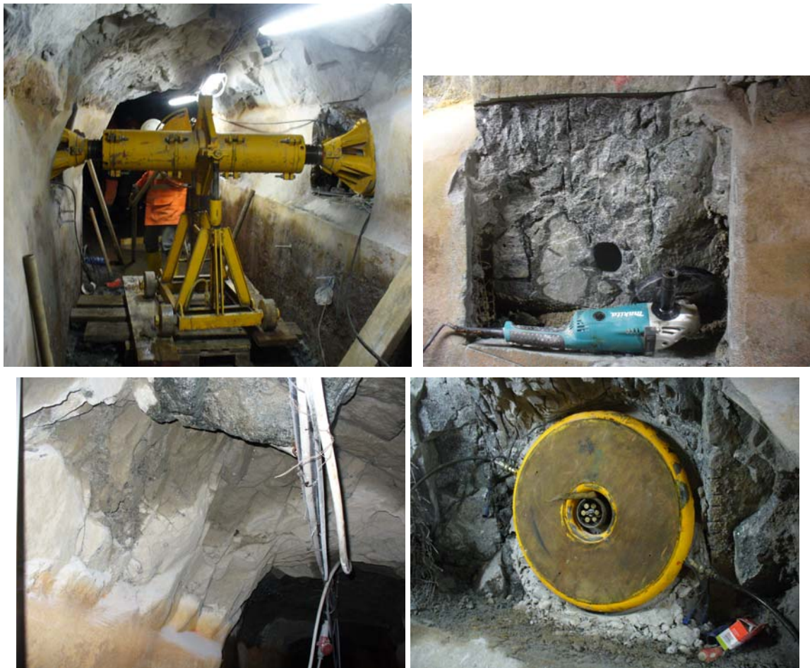
Foto 6.3 – Alcune foto della prova su piastra in cunicolo
