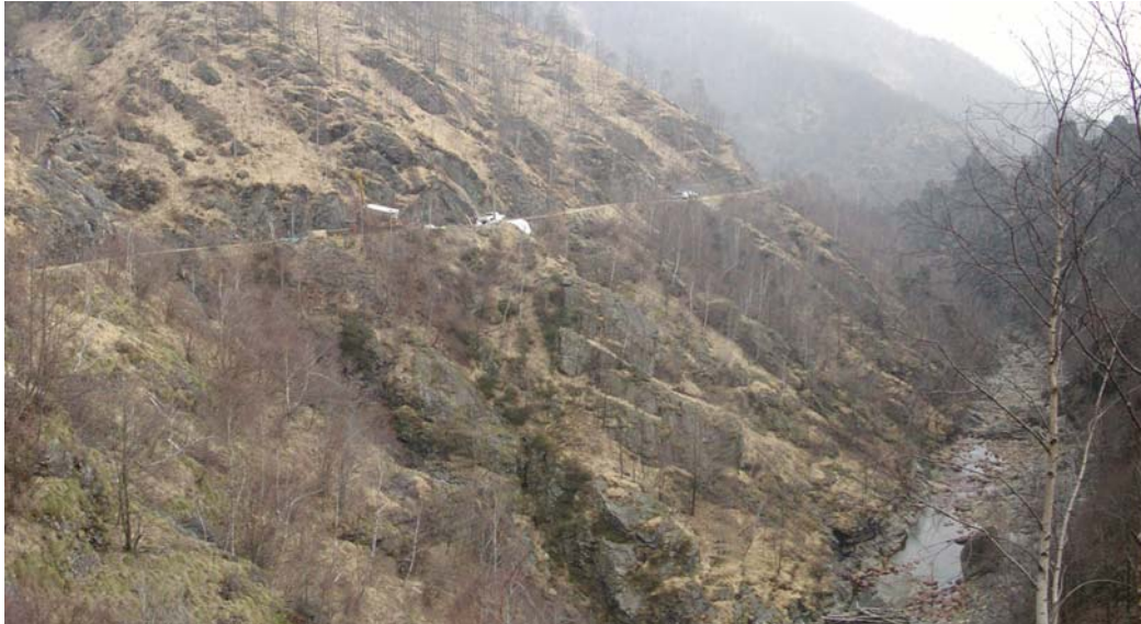
Foto 5.6– Versante sinistro in corrispondenza del sito della nuova diga
