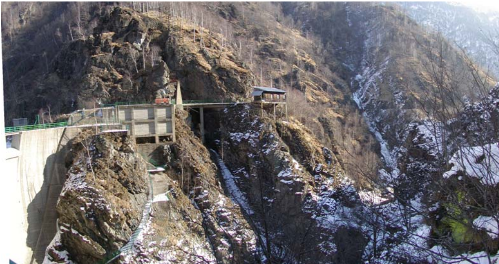
Foto 5.2 – Sponda sinistra poco a valle della diga esistente
