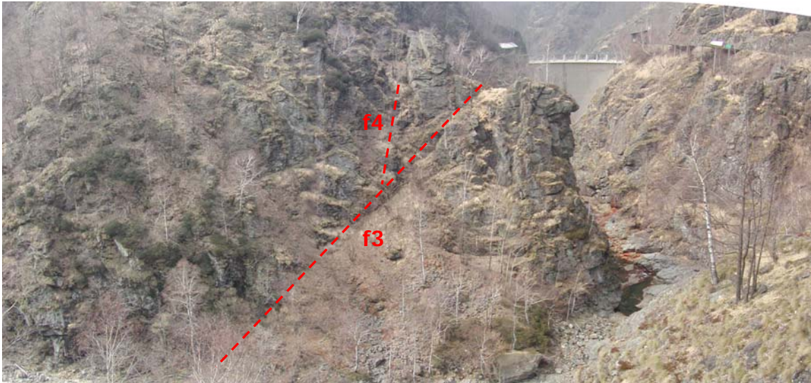
Foto 7.1– Lo sperone roccioso in sponda destra con i probabili allineamenti tettonici individuati
