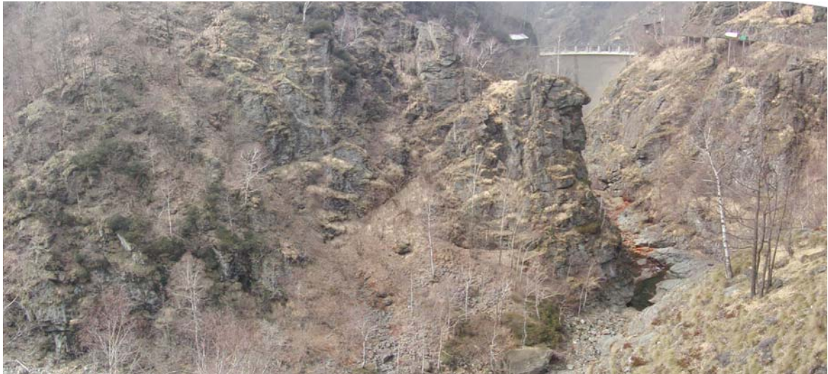
Fig. 4-1 Lo sperone roccioso in sponda destra
