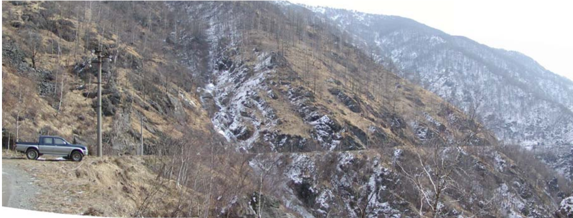
Fig. 4-3 Versante sinistro poco a monte del sito della nuova diga
