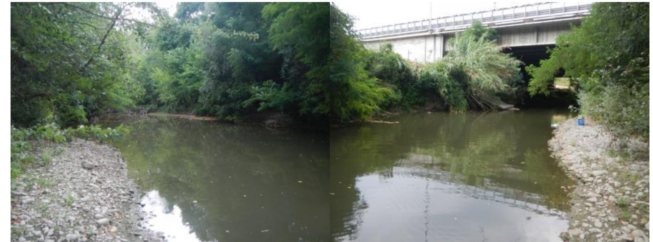
Figura 4-2. Torrente Savena: tratto 1
