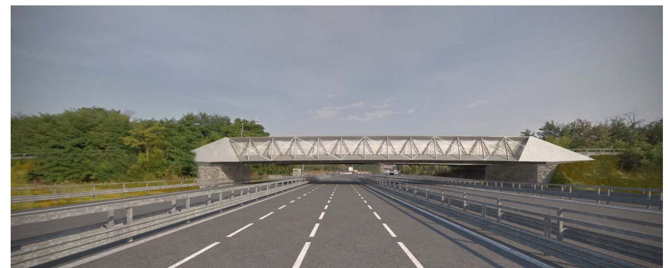
Figura 9-27 Cavalcavia Via Benazza e Via del Terrapieno
