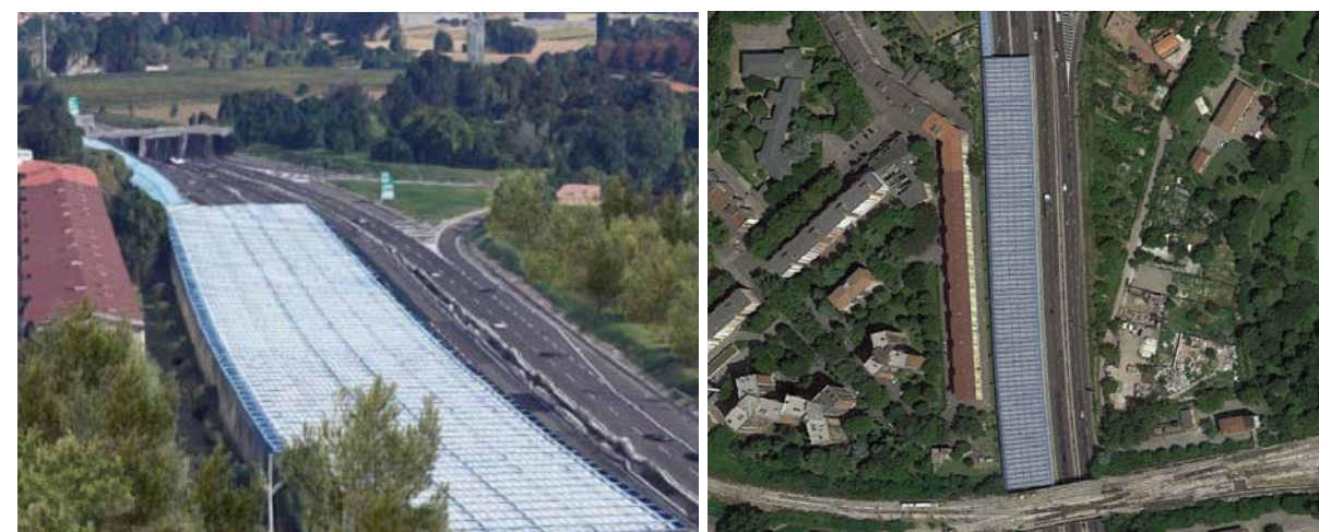
Figura 3-7 Galleria fonica "San Donnino" presente lungo la Tangenziale di Bologna
