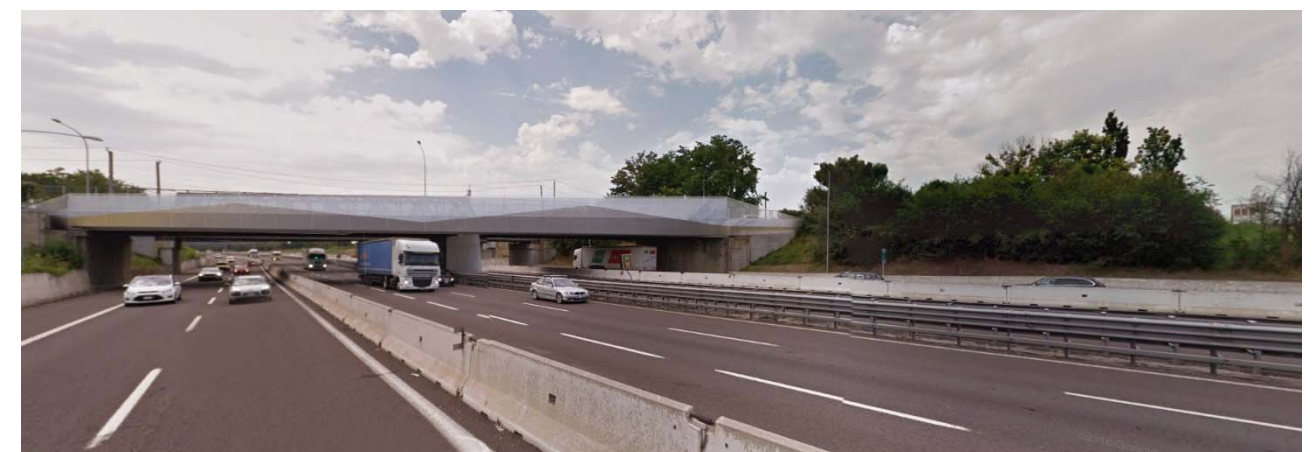
Figura 9-28 Cavalcavia Via Cristoforo Colombo
