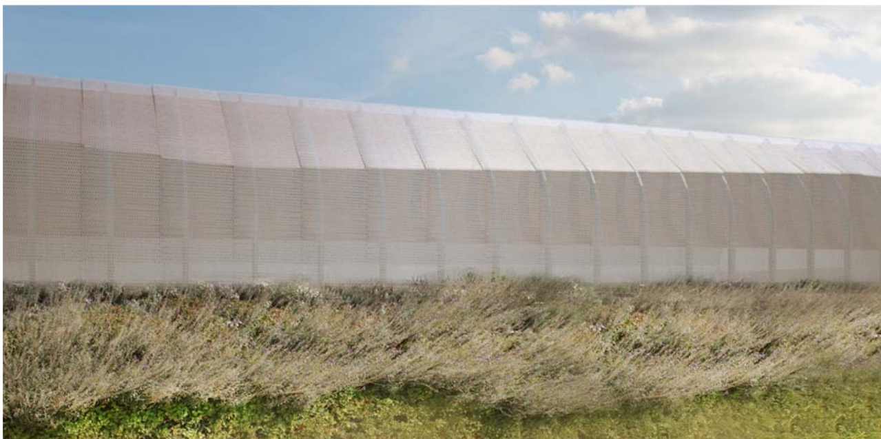
Figura 4-12. Barriere acustiche – Vista esterna
