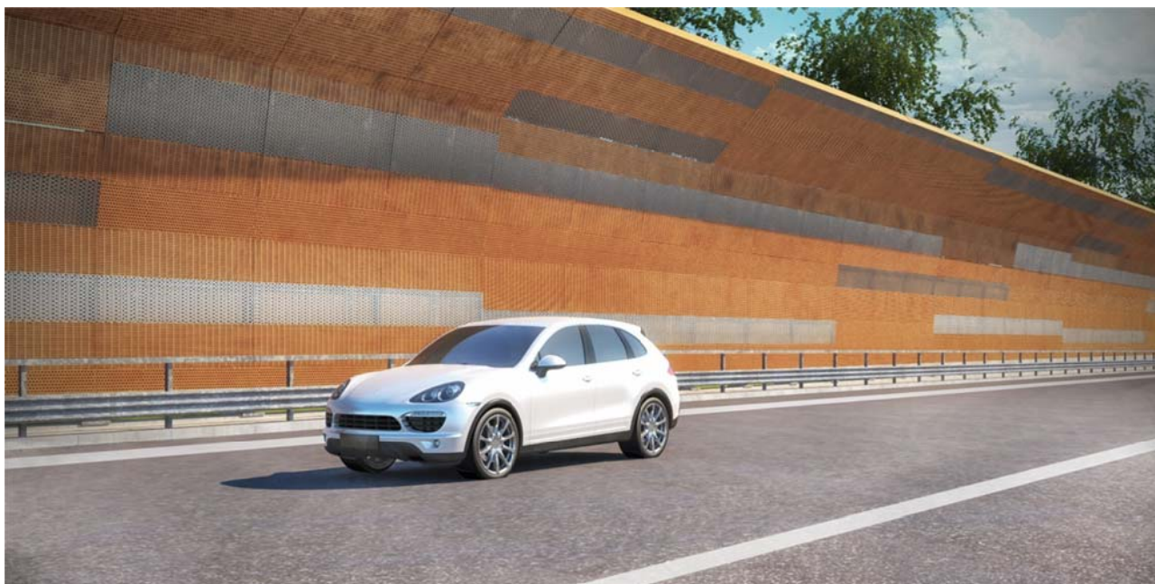
Figura 4-13. Barriere acustiche – Vista interna dall'autostrada
