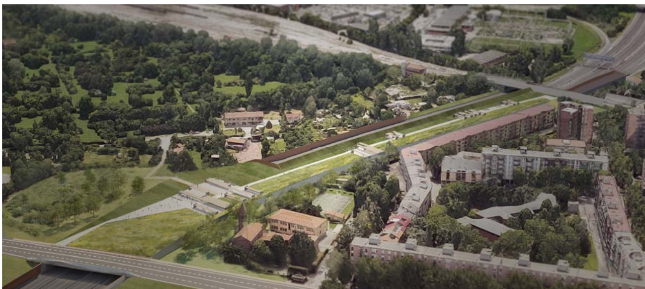
Figura 4-1. Galleria Fonica San Donnino – Vista generale
