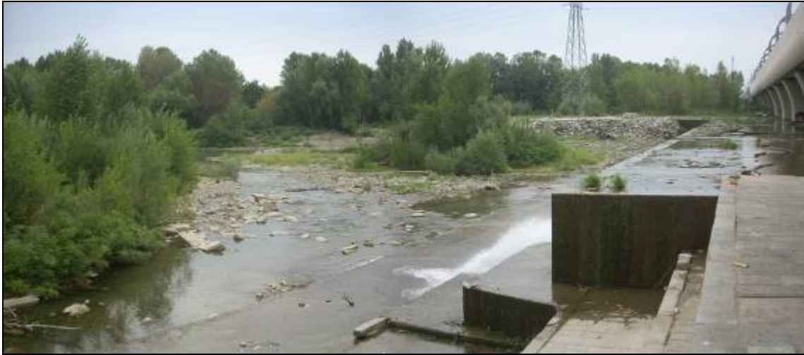
Fig.29- Alveo attuale del F. Reno: depositi alluvionali recenti con uno spessore 1 m; sulla destra soglie idrauliche a protezione dell'impalcato del viadotto ferroviario.
