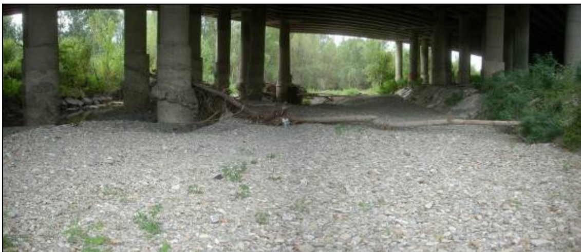
Fig.34 - Alveo del F. Reno panoramica verso monte: depositi alluvionali recenti con uno spessore 1,5 m; si notano porzioni residuali relative alle opere di protezione sui plinti del sistema tangenziale in esercizio.
