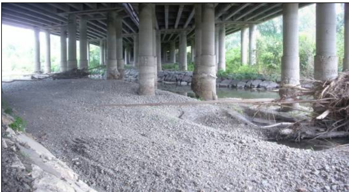
Fig.30- Alveo del F. Reno: depositi alluvionali recenti con uno spessore 1 m; sono presenti scogliere artificiali di 1.5 m di altezza a protezione dei plinti dell'impalcato del sistema tangenziale in esercizio.
