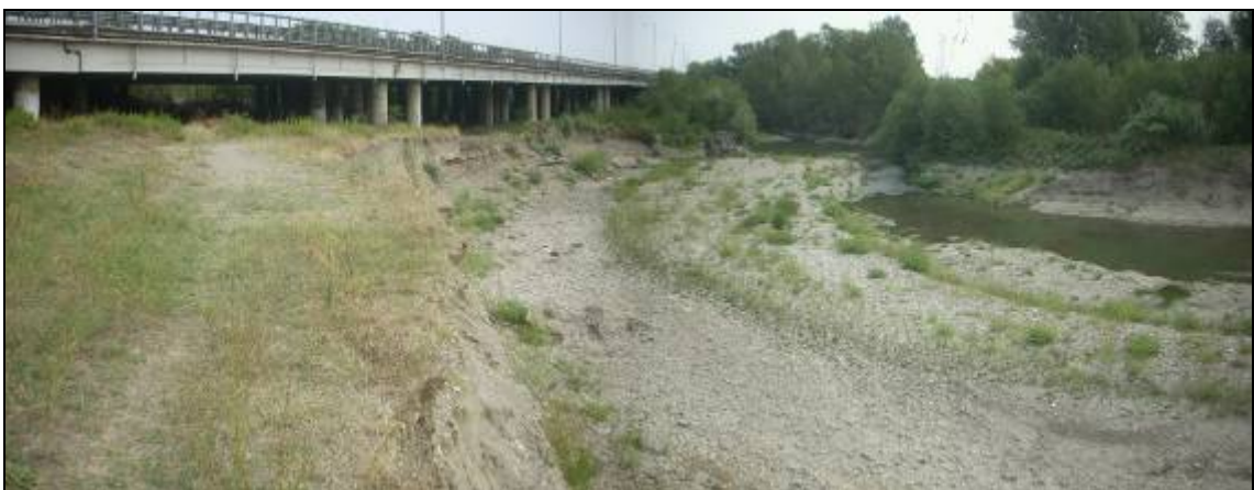
Fig.26 – Alveo attuale del F. Reno (panoramica verso valle): a sinistra scarpate fluviali di altezza variabile da 3÷5 m; in secondo piano l'impalcato del sistema tangenziale in esercizio.
