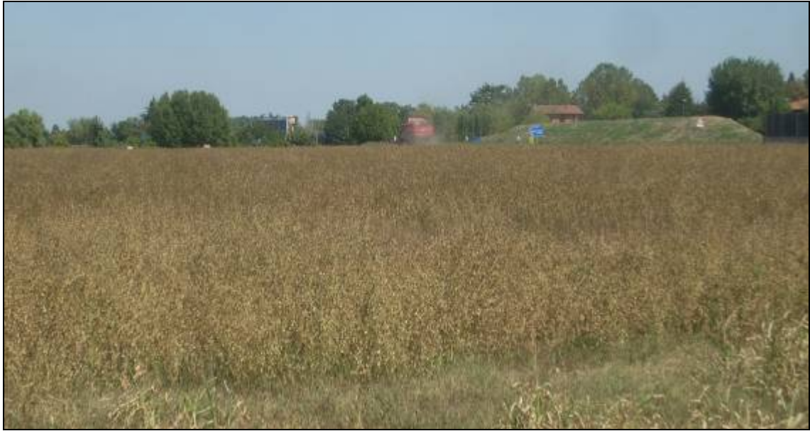
Fig.53 – Rilevato artificiale in località Case Alte, con altezza variabile da 3÷5 m con funzione di mitigazione acustica.
