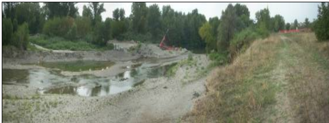
Fig.27 – Alveo attuale del F. Reno (panoramica verso monte): a destra le scarpate fluviali di altezza variabile da 3÷4 m; in secondo piano attività di movimento terra inerente alla costruzione del nuovo viadotto ferroviario.
