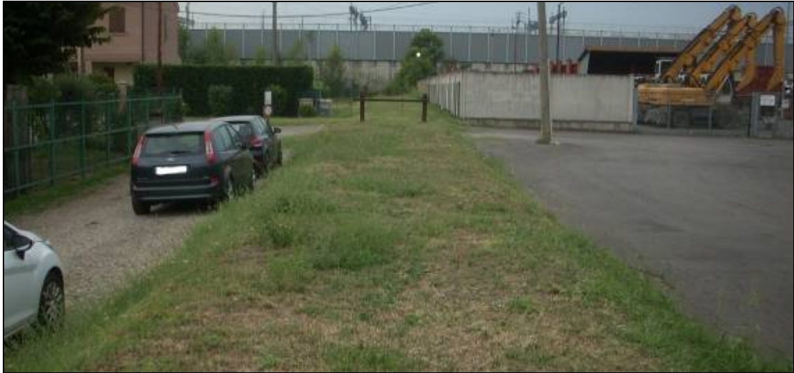
Fig.21 - Argine artificiale del F. Reno in loc. Bonora; in secondo piano l'impalcato della Tangenziale.
