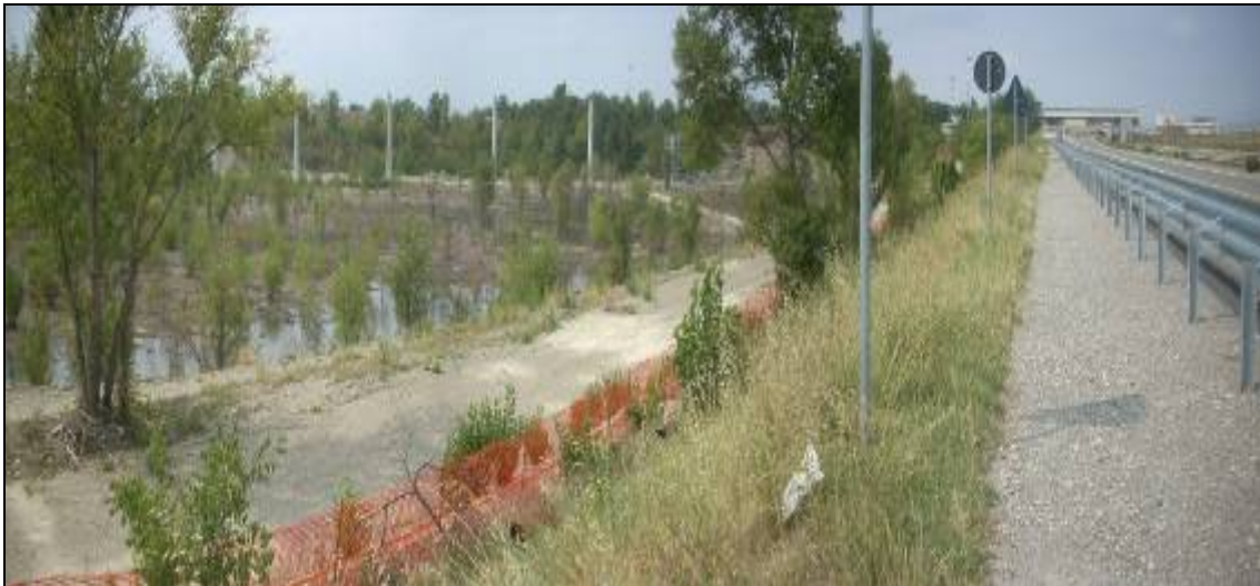
Fig. 23 - Morfologia depressa di origine antropica derivante dalle attività estrattive, attualmente occupata da ristagni d'acqua e da un viadotto ferroviario in costruzione (in foto pali verticali), a sud-ovest dell'aeroporto di Bologna.
