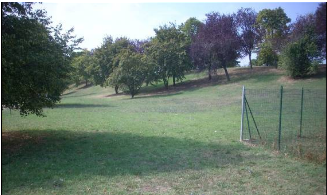
Fig.42 – Rilevato artificiale nei pressi dello svincolo di immissione su A13, altezza media da 2÷4 m circa con probabile funzione di mitigazione acustica e sede di cavidotto industriale.
