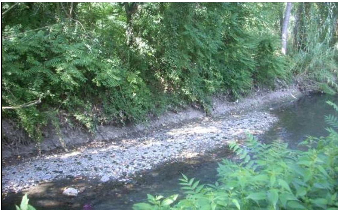
Fig. 44 – Alveo artificiale Canale Navile, depositi alluvionali recenti con uno spessore di 0.30÷0.50m.
