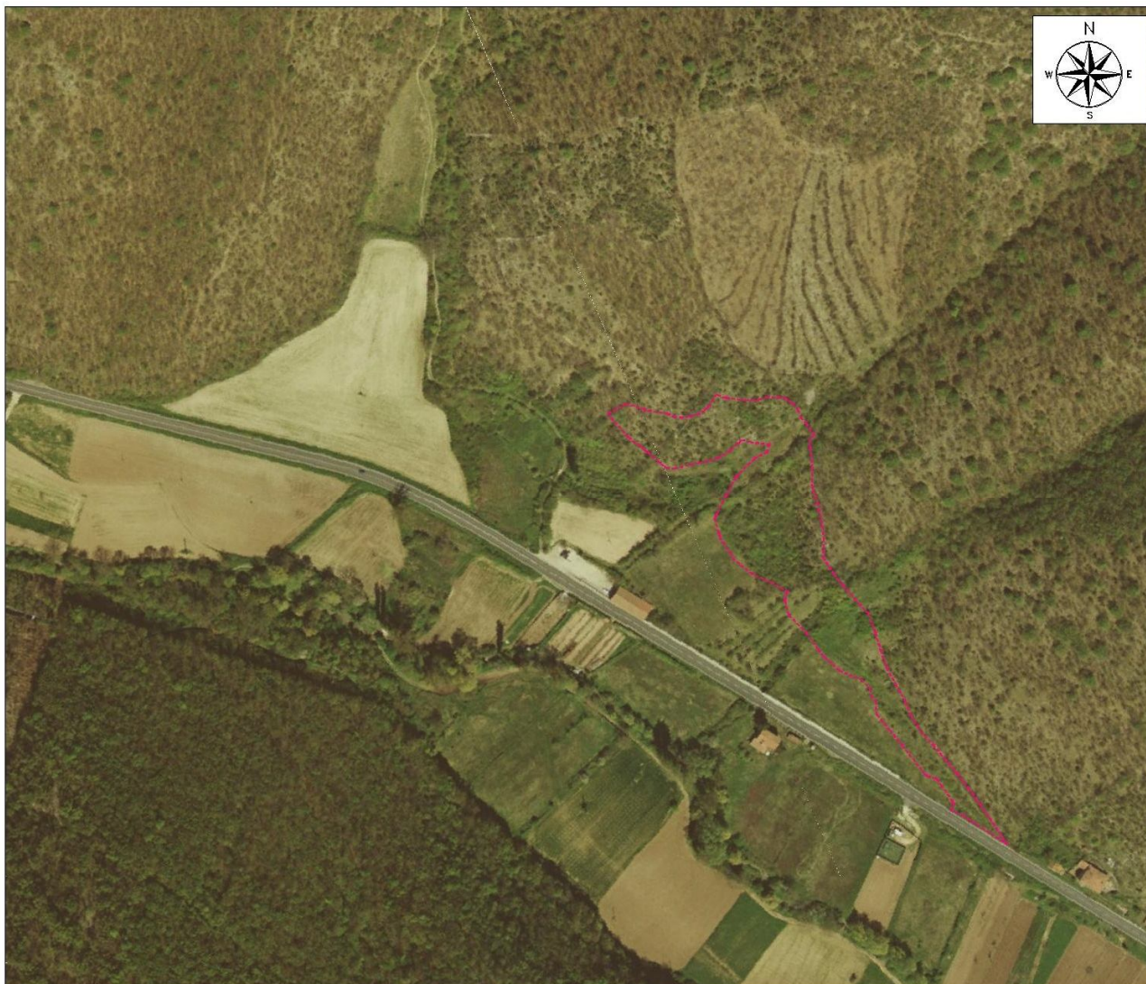
Figura 3 - Ortofoto dello stato di fatto Ante Operam della strada 8.
