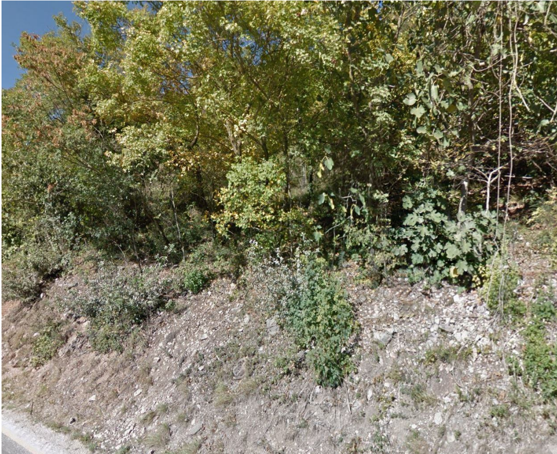
Figura 6 – Immagine dell'area della strada di cantiere Ante Operam .
