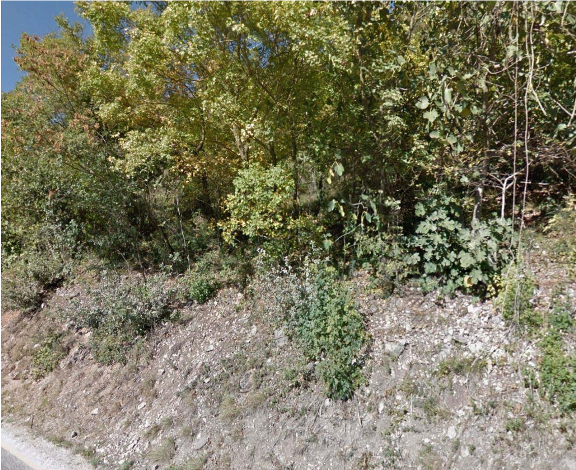
Figura 5 – Immagine dell'area della strada di cantiere Ante Operam .
