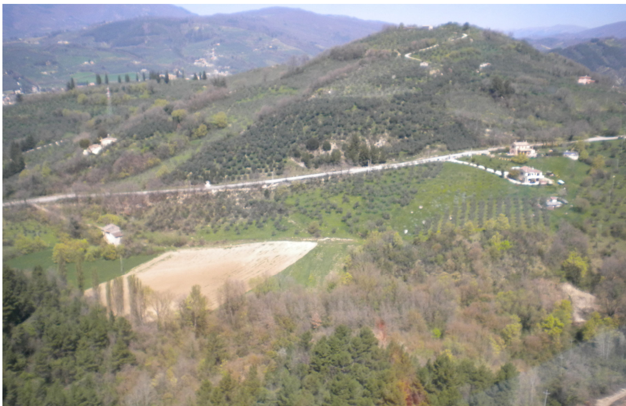
Figura 5 – Immagine dell'area della strada di cantiere Ante Operam .
