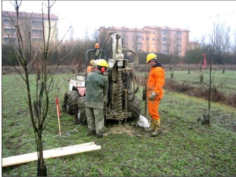
Figura n. 24: Perforatrice Limitato Impatto Ambientale (LIA)
