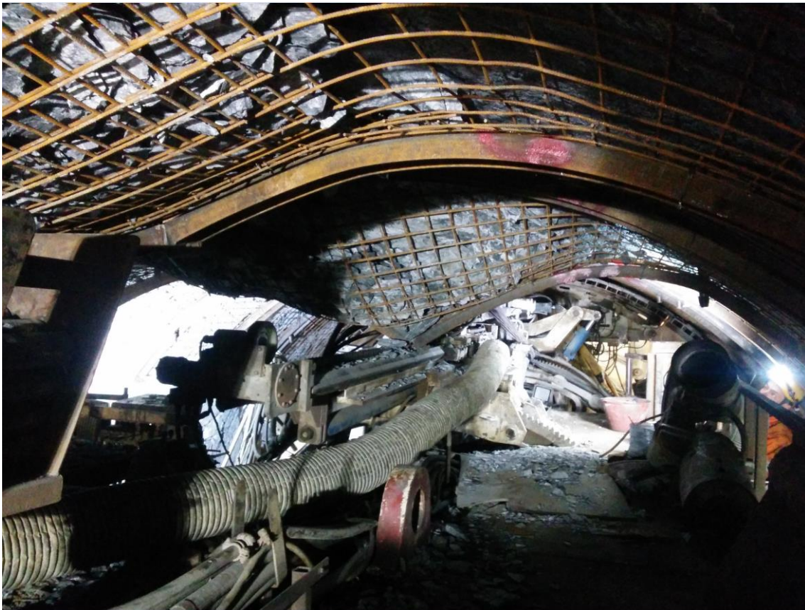
Figura 5.1 – Le conseguenze in calotta del cunicolo del fenomeno di rilascio tensionale manifestatosi a Pk 4+200
