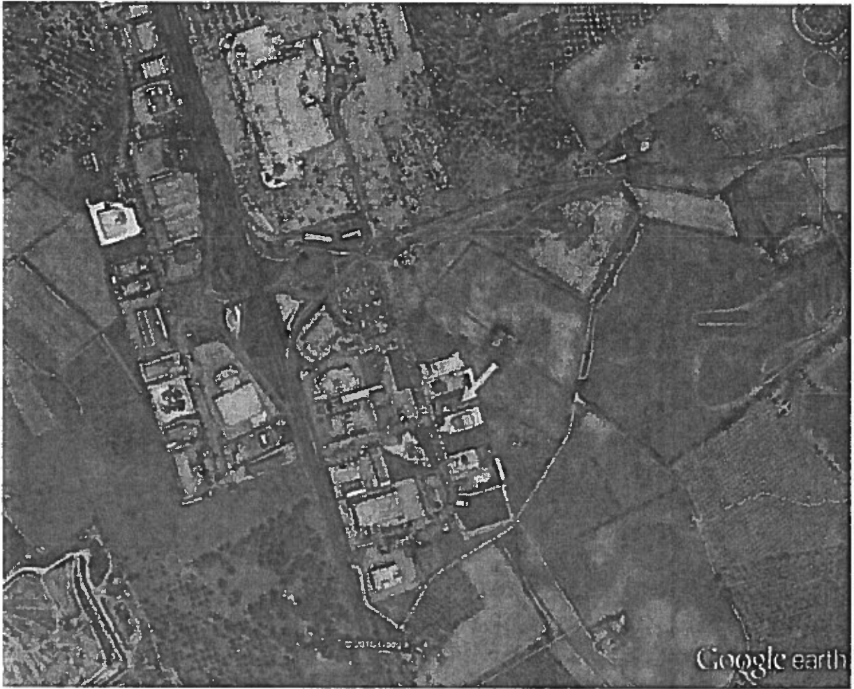
Fig. 3 – Ubicazione del sito di installazione del prototipo sperimentale
