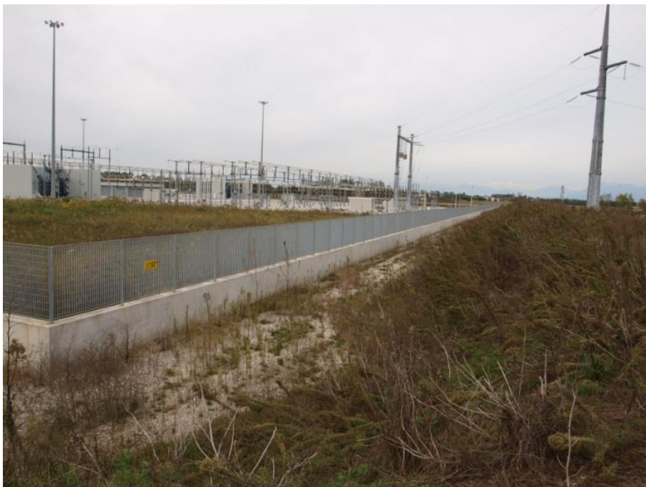
Foto 5.10 - Perimetro SE vista da terrapieno
