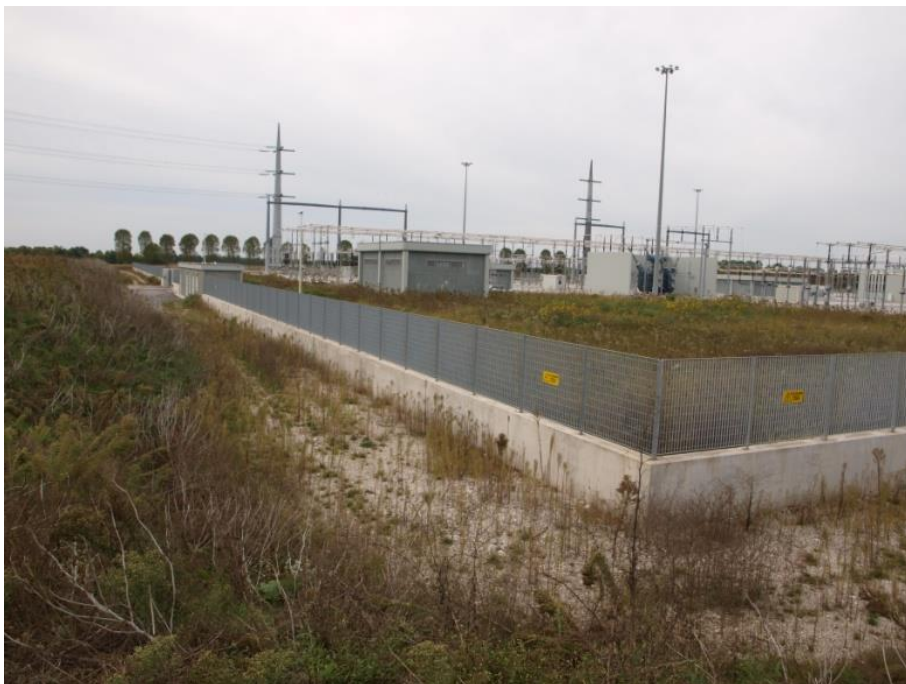
Foto 5.9 - Perimetro SE vista da terrapieno
