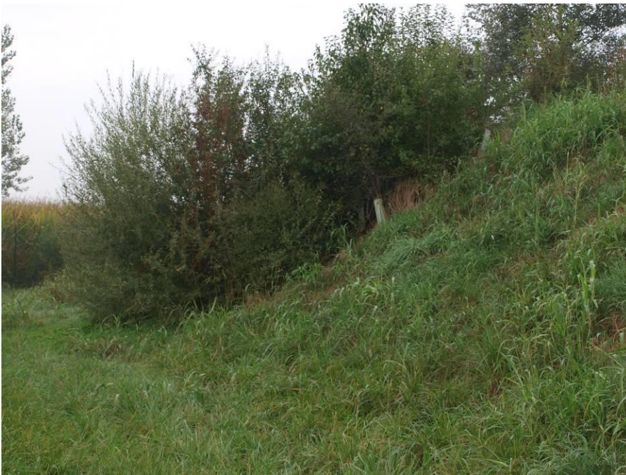
Ottimo sviluppo della crescita di arbusti su rilevato rivestito con telo pacciamante - Stazione Elettrica di Chignolo Po (PV), Foto G. Sauli, 16/09/2016 (dopo 4 anni)
