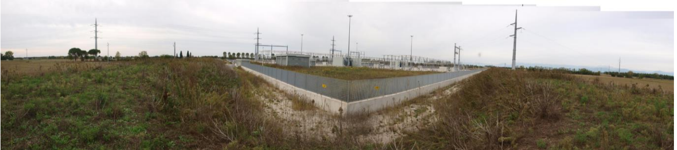
Foto 5.4 - Panoramica Nuova Stazione Elettrica
