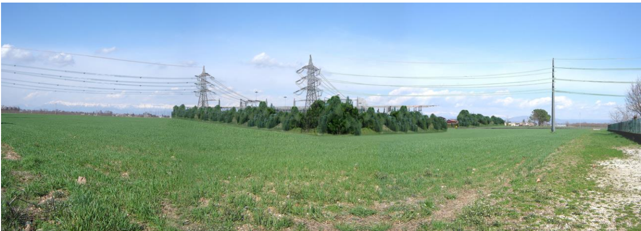
Foto 5.3 - Panoramica Fotosimulazione nuova SE e linee - progetto variante 2012 Stazione con mascheramento fascia di 40 m – (Sostegni linea monostelo / sostegni capolinea a traliccio interni alla fascia di mascheramento)
