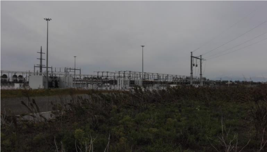
Foto 5.7 - Parte piana superiore rilevati
