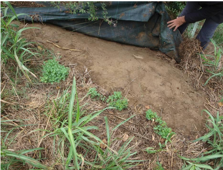
Simulazione della rimozione del telo pacciamante - Stazione Elettrica di Chignolo Po (PV), Foto G. Sauli, 16/09/2016
