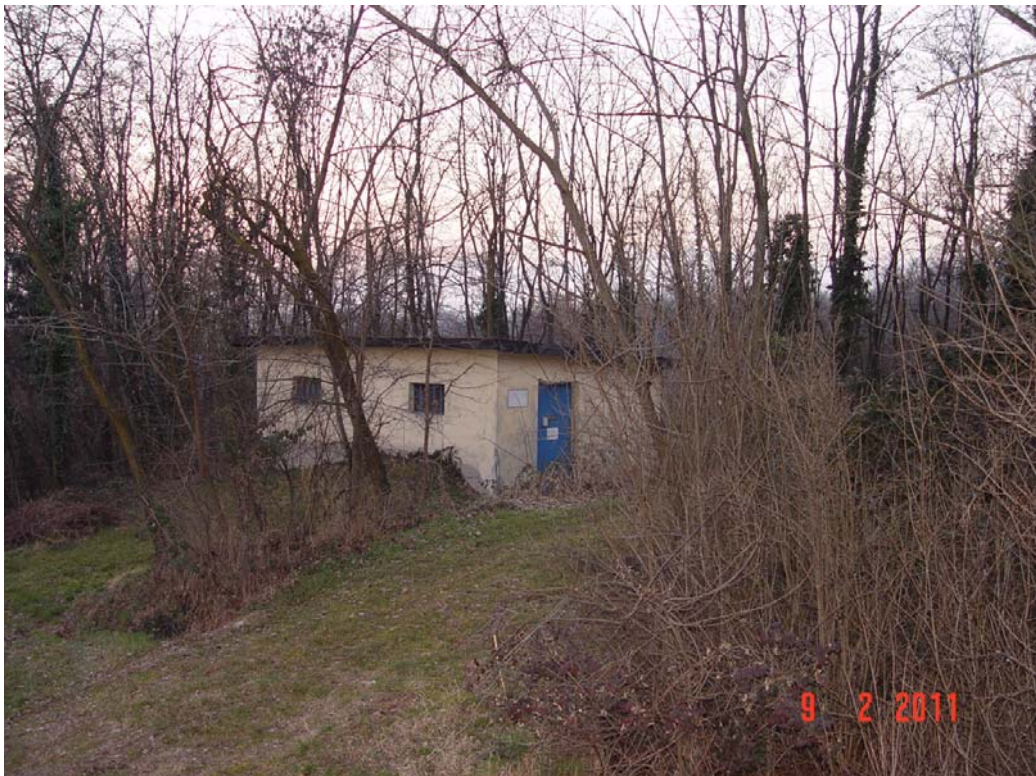
Vista delle aree in Brusnengo (Madonna degli Angeli) interessate dall'ampliamento delle vasche di accumulo
