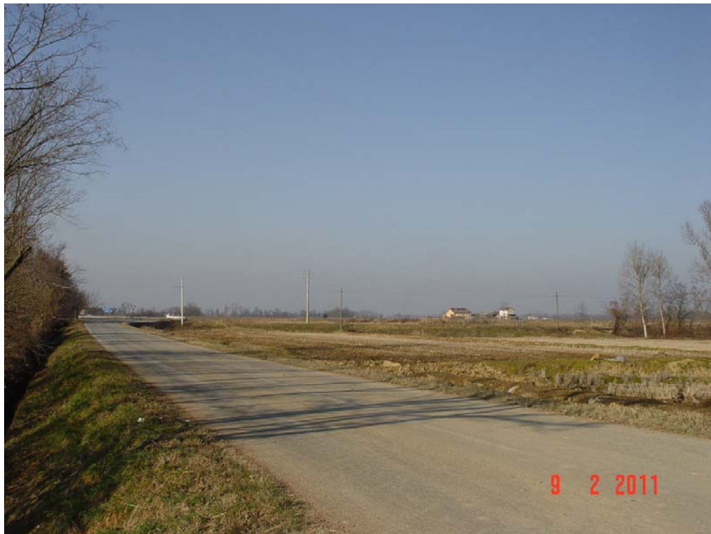
Vista delle aree in San Giacomo V.se interessate dalla realizzazione del nuovo serbatoio pensile e della viabilità esistente interessata dalla posa della tubazione primaria
