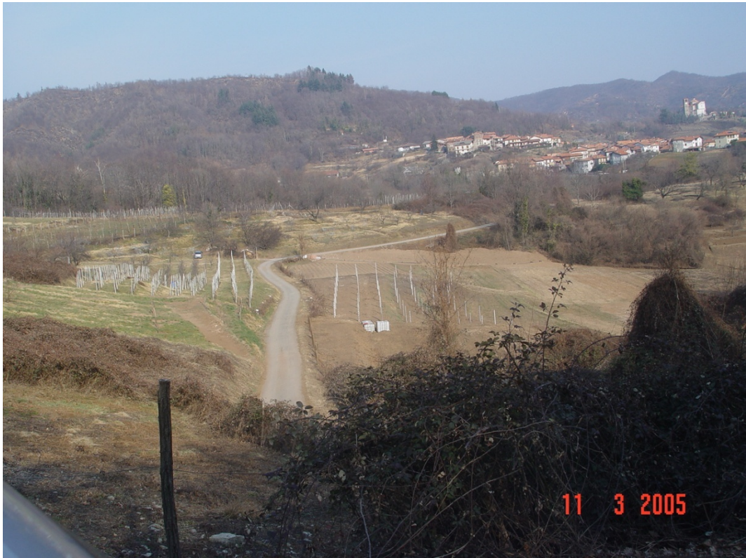
Vista delle aree nella zona di Roasio interessate dalla posa della condotta
