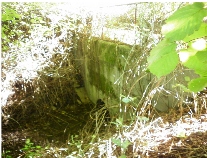
Figura 9 Roggia Abbandonata da attraversare con tubiera.
