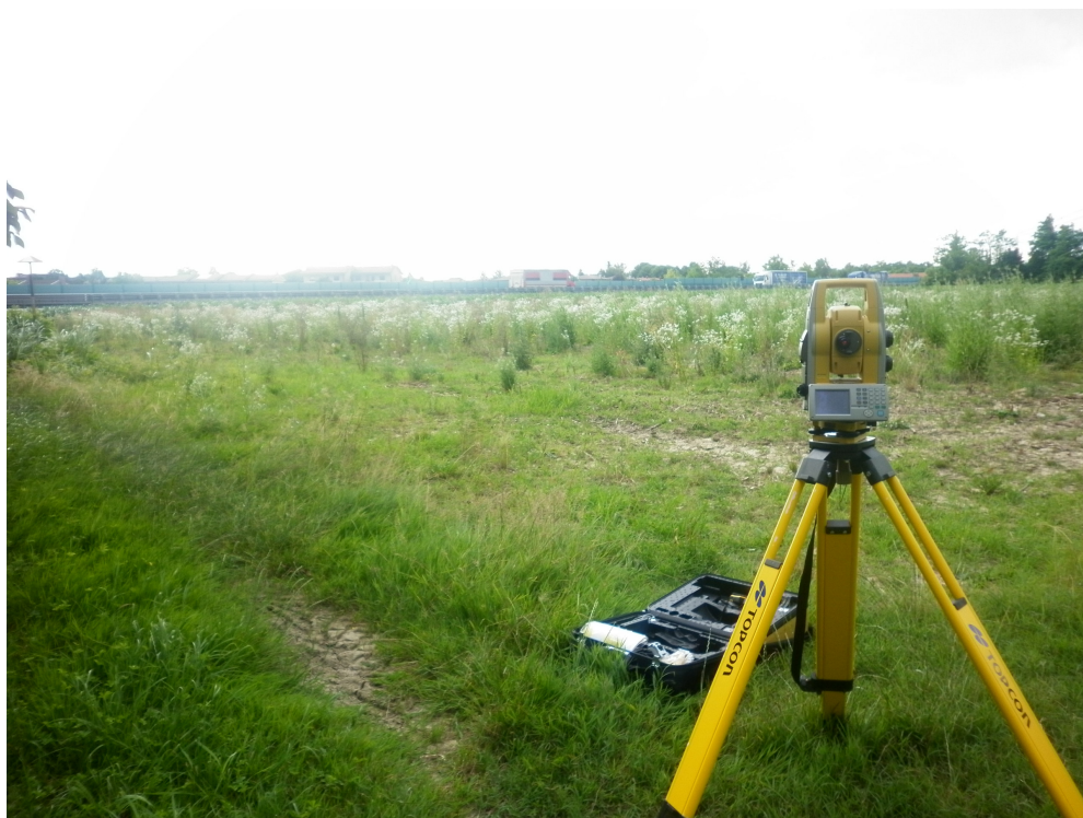
Figura 13 Area in cui verrà posta la terza buca giunti.
