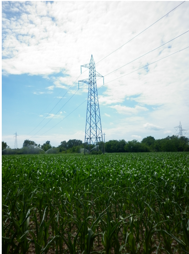
Figura 1 Attuale sostegno n° 11: area in cui inizia il tratto in cavo interrato.
