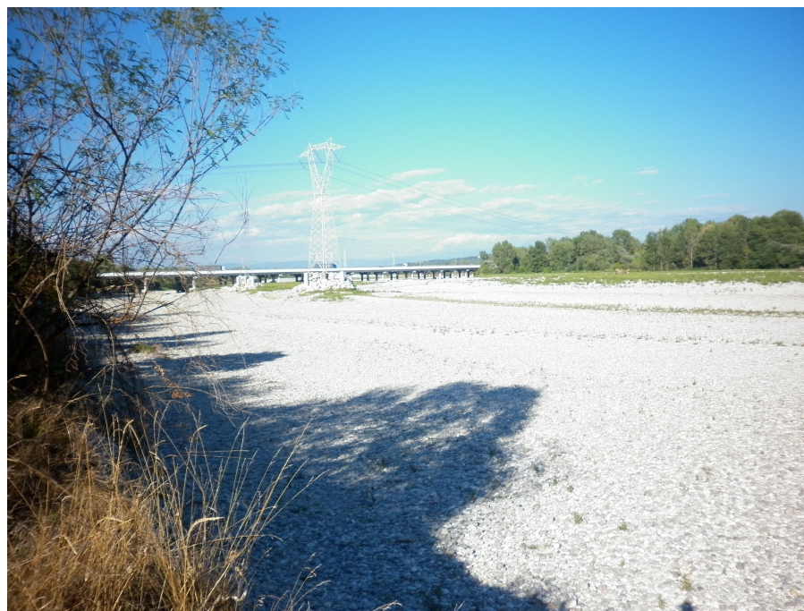
Figura 4 Alveo del fiume Isonzo.
