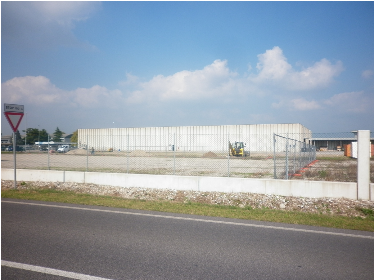
Figura 1 Area centrale di cantiere
