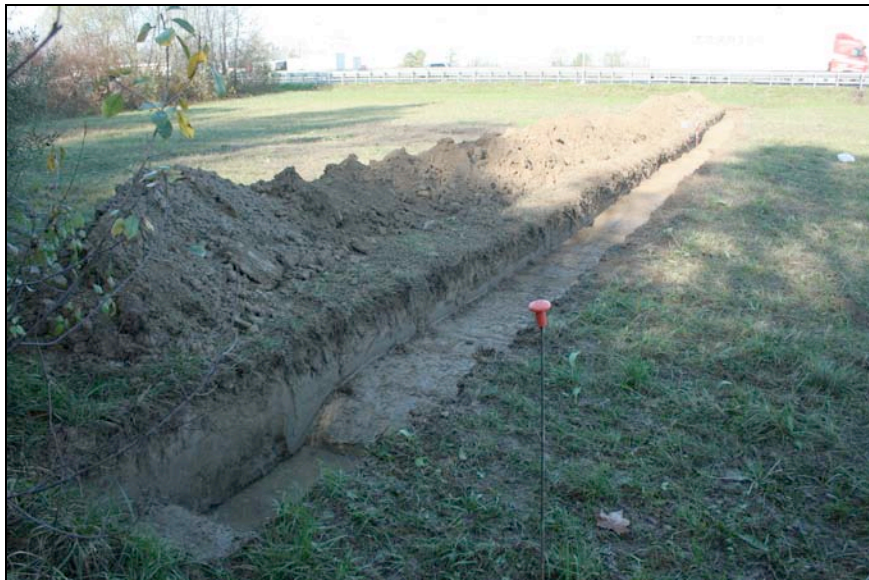
Fig. 7. La Trincea 1 vista da S; sullo sfondo l'autostrada.
