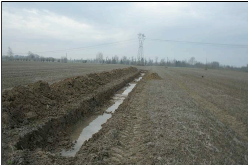
Fig. 3. La Trincea 2 vista da S; sullo sfondo il traliccio di sostegno della linea dell'alta tensione che corre a N dell'area.
