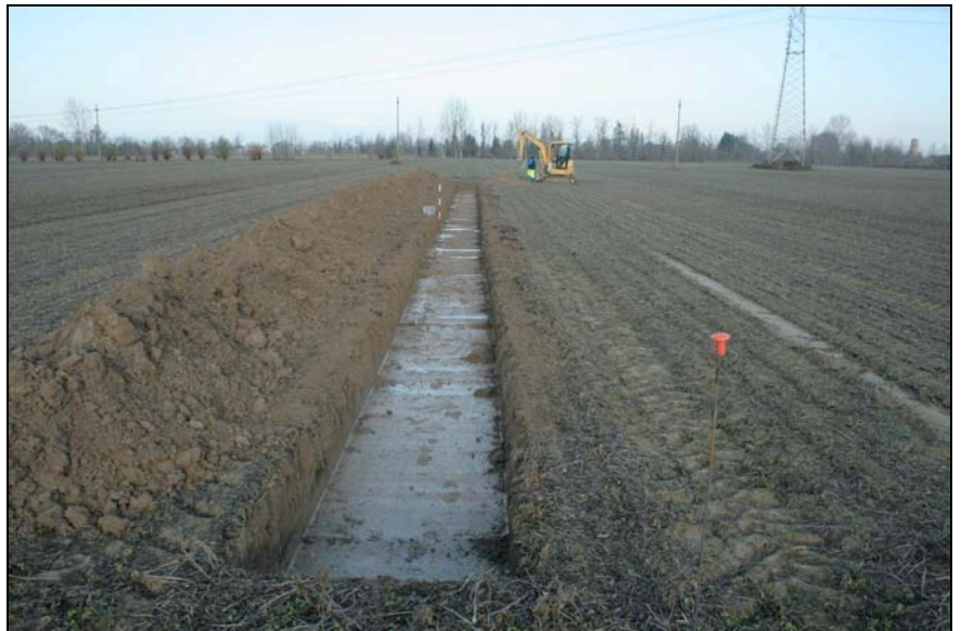
Fig. 6. La Trincea 5 vista da S.
