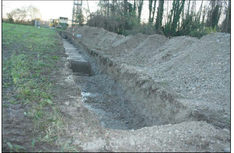
Fig. 11. La Trincea 3 vista da N; si noti in primo piano il riporto di ghiaia del terrapieno dell'area di servizio.
