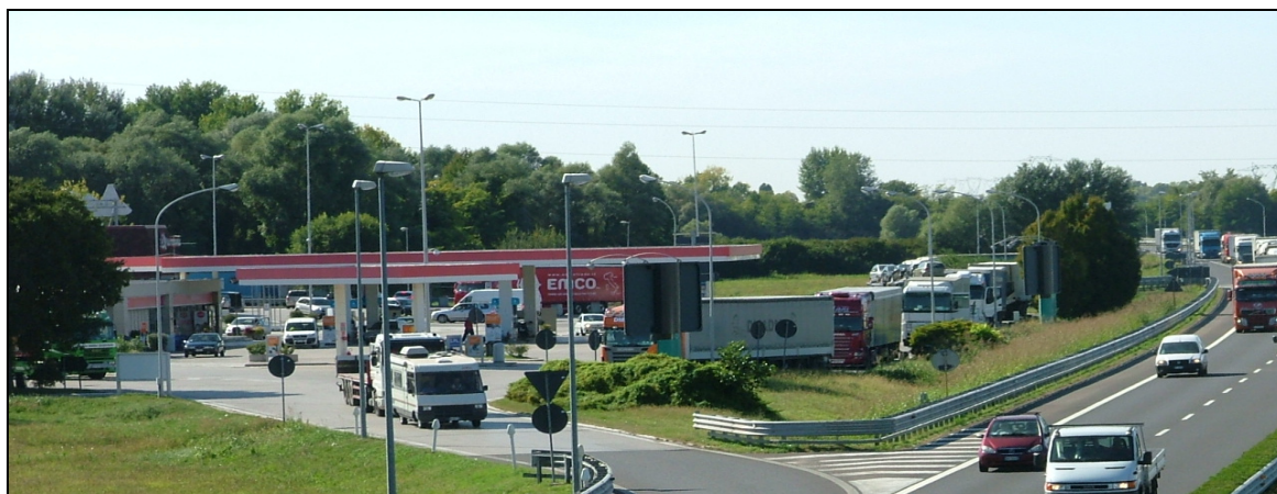
Attuale condizione dell'area di servizio. Sullo sfondo la zona prativa e la parte boscata in parte interessate dall'ampliamento del parcheggio
