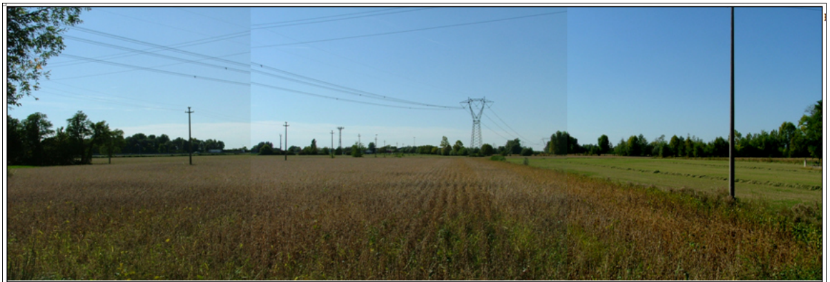
Condizione agricola del territorio esterno alla stazione di servizio (zona nord)
