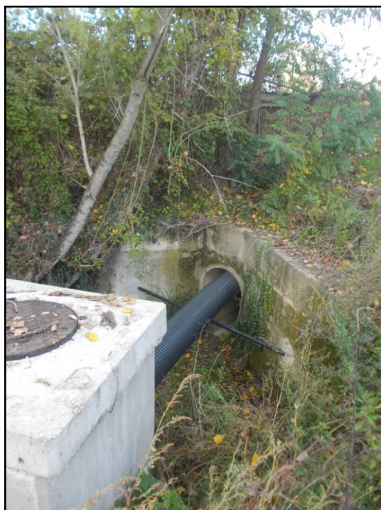
Figura 32 - imbocco Borro Pianale nel tratto tombato sotto il piazzale officine
