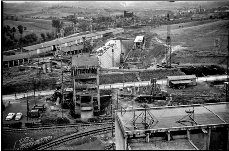
FIGURA 11 - COSTRUZIONE DEL "BUNKER LIGNITE"
