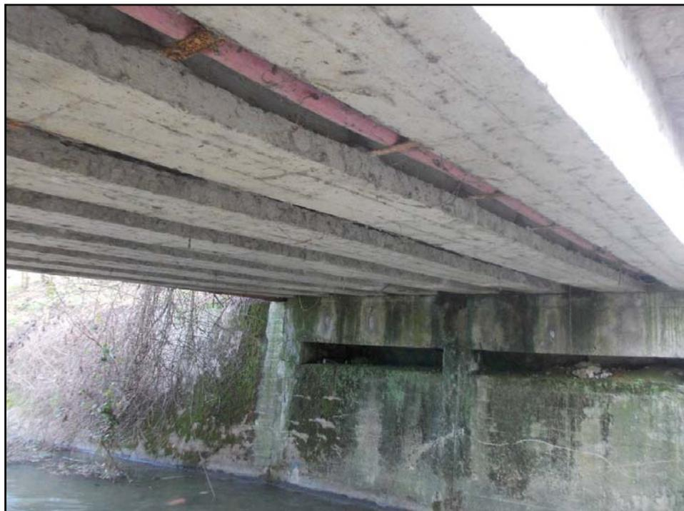
FIGURA 17 - PONTICELLO DA DEMOLIRE: VISTA IMPALCATO
