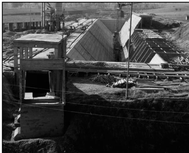
FIGURA 10 - AREA BUNKER: IN PRIMO PIANO STAZIONE DI PARTENZA NASTRO CENERI (ANNO 1957)
