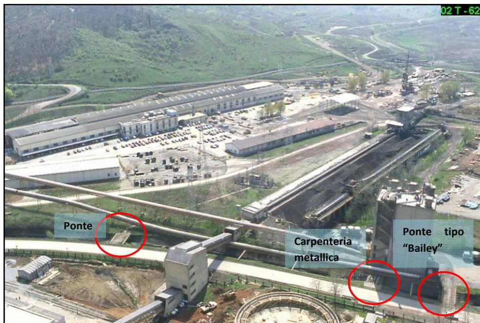
FIGURA 2 - VEDUTA AREA BUNKER CON PONTICELLO E STRUTTURE METALLICHE DA DEMOLIRE (ANNO 1981)
