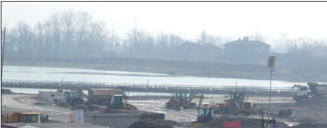
Figura 3.6 – Assetto ecostrutturale all'interno della cava rilevato durante la seconda sessione di controllo. Vista sul quadrante meridionale della cava
