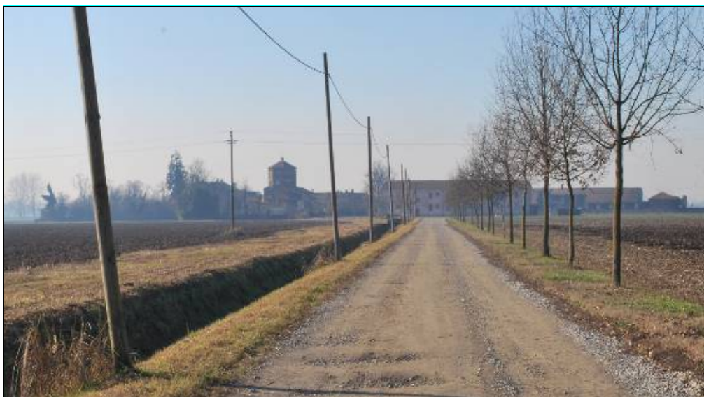
Figura 3.12 – Percezione del nucleo di Rossate da breve distanza: visione da Est lungo la strada comunale Lavagna-C.na Gandino/c.na di Mezzo. (Codice Foto: 5000)
