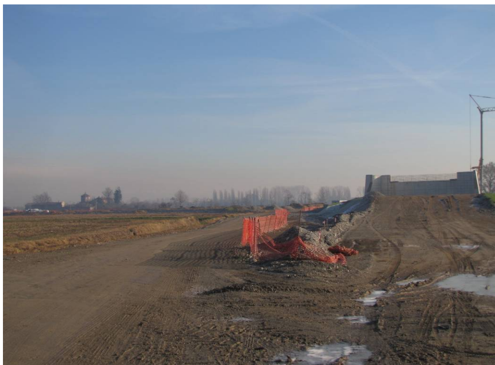
Figura 3.10 – Viabilità di accesso a Rossate dalla strada bianca proveniente da Sud-Ovest. Sulla destra la vista del sovrappasso della TEEM in fase di realizzazione. Rilievo del 05/12/2013. (Codice Foto: 4207)
