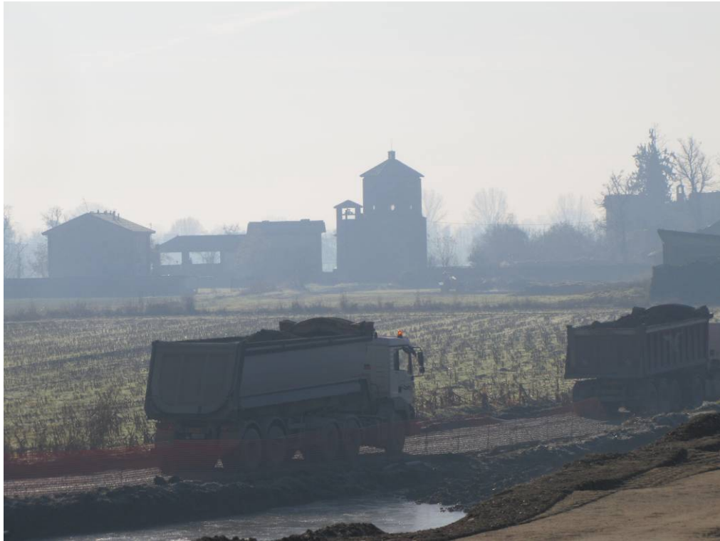
Figura 3.11 – Vista dell’Oratorio e della viabilità di cantiere dal rilevato. Rilievo del 05/12/2013. (Codice Foto: 4217)
