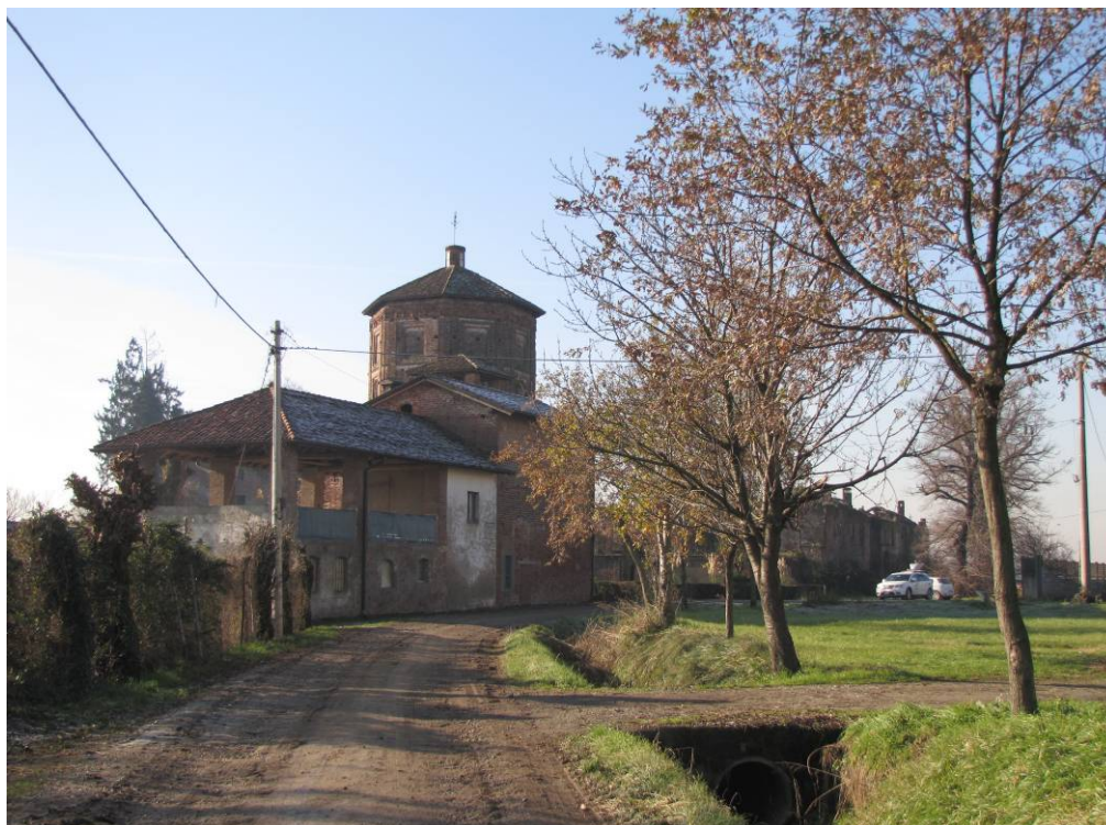
Figura 3.9 – Vista viabilità di accesso per fruttori provenienti dall’abitato di Lavagna. Rilievo del 05/12/2013. (Codice Foto: 4233)
