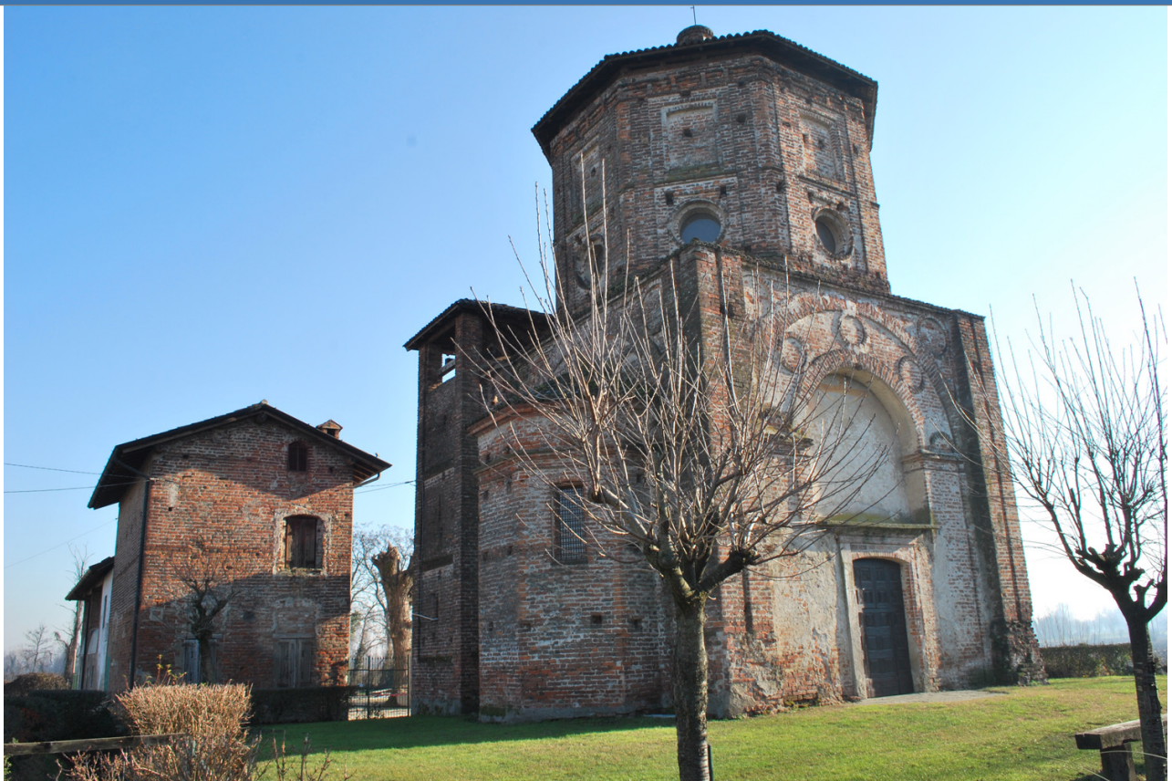
Foto 1 Foto della stazione di indagine
