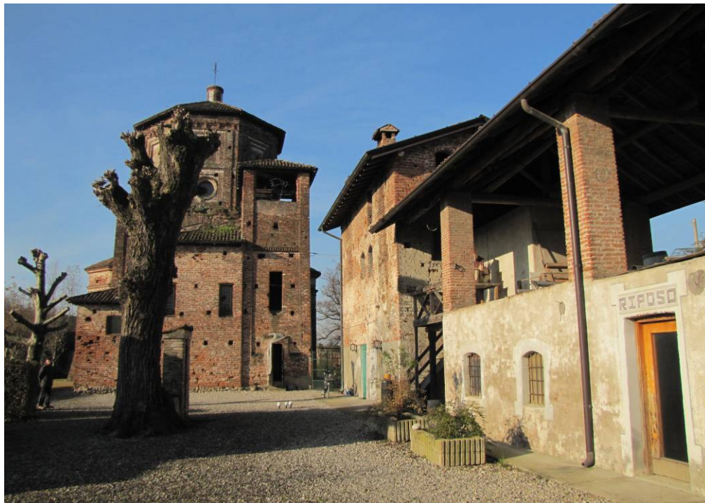
Figura 3.8 – Vista cortile interno dell'Oratorio di San Biagio. Rilievo del 05/12/2013. (Codice Foto: 4200)
