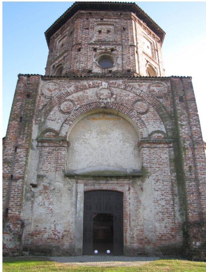
Figura 3.5 – Vista facciata principale. Rilievo del 05/12/2013. (Codice Foto: 4223)
