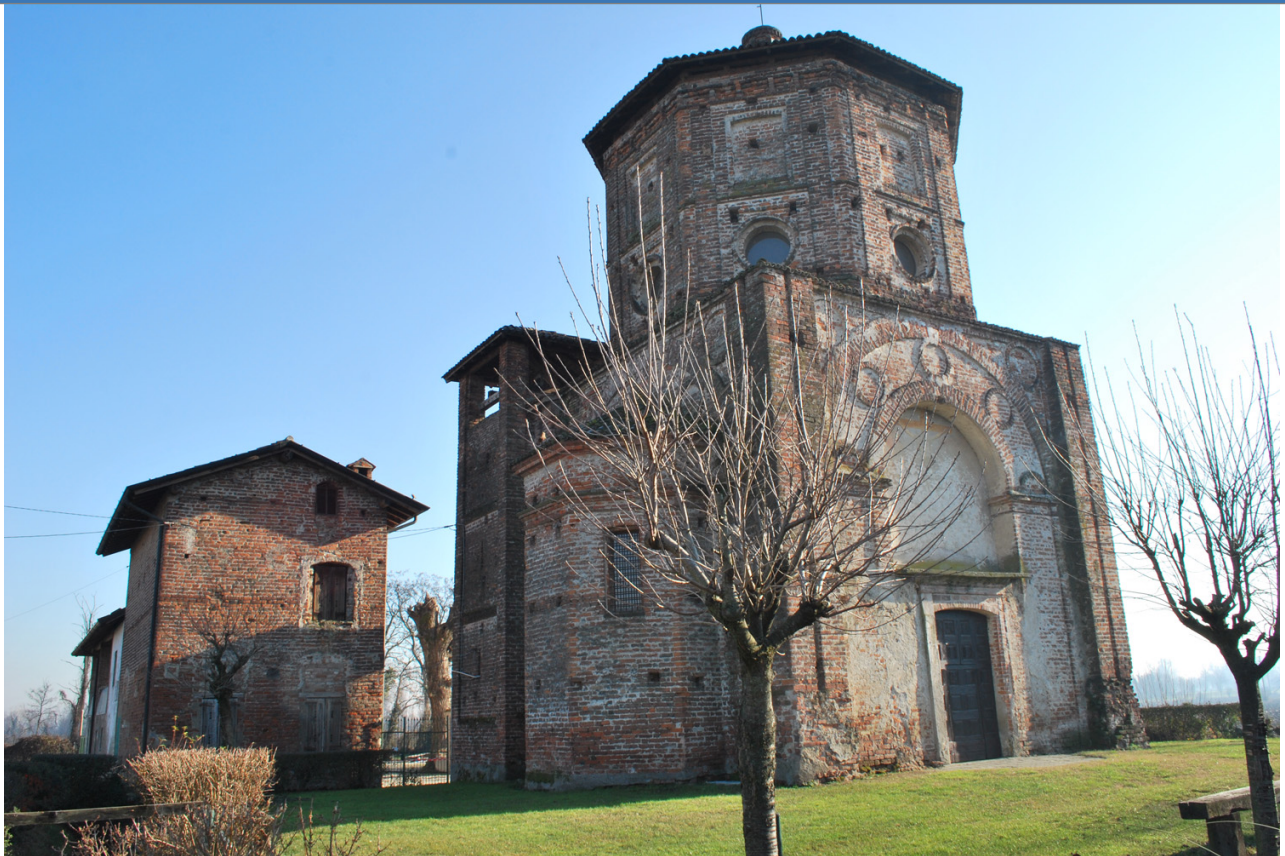
Foto 1 Foto della stazione di indagine
