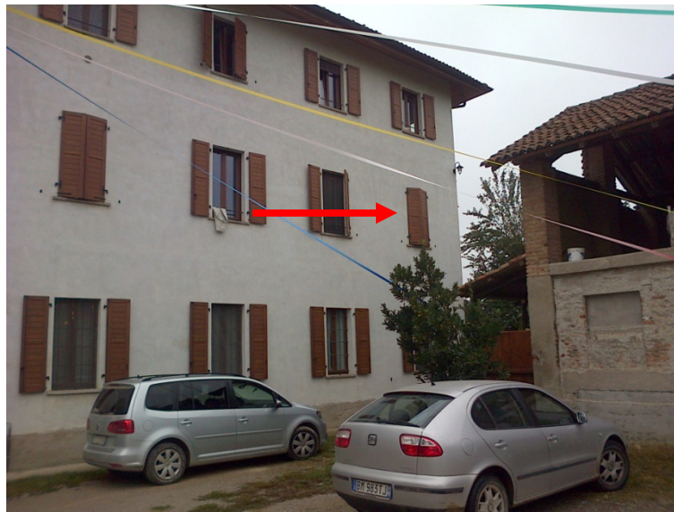
Figura 3 - Localizzazione terne al piano intermedio – VIB-GO-01 (rilievo di ottobre)
