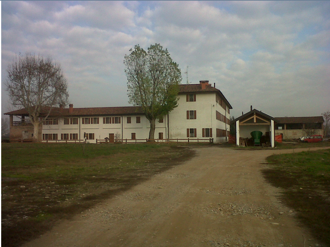
Foto 1 Foto della stazione di indagine
