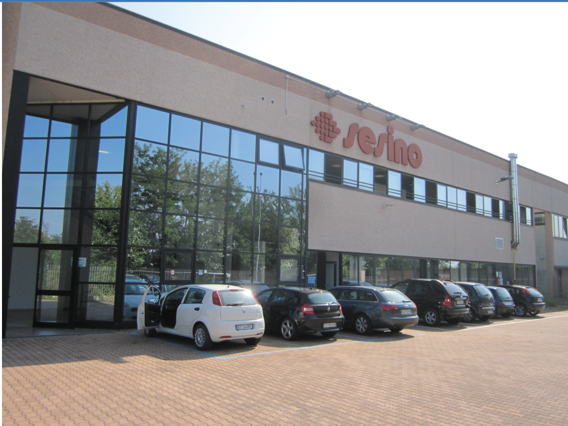
Foto 1 Foto della stazione di indagine
