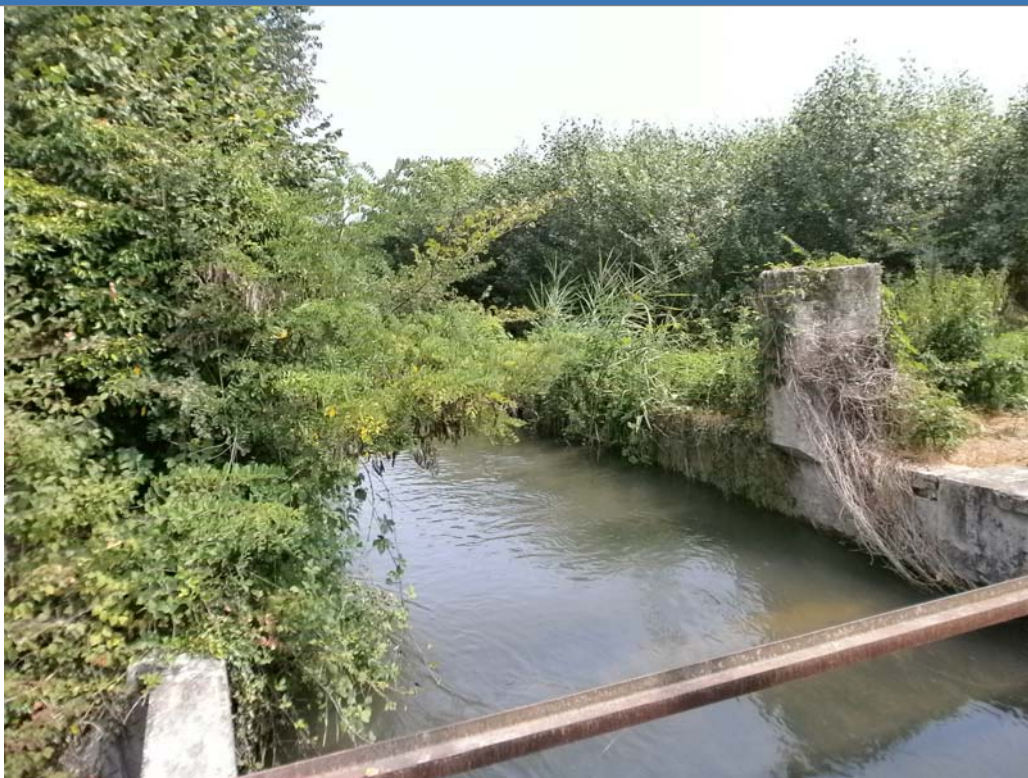
Foto 1 Foto attività di rilievo
