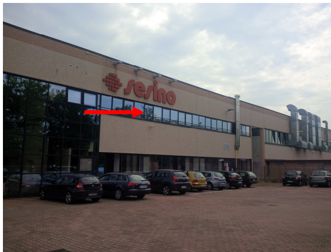
Figura 5 – Localizzazione terna al piano alto – VIB-GE-01
