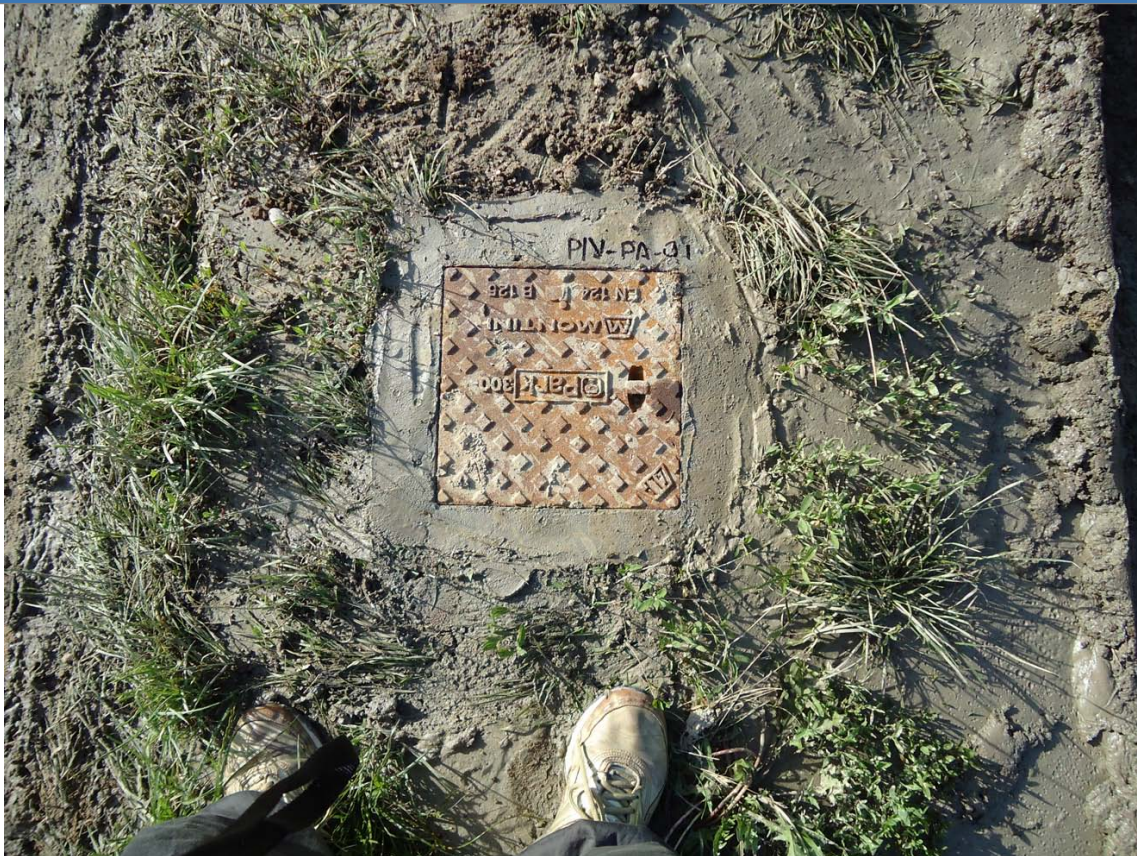
Foto 1 Foto della stazione di indagine
