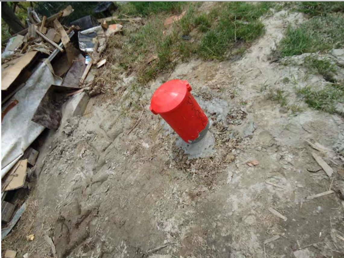
Foto 2 Foto della stazione di indagine
