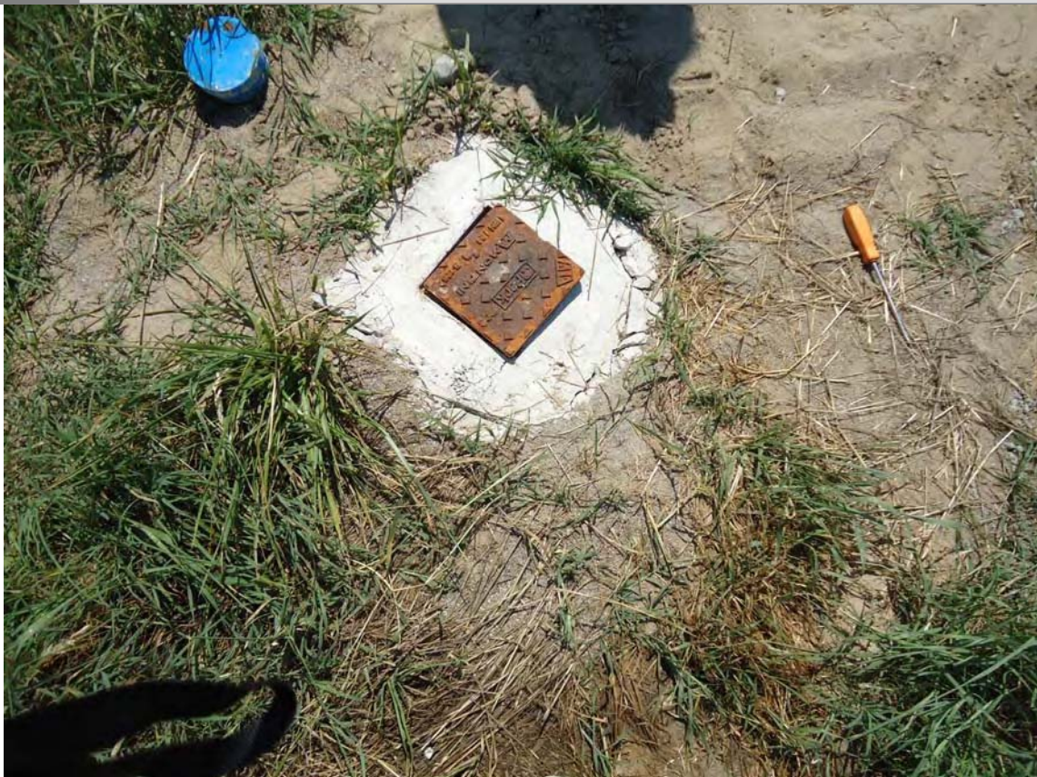
Foto 2 Foto della stazione di indagine
