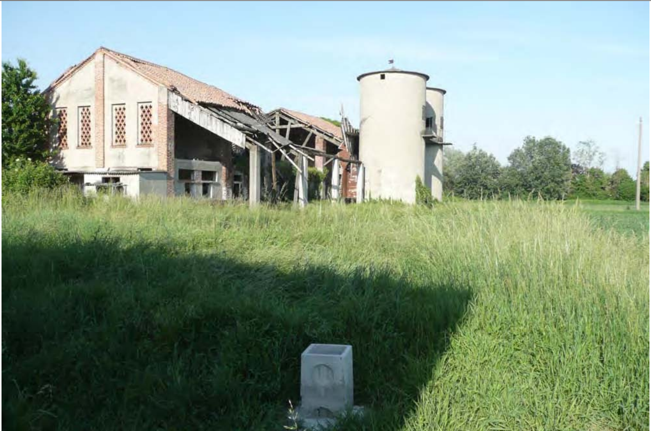
Foto 2 Foto della stazione di indagine
