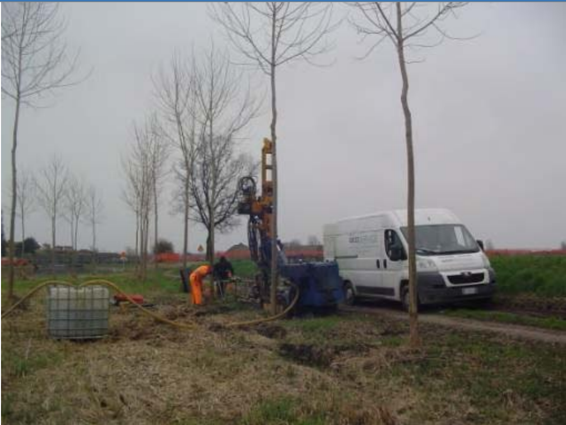
Foto 1 Foto della stazione di indagine
