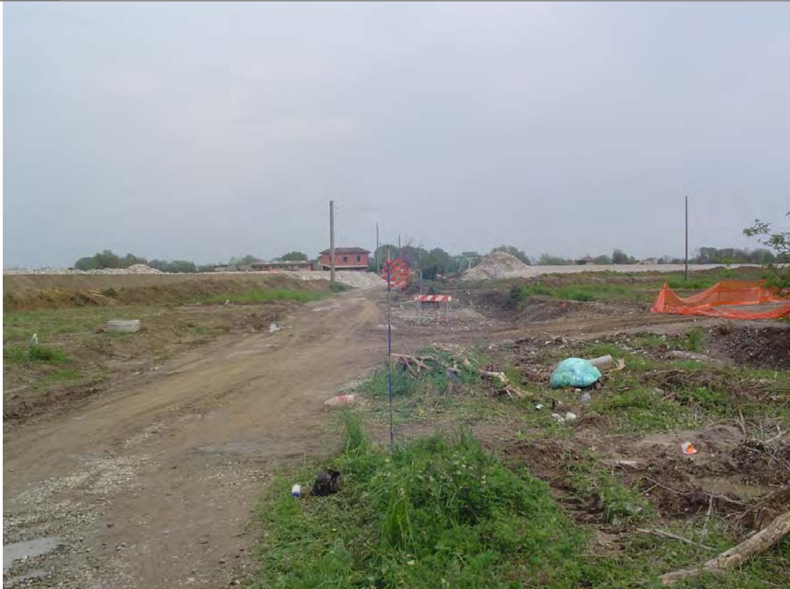
Foto 2 Foto della stazione di indagine
