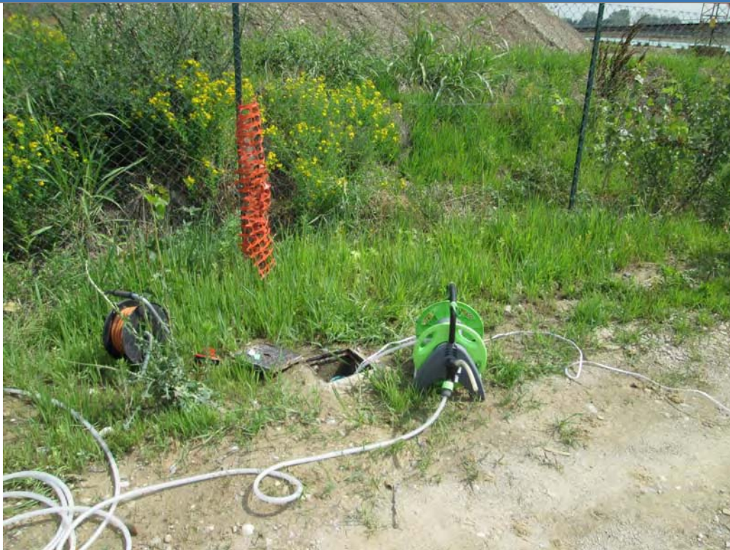
Foto 1 Foto attività di rilievo
