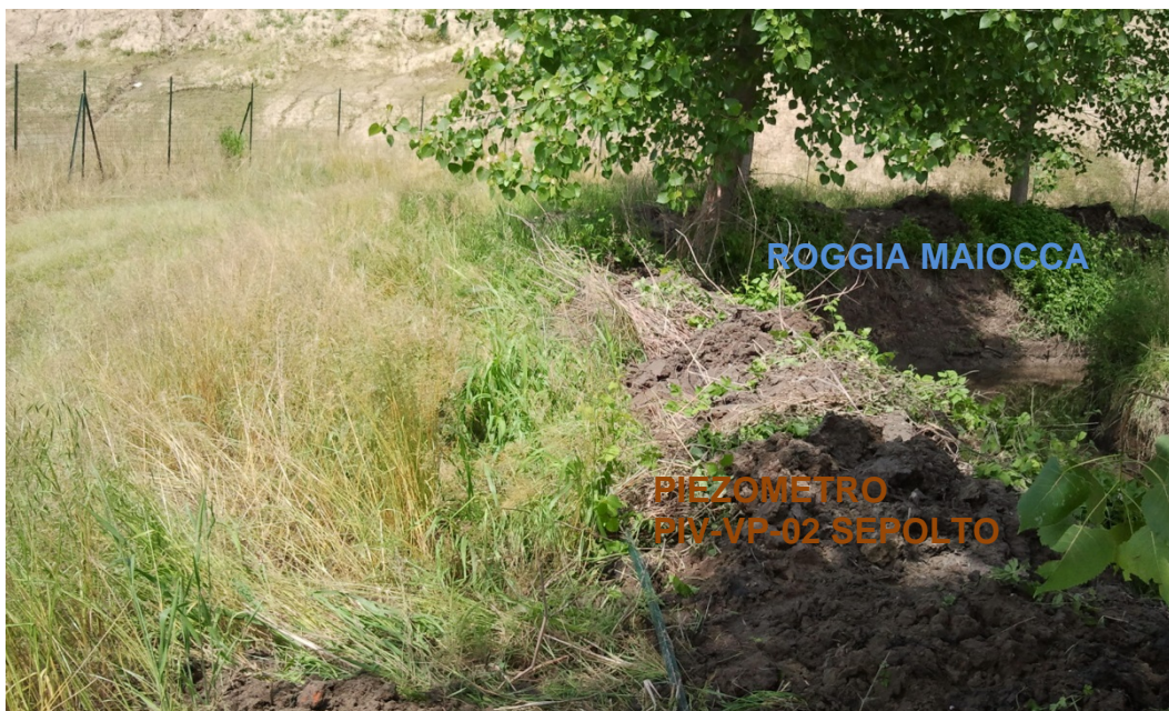
Figura 40 –Piezometro PIV-VP-02 trovato sepolto da cumuli di terreno durante il campionamento del 08/05/2014.
