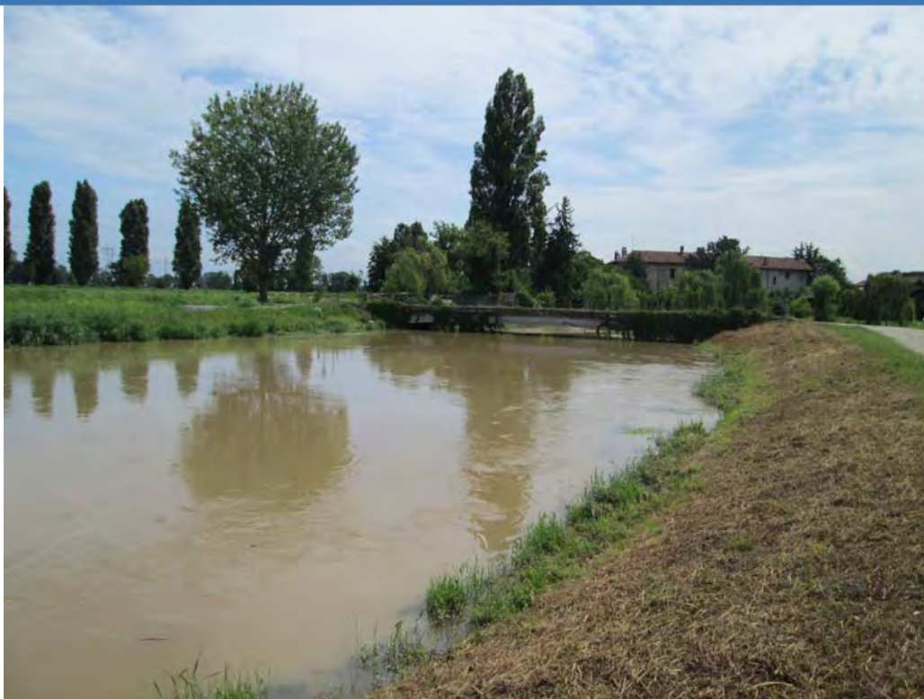
Foto 1 Foto attività di rilievo
