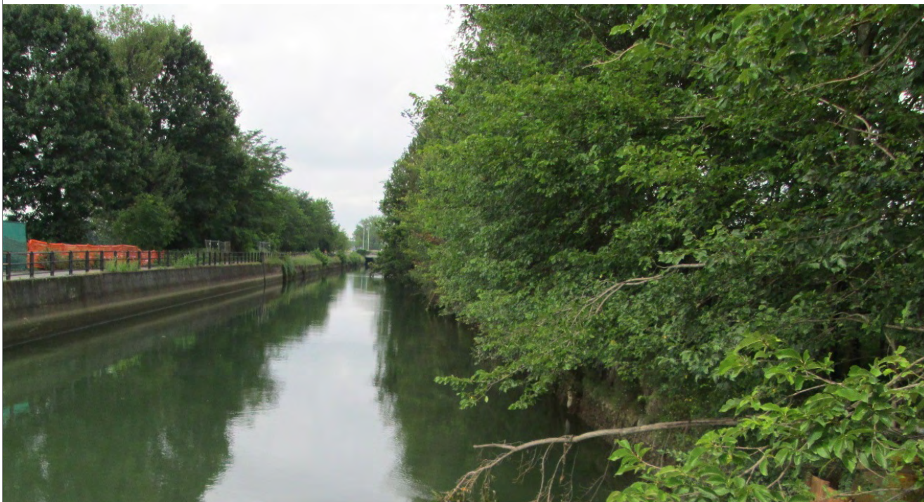
Foto 1 Foto attività di rilievo
