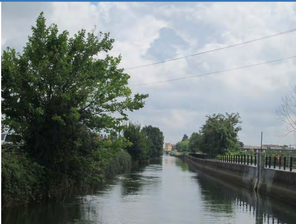
Foto 1 Foto attività di rilievo
