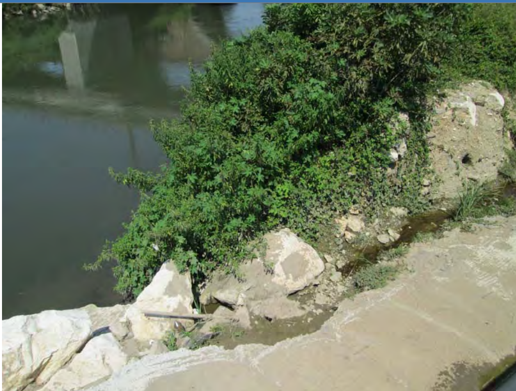
Foto 3 Foto attività di rilievo
