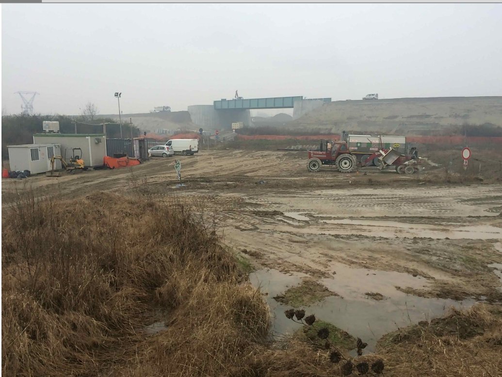
Foto 2 Foto attività di rilievo
