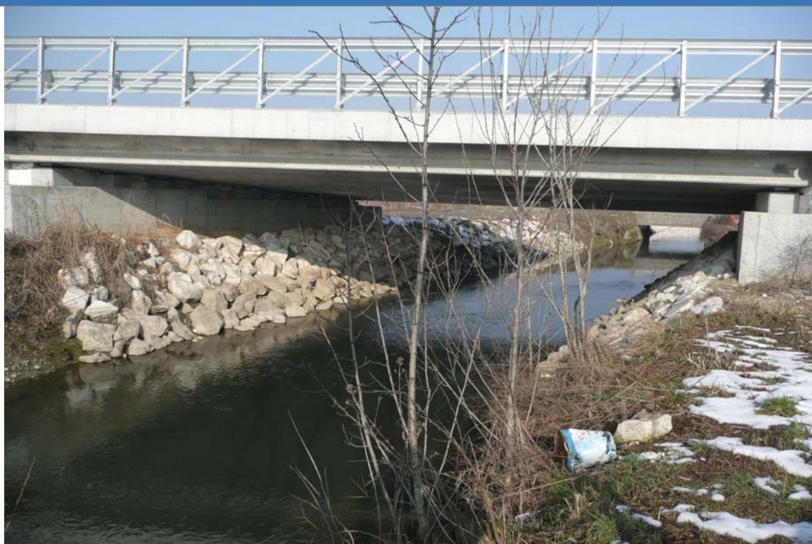
Foto 1 Foto attività di rilievo
