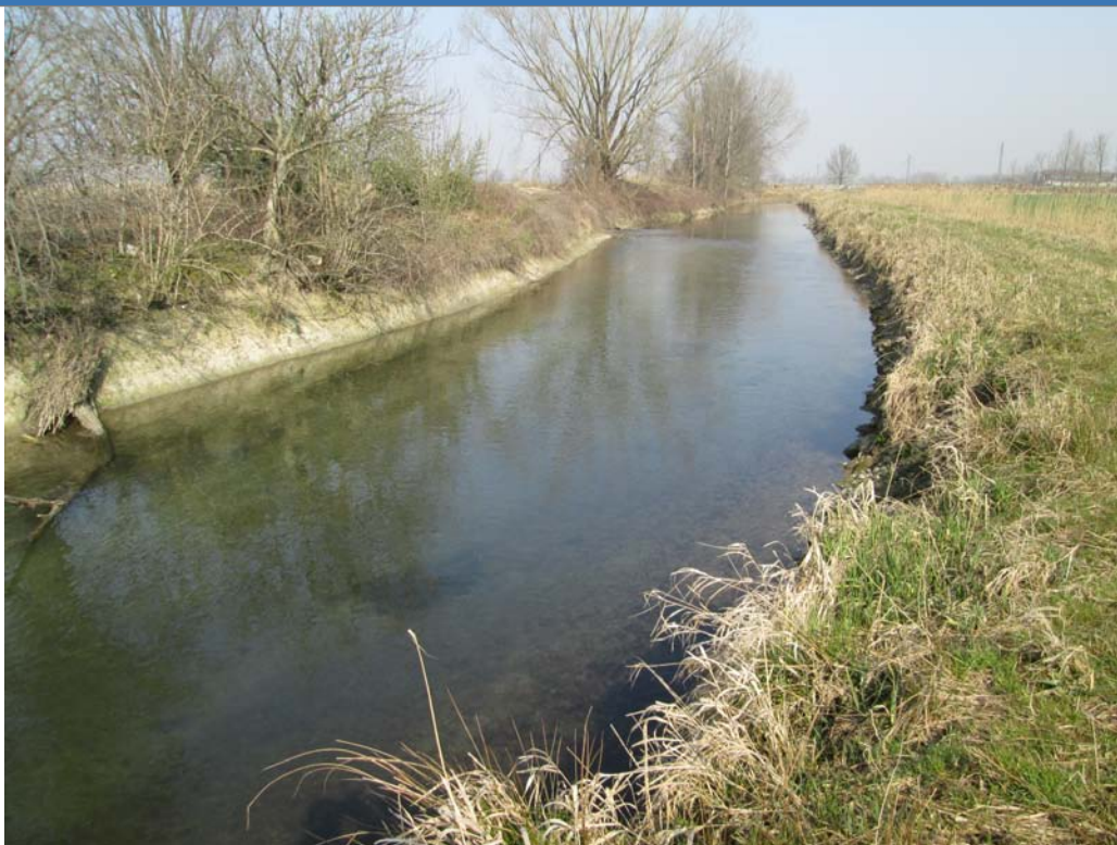
Foto 3 Foto attività di rilievo
