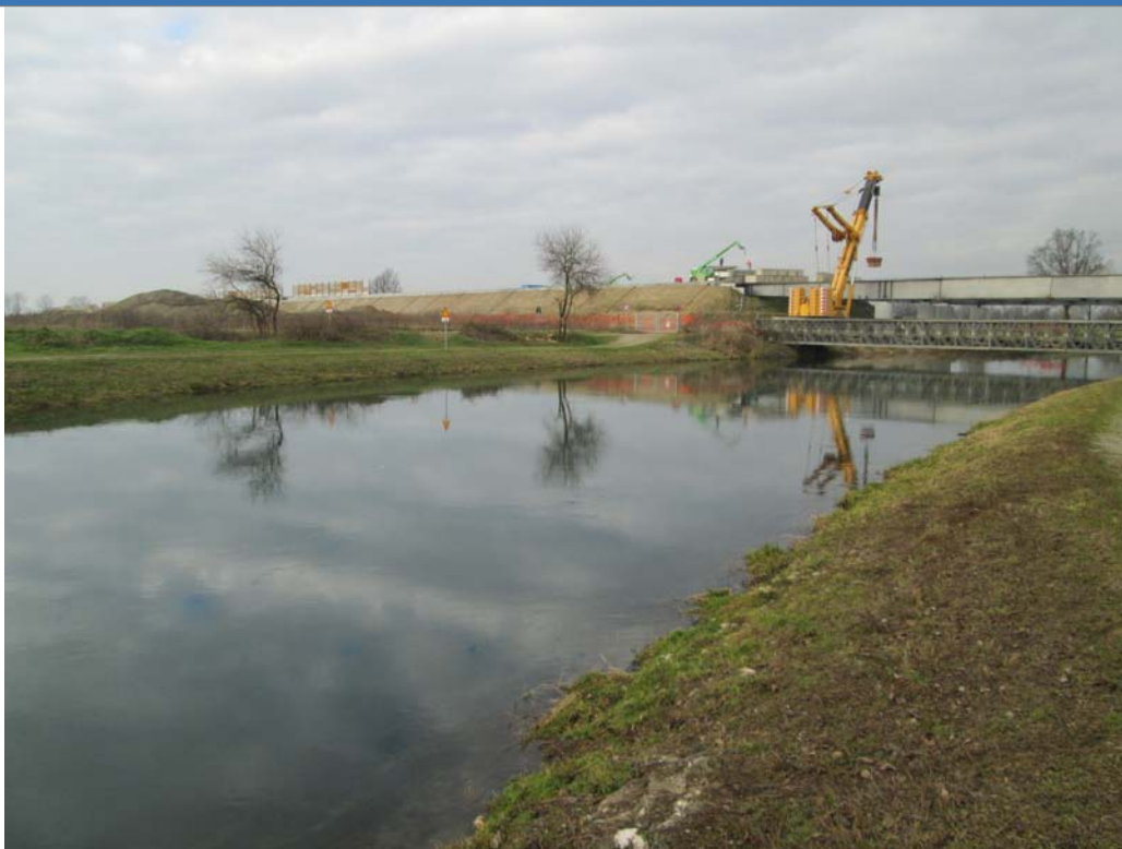
Foto 1 Foto attività di rilievo
