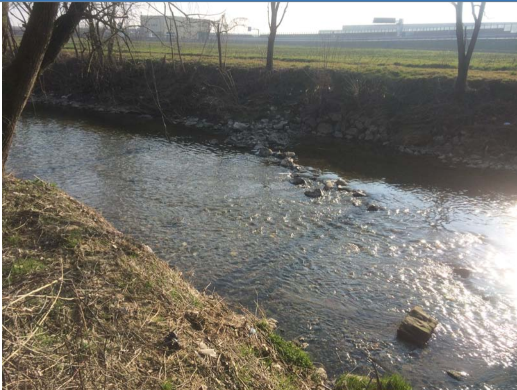
Foto 1 Foto attività di rilievo
