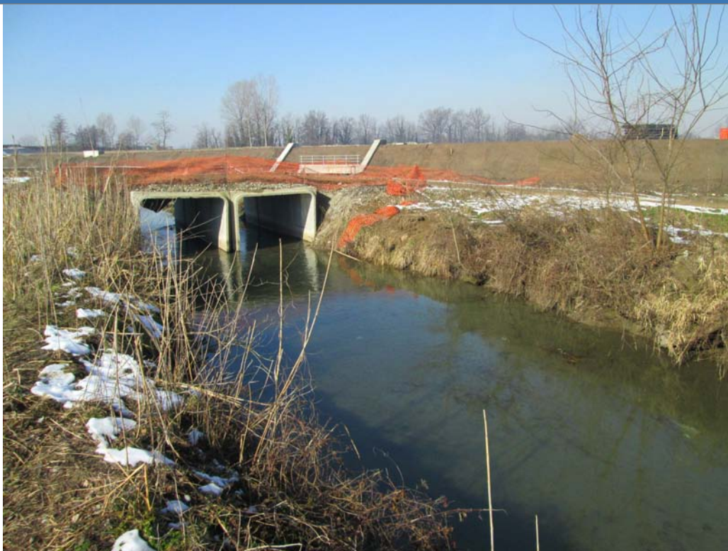
Foto 1 Foto attività di rilievo
