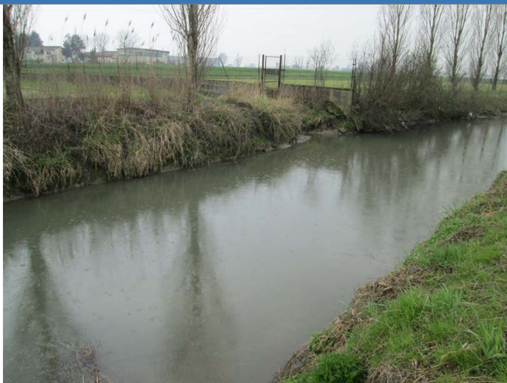
Foto 1 Foto attività di rilievo
