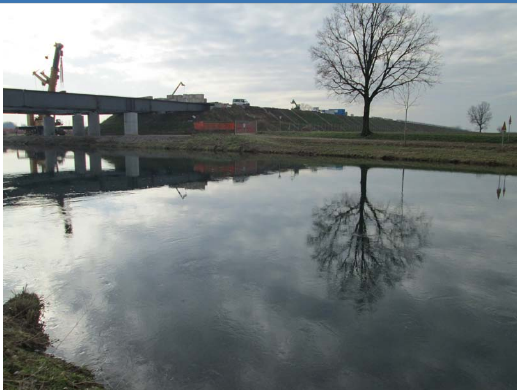
Foto 1 Foto attività di rilievo
