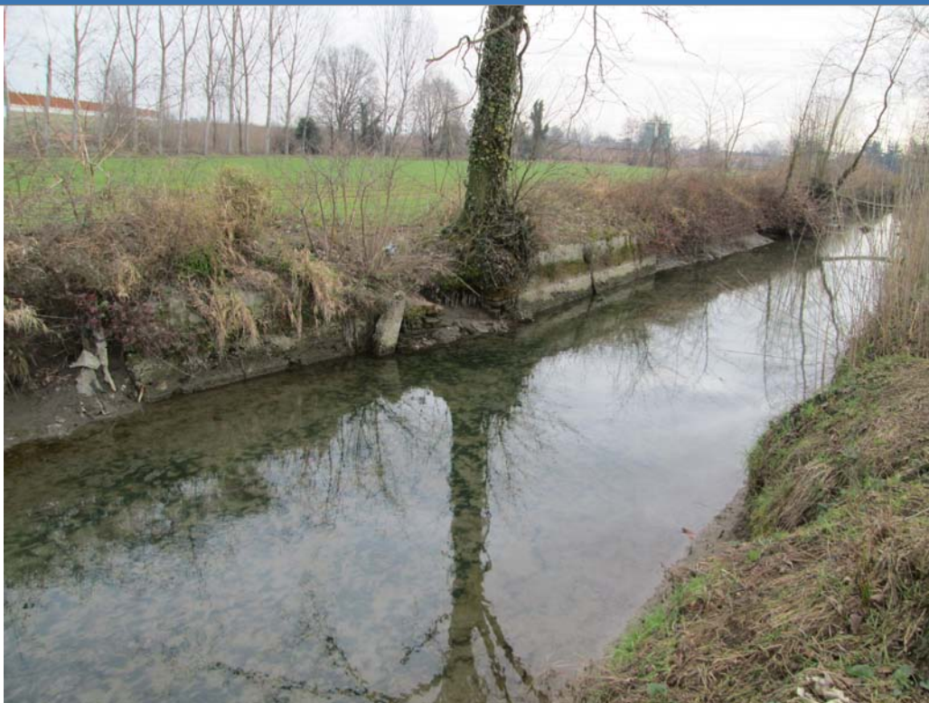
Foto 1 Foto attività di rilievo
