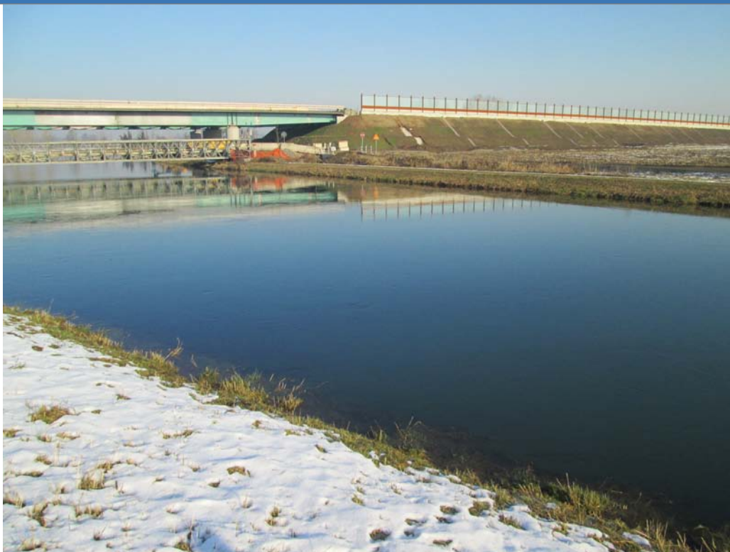
Foto 1 Foto attività di rilievo
