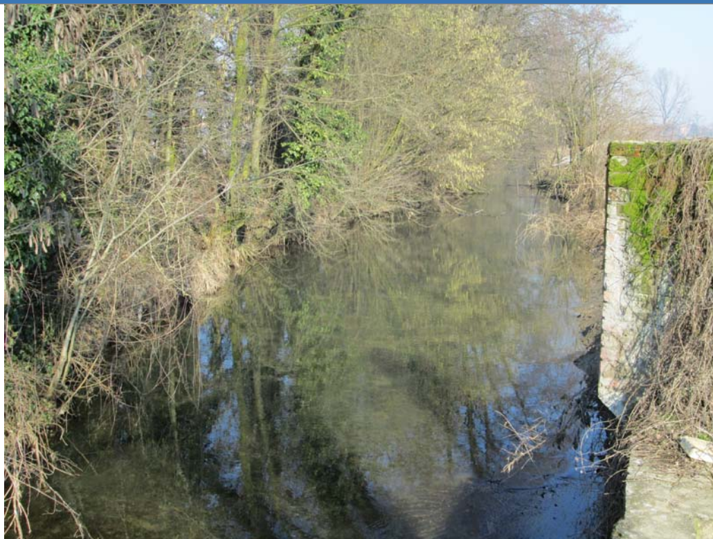
Foto 1 Foto attività di rilievo
