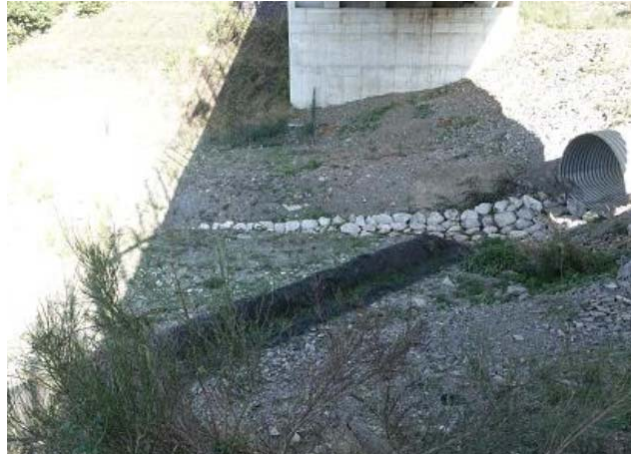
Foto 5 – Dreni e canalette installate nell'area.
