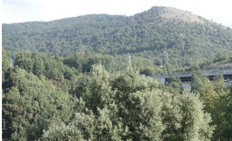
Foto 3 – Nuovo viadotto Serra visto da Sud.
