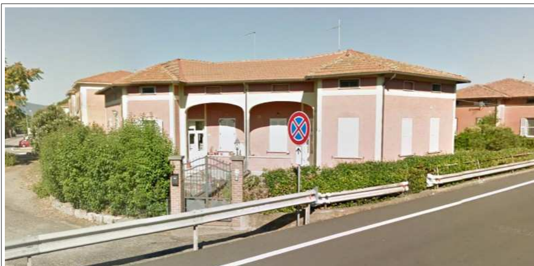
Il fabbricato visto dalla carreggiata nord della S.S. n.1 Aurelia
