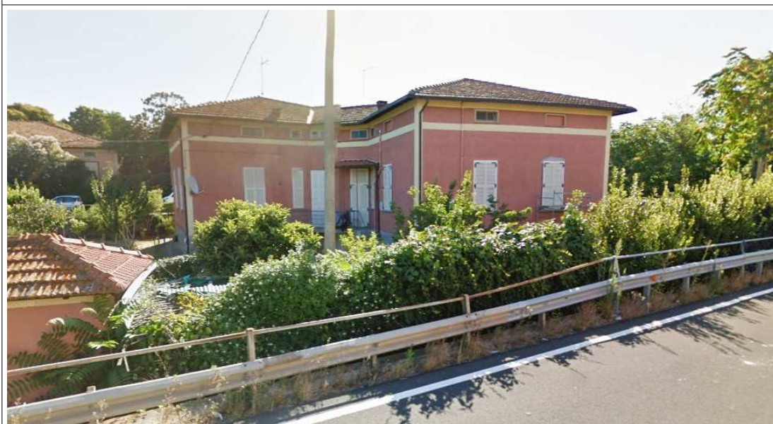
Il fabbricato visto dalla carreggiata sud della S.S. n.1 Aurelia
