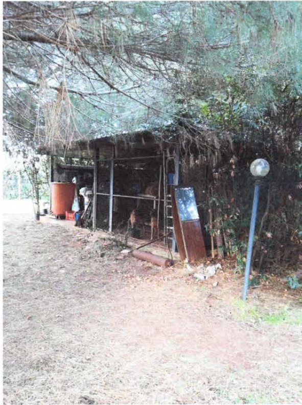
Foto n.01: Struttura in demolizione
