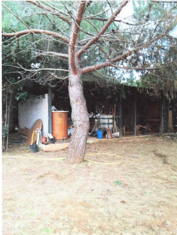
Foto n.02: Struttura in demolizione
