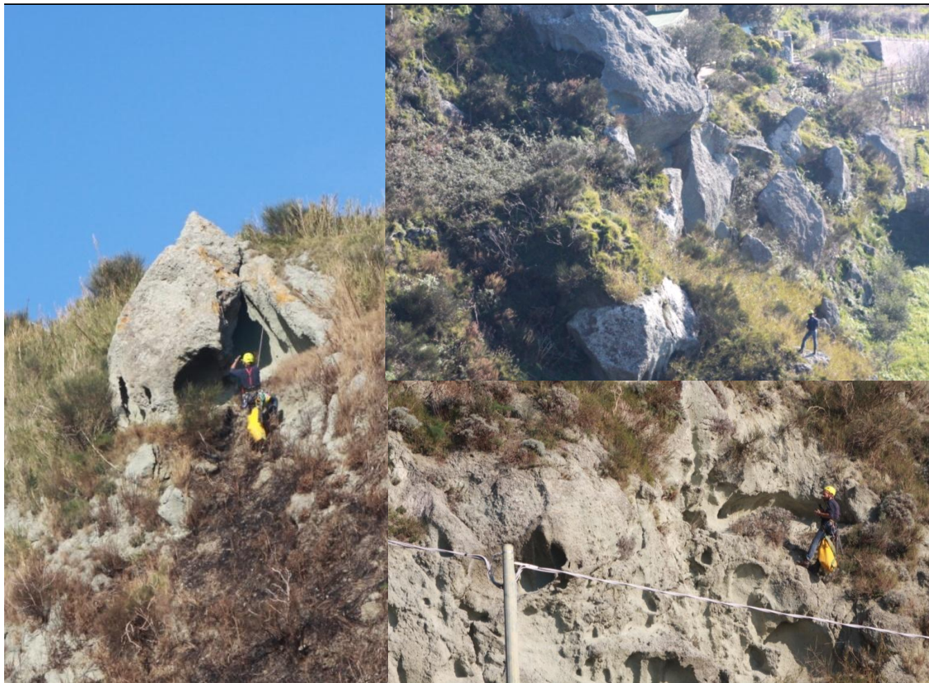
Figura 6: foto scattate durante le fasi di rilievo geomeccanico ed ispezione in parete eseguiti da geologi rocciatori
