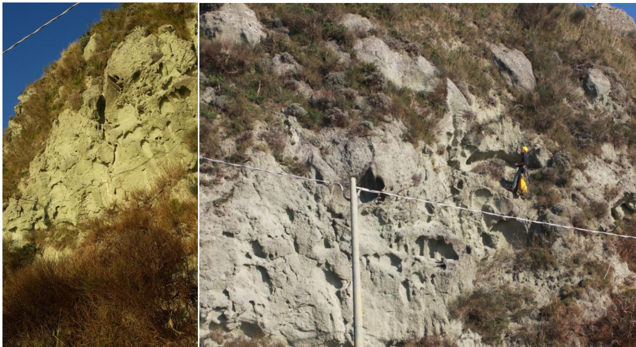
Figura 32: fascia disturbata posta ai piedi del versante probabilmente ascrivibile alla presenza di una zona di faglia. In tale settore il materiale si presenta più alterato e disgregato e luogo a fenomeni di alveolizzazione per erosione eolica e al distacco di masse internamente disgregate, che possono dar luogo a fenomeni tipo rock avalanches.
