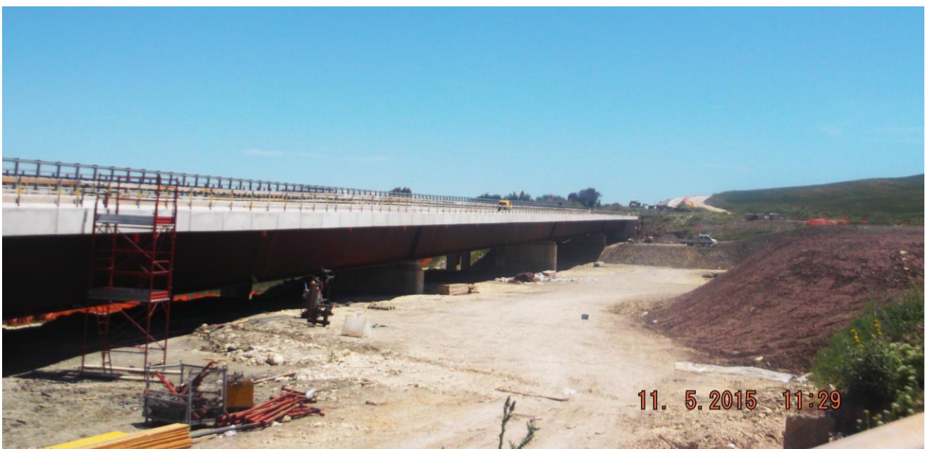
Foto 37 – Nuovo Viadotto Montagnola 1
