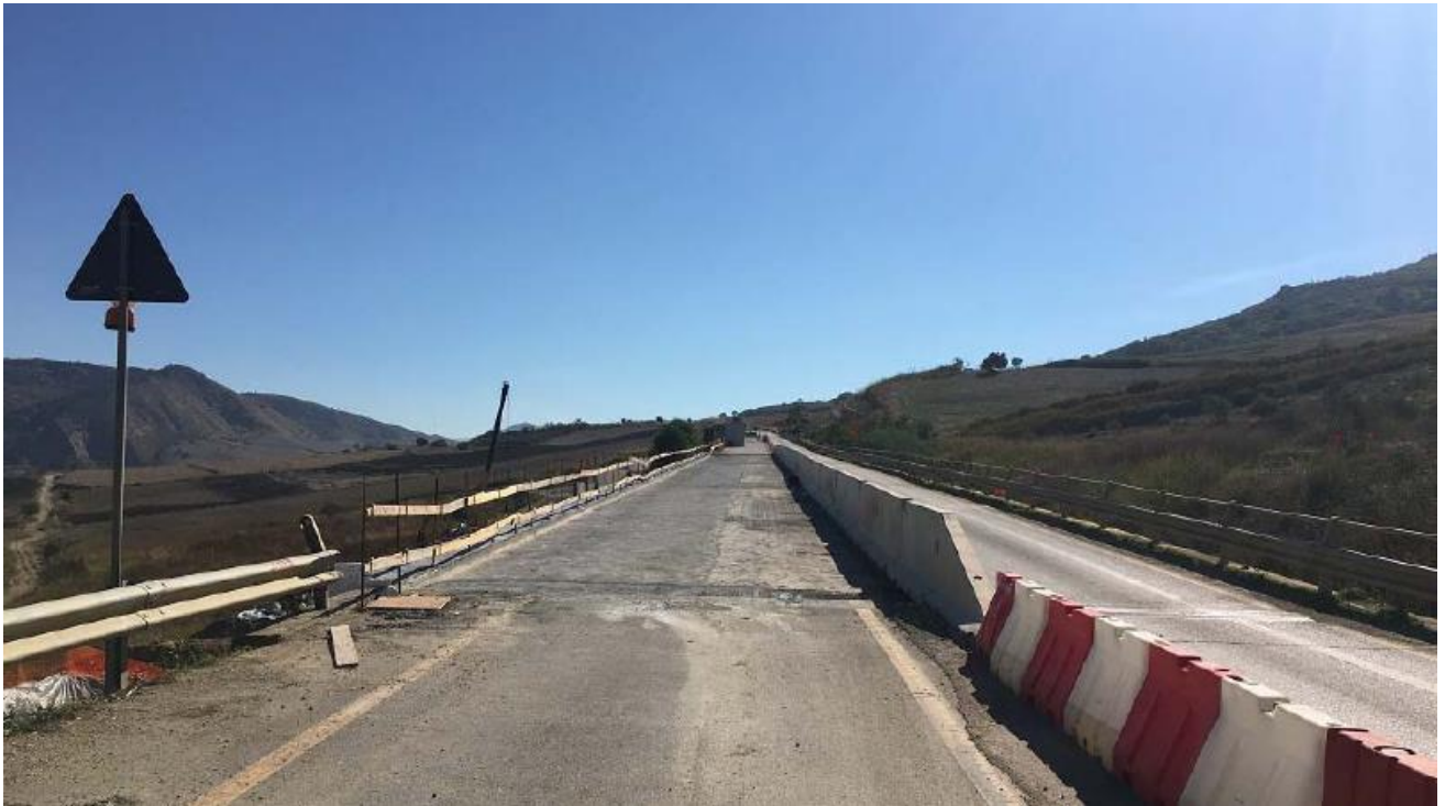
Foto 14 – Viadotto esistente Pecoraro 2
