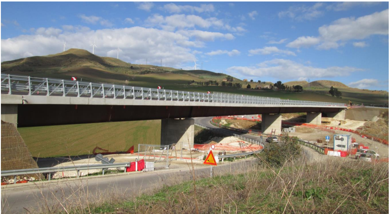
Foto 32 – Viadotto esistente Scorciavacche 2
