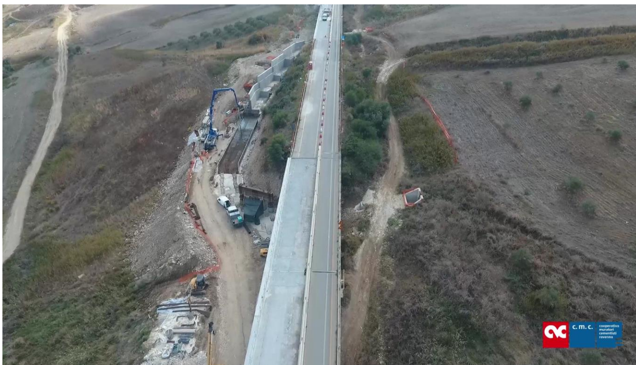
Foto 13 – Viadotto esistente Pecoraro 2
