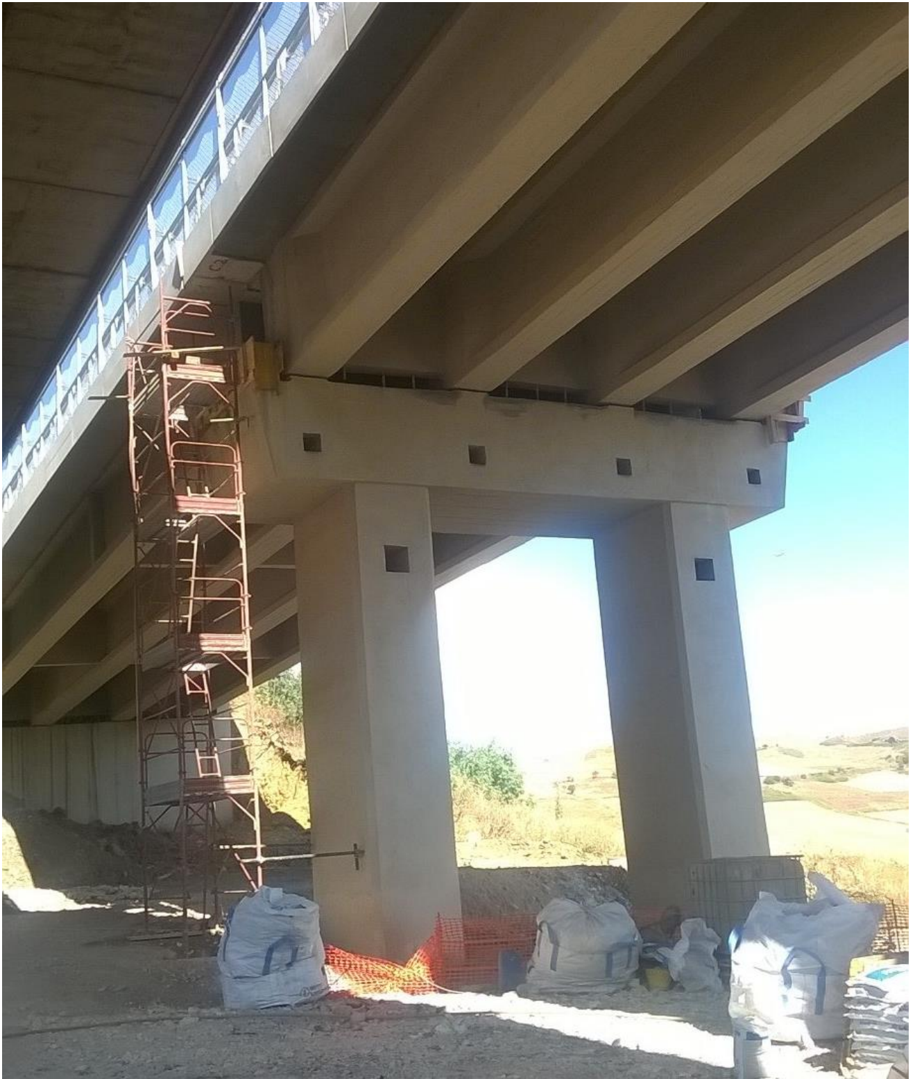
Foto 28 – Viadotto esistente Montagnola 2
