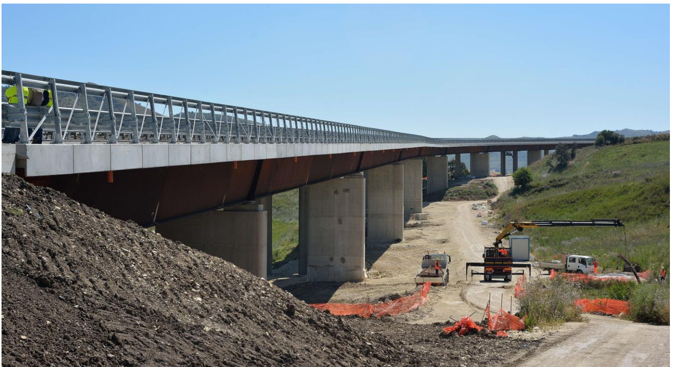
Foto 35 – Nuovo Viadotto Ferruzze 1
