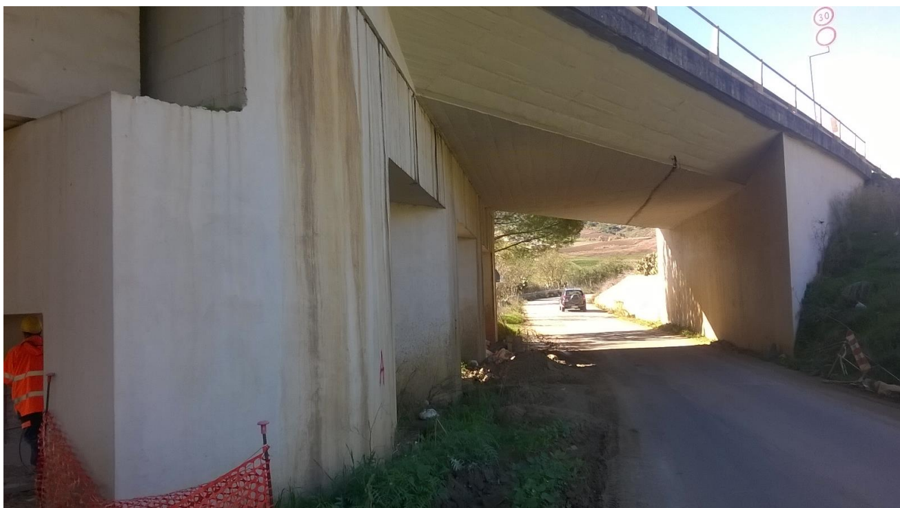
Foto 1 – Viadotto esistente Frattina 1
