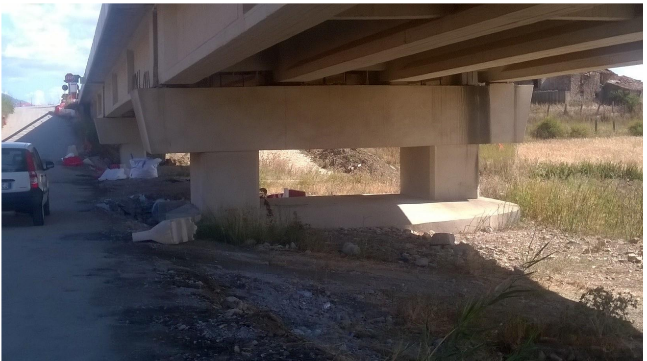
Foto 24 – Viadotto Santa Maria 1
