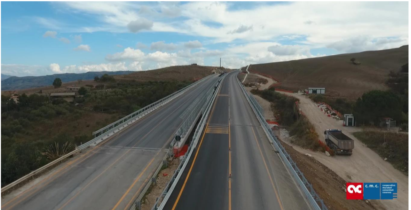
Foto 38 – Nuovo Viadotto Montagnola 2
