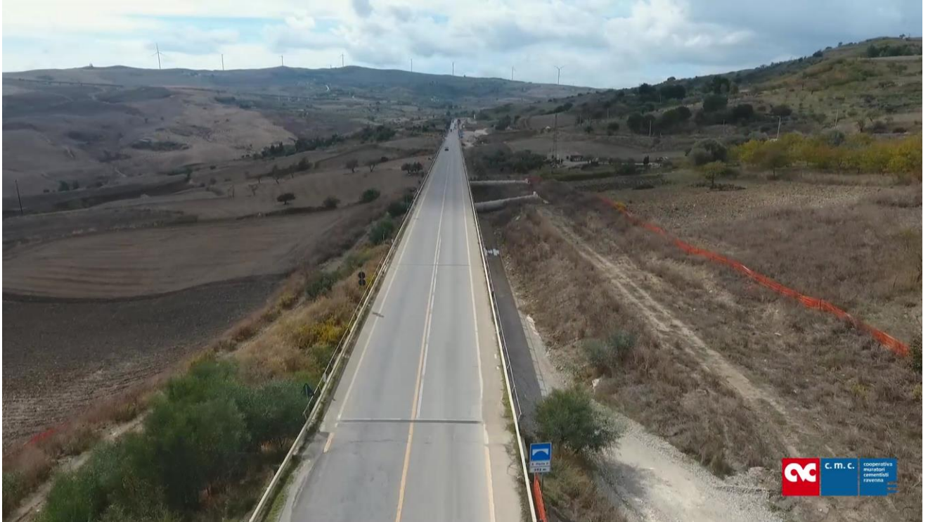
Foto 20 – Viadotto Santa Maria 2
