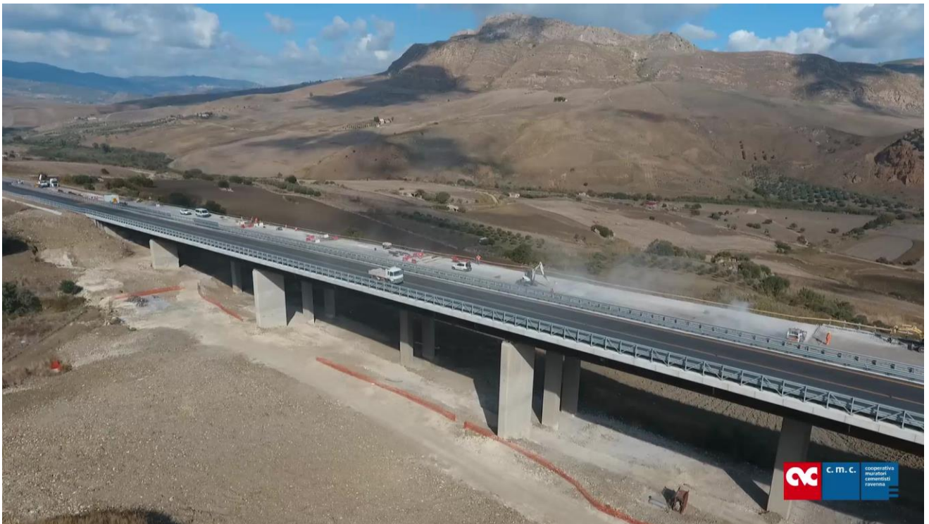
Foto 16 – Viadotto esistente Ferruzze 1
