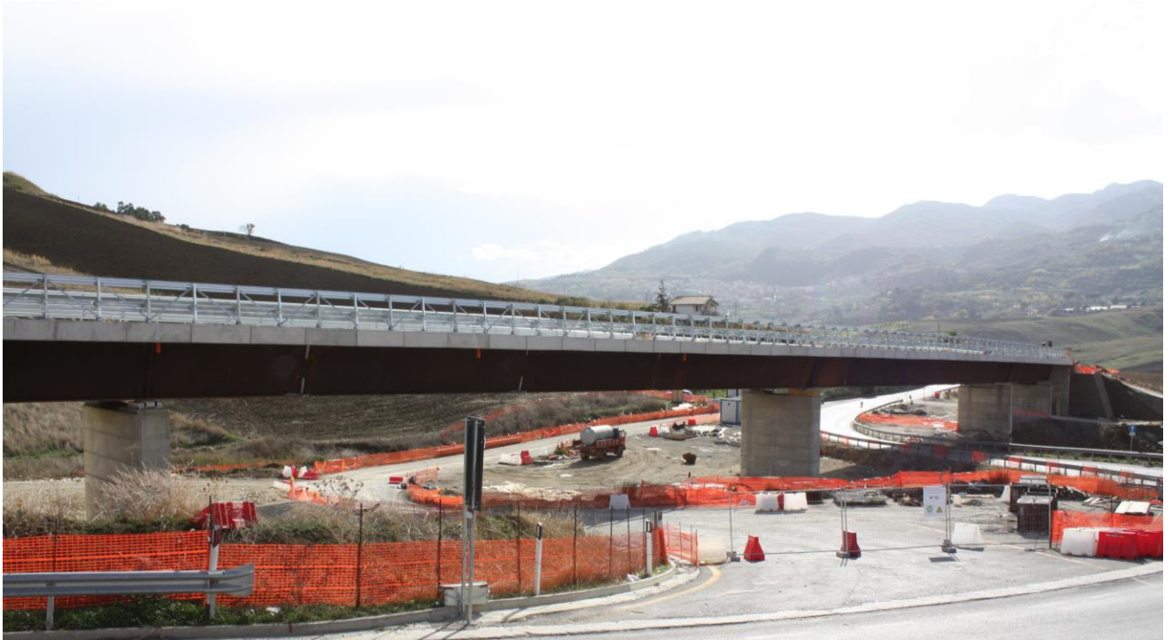
Foto 31 – Viadotto esistente Scorciavacche 2
