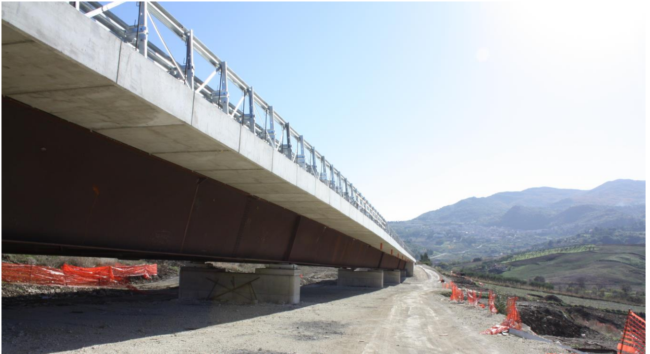
Foto 30 – Viadotto esistente Scorciavacche 1
