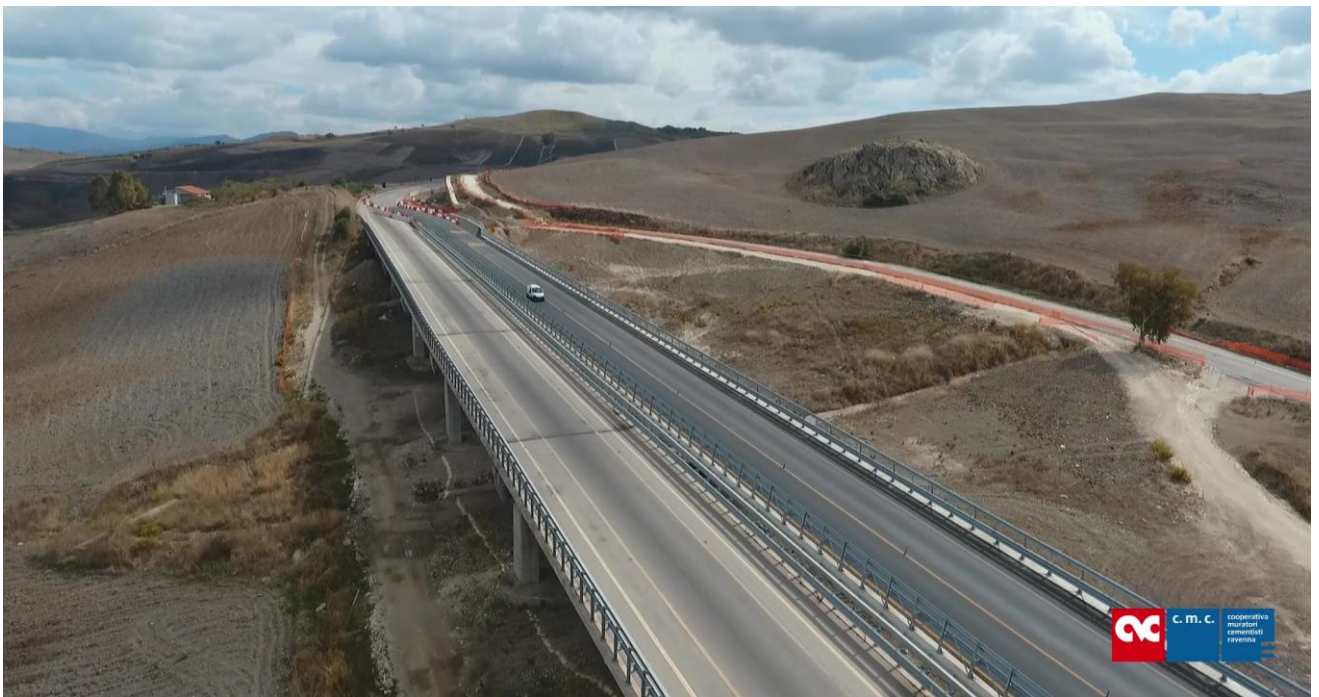
Foto 36 – Nuovo Viadotto Montagnola 1
