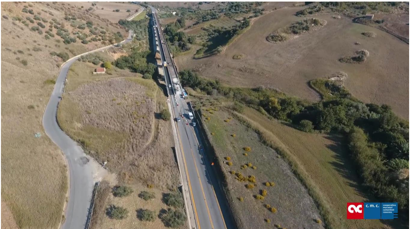
Foto 2 – Viadotto esistente Frattina 1
