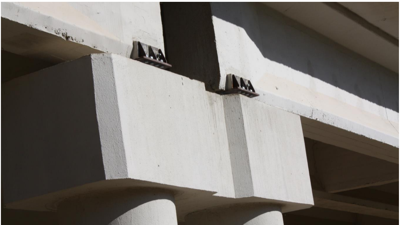
Foto 9 – Viadotto esistente Frattina 2
