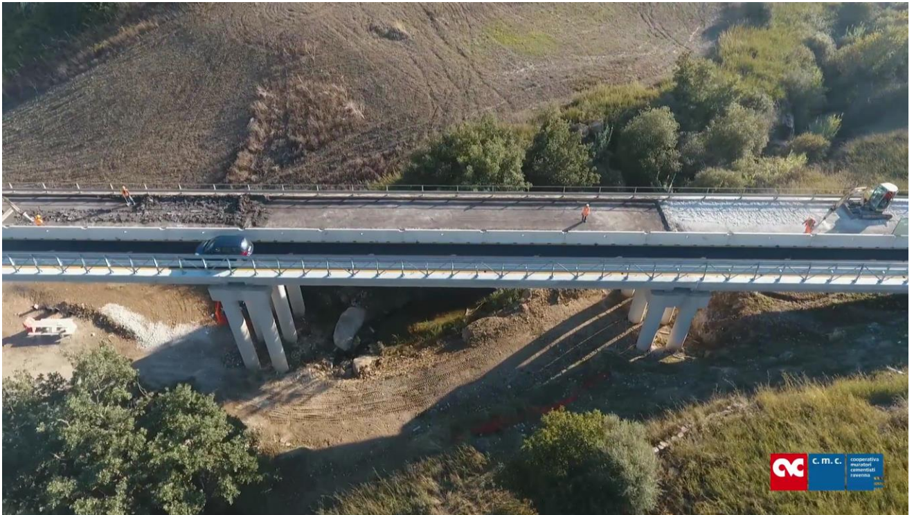
Foto 3 – Viadotto esistente Frattina 1
