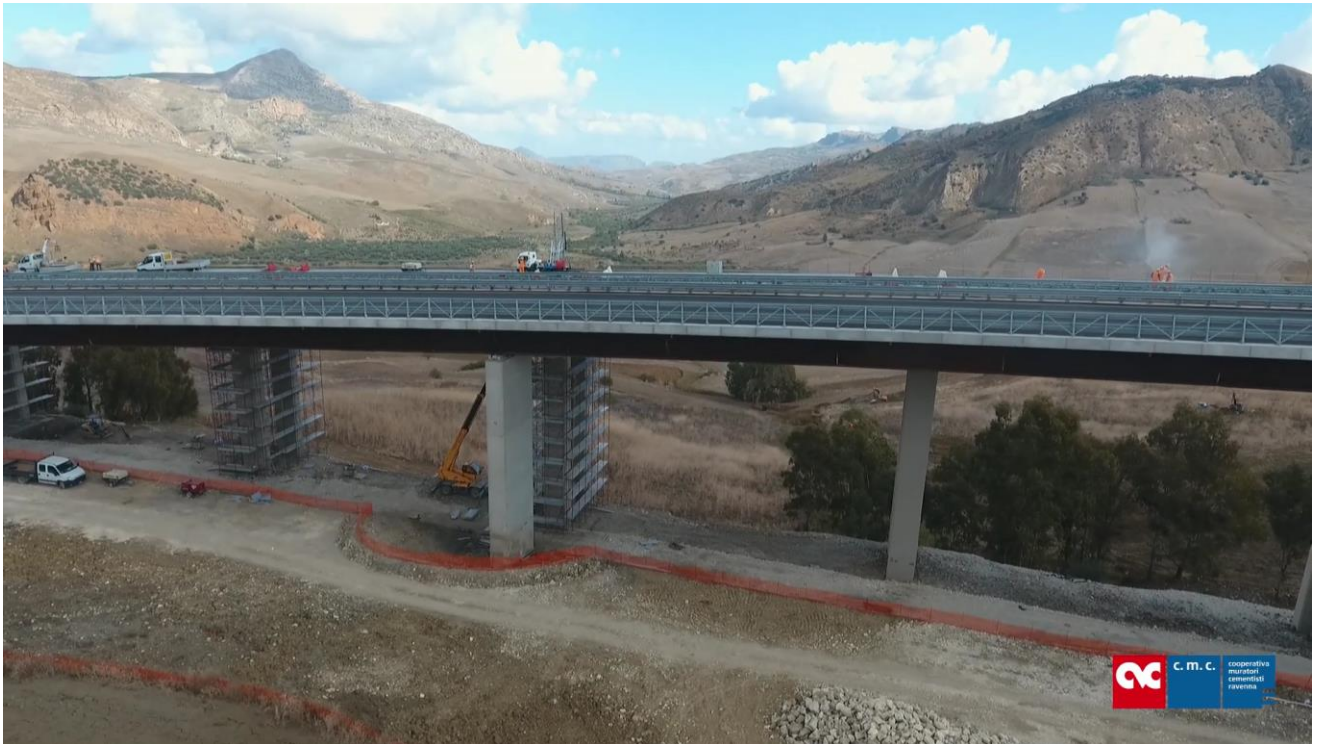
Foto 17 – Viadotto esistente Ferruzzi 1
