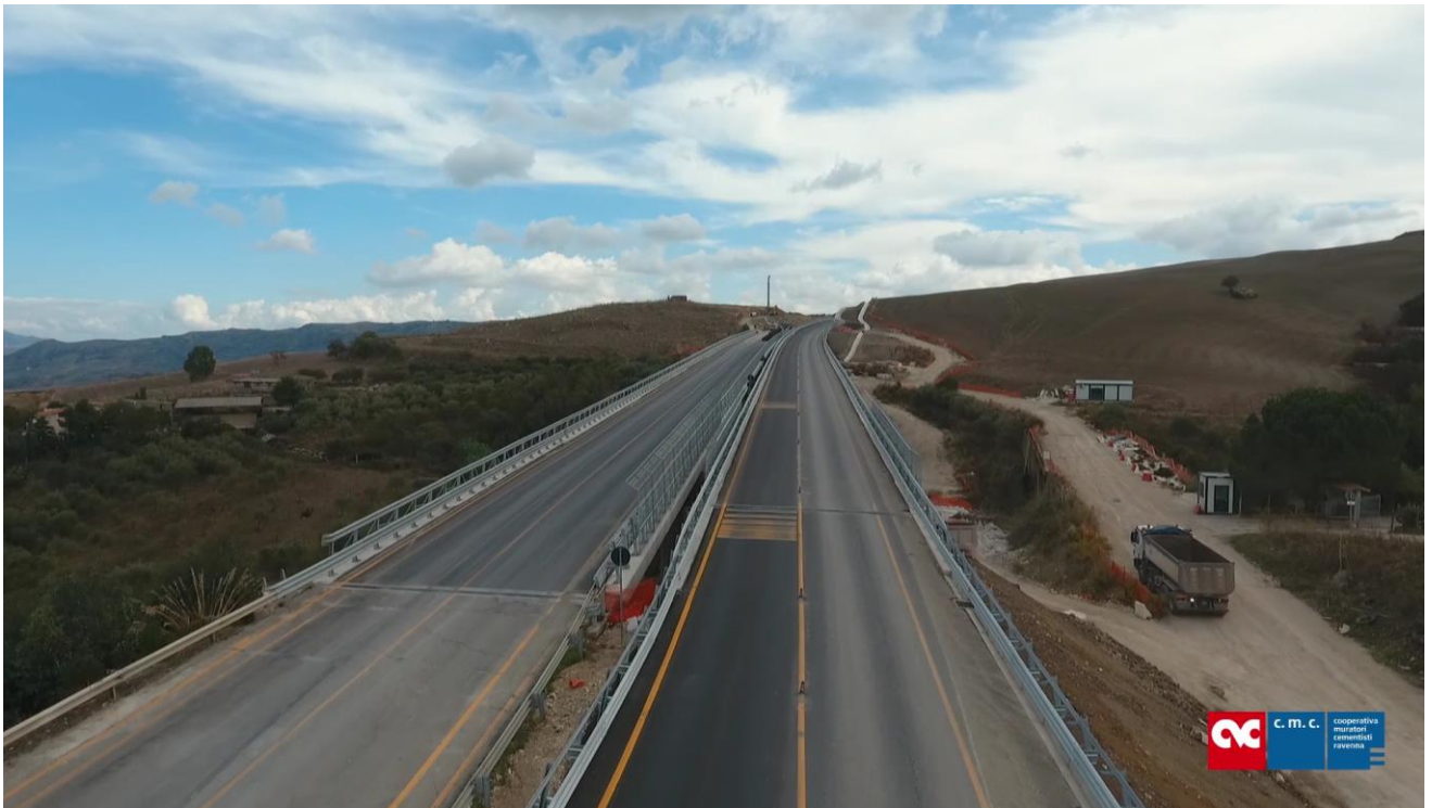
Foto 25 – Viadotto esistente Montagnola 2
