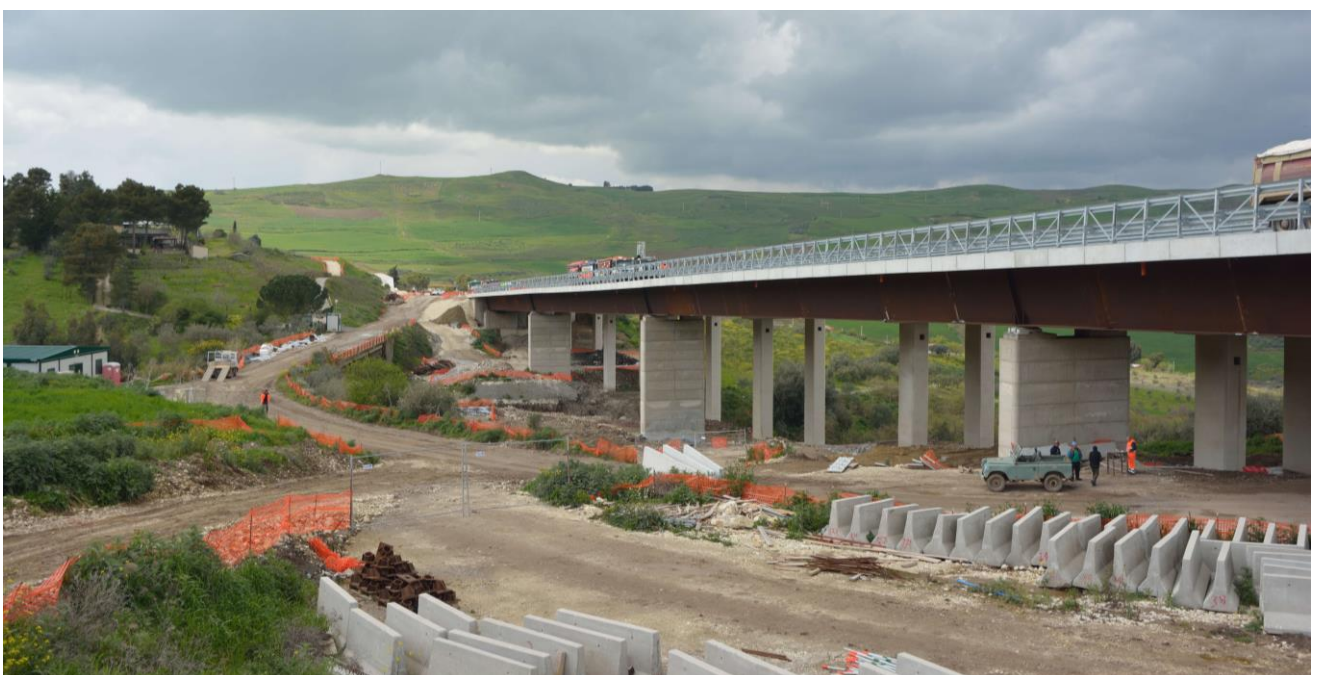
Foto 39 – Nuovo Viadotto Montagnola 2
