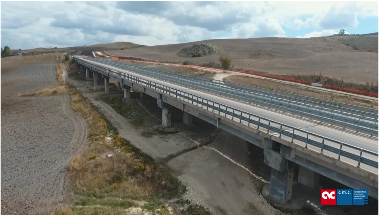
Foto 27 – Viadotto esistente Montagnola 2
