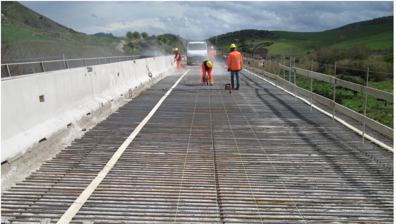
Foto 8 – Viadotto esistente Frattina 2
