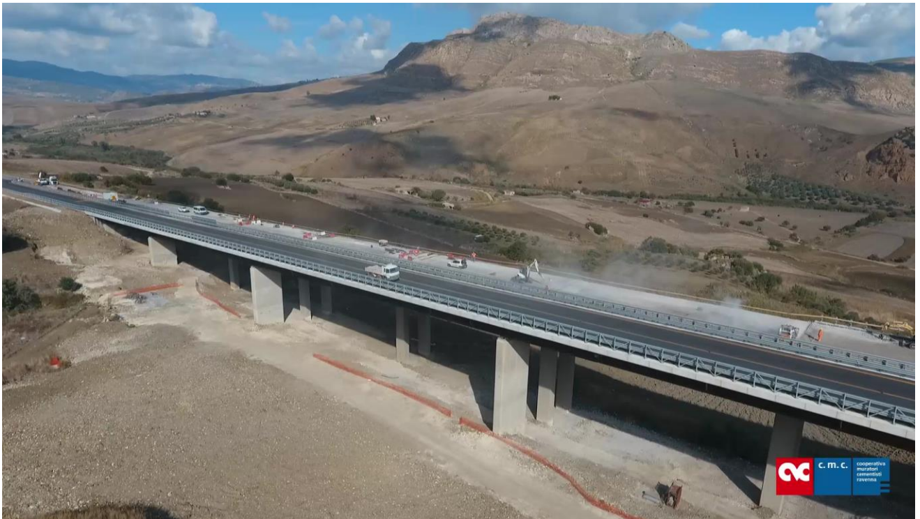
Foto 33 – Nuovo Viadotto Ferruzze 1
