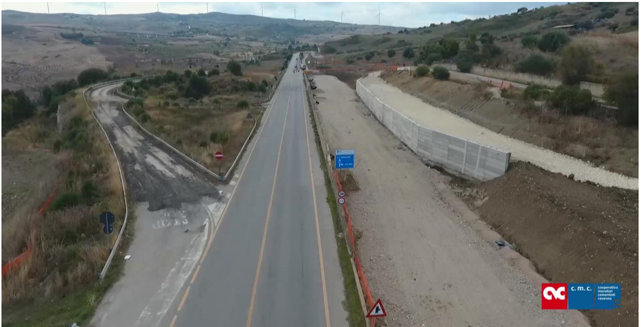
Foto 75 – Svincolo Vicari Sud
