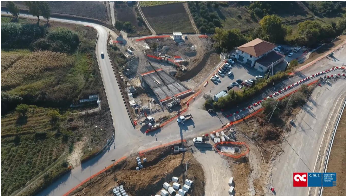
Foto 43 – Nuovo Ponte Frattina
