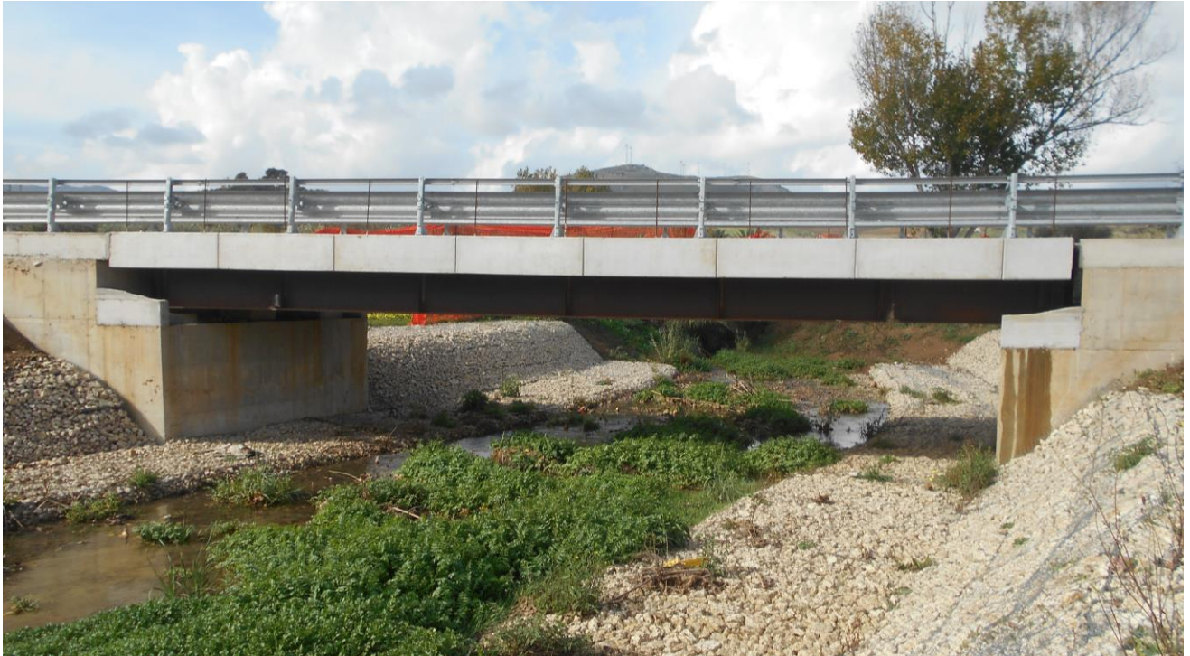
Foto 42 – Nuovo Ponte sul Torrente Mulinazzo
