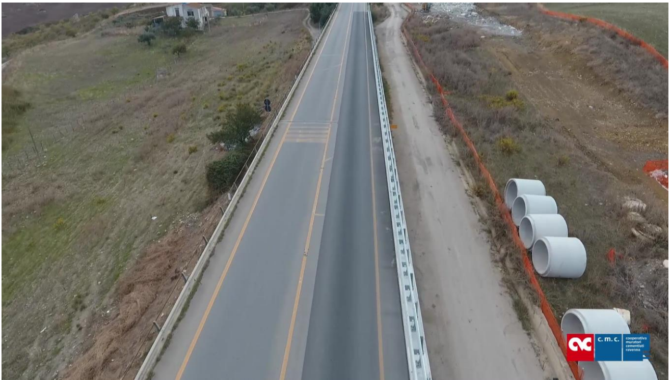
Foto 22 – Viadotto Santa Maria 1
