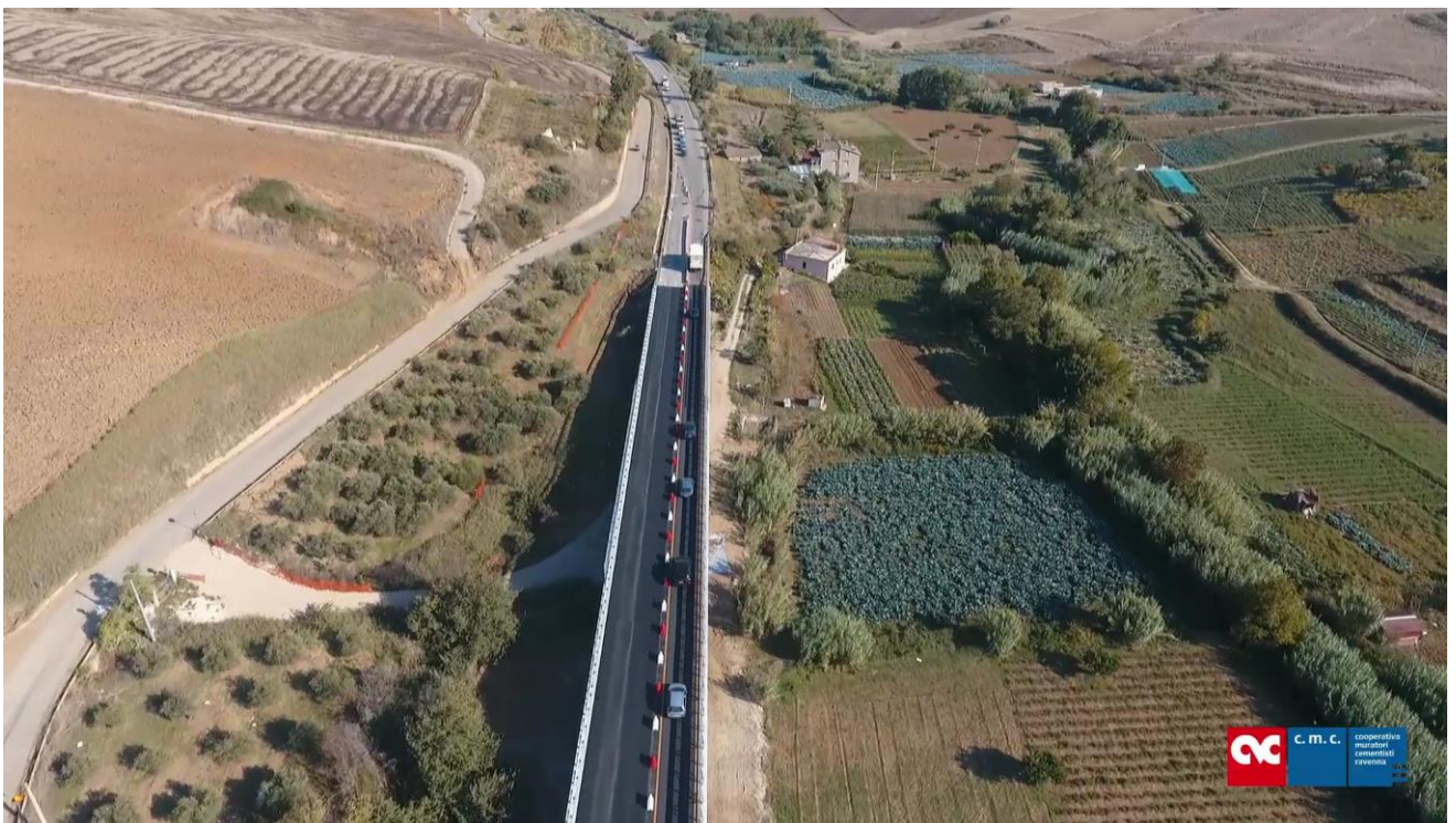
Foto 7 – Viadotto esistente Frattina 2
