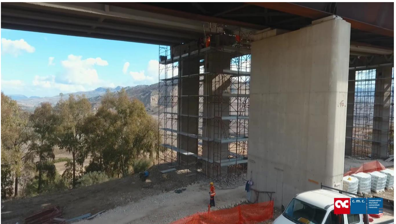
Foto 18 – Viadotto esistente Ferruzzi 1
