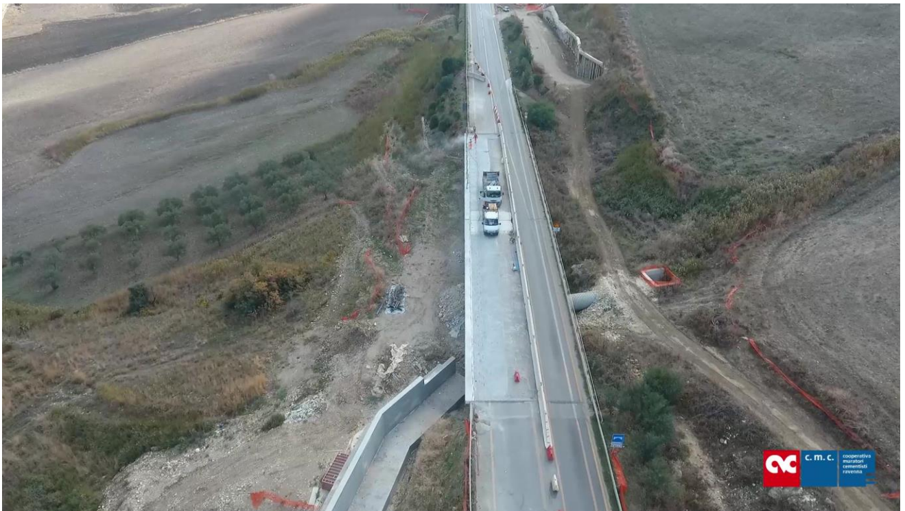
Foto 10 – Viadotto esistente Pecoraro 1
