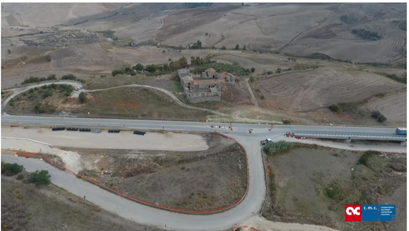
Foto 76 – Svincolo Vicari Sud
