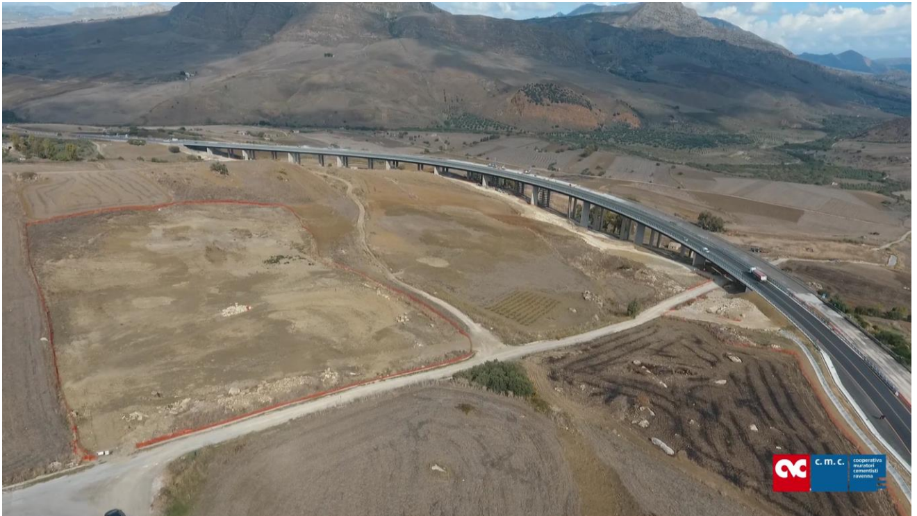
Foto 34 – Nuovo Viadotto Ferruzze 1
