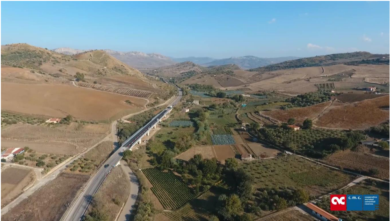
Foto 6 – Viadotto esistente Frattina 2
