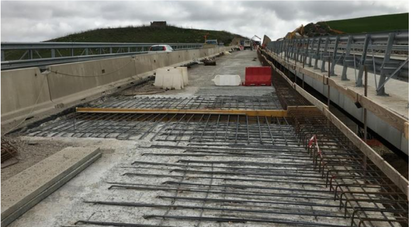
Foto 26 – Viadotto esistente Montagnola 2
