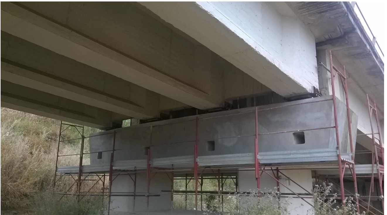
Foto 12 – Viadotto esistente Pecoraro 1
