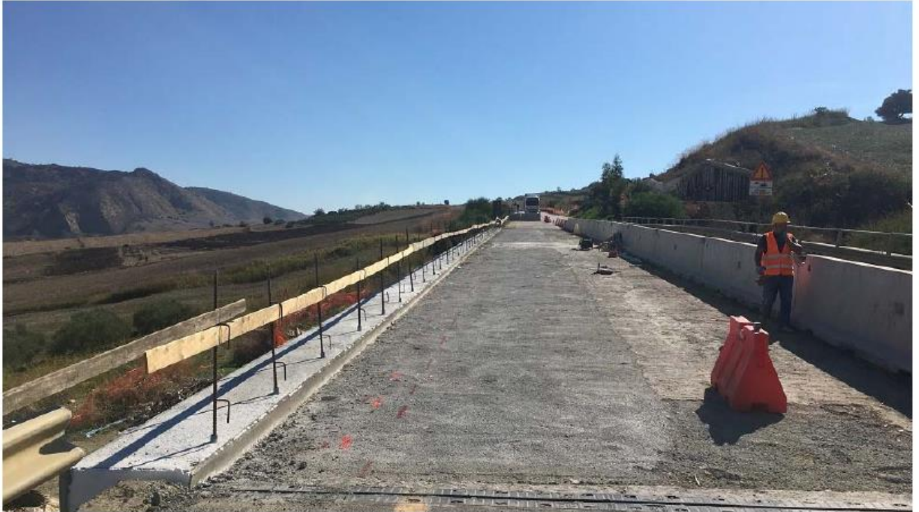
Foto 11 – Viadotto esistente Pecoraro 1
