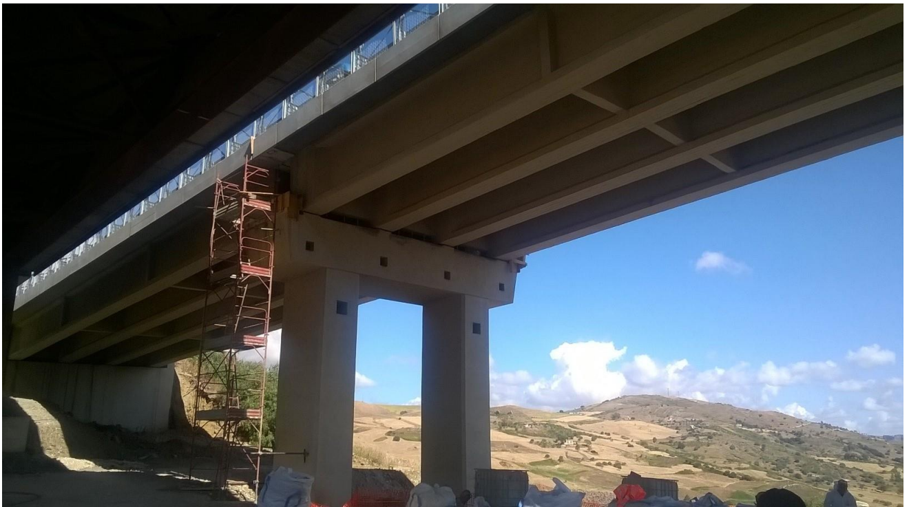
Foto 21 – Viadotto Santa Maria 2
