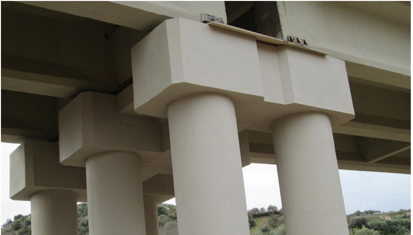
Foto 5 – Viadotto esistente Frattina 1
