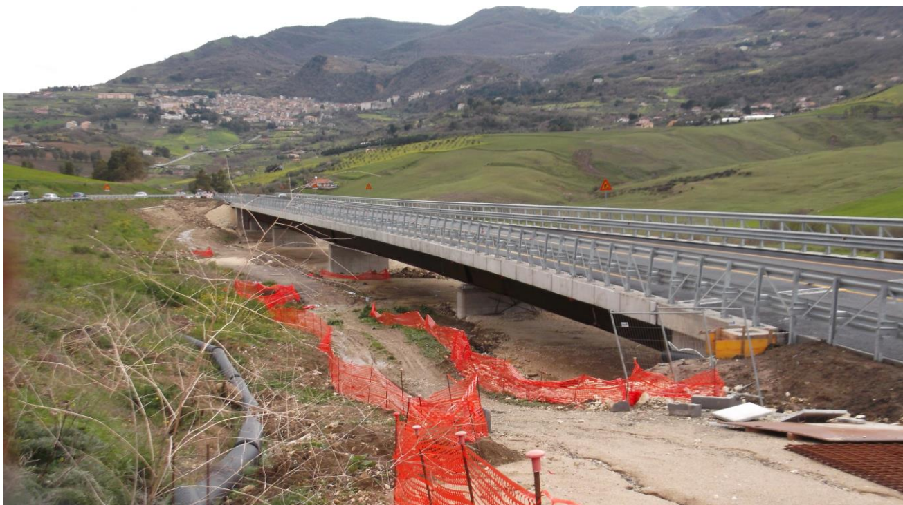
Foto 29 – Viadotto esistente Scorciavacche 1
