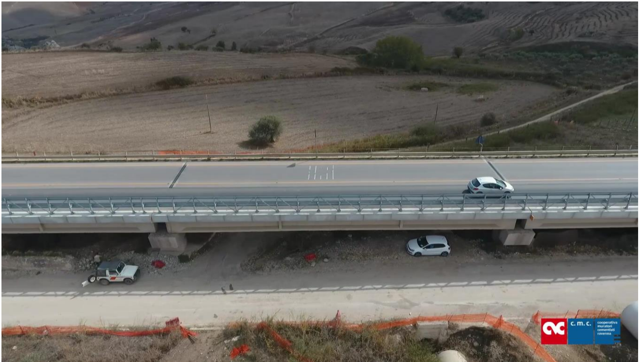
Foto 23 – Viadotto Santa Maria 1
