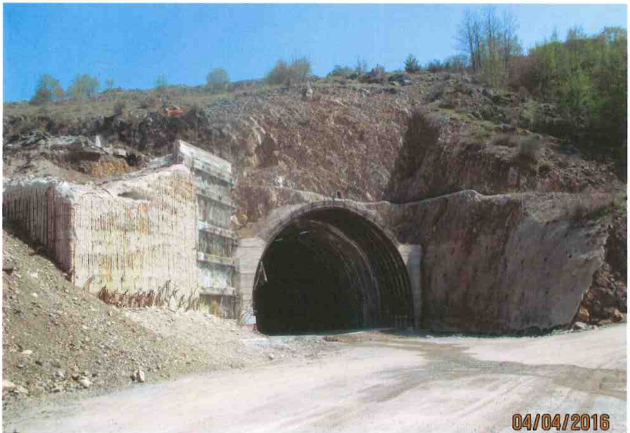
Figura 1.1 – Immagine della situazione attuale dell'imbocco della finestra intermedia della galleria naturale Serra Rotonda
