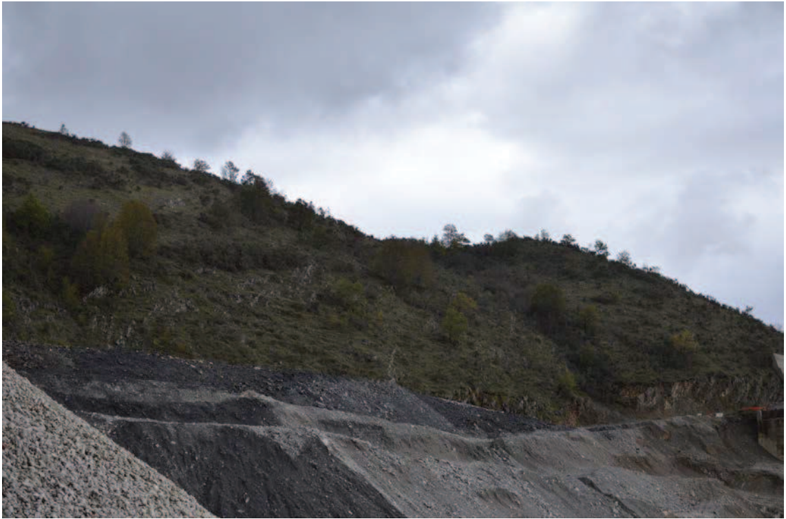
zona sommitale dell'intervento
