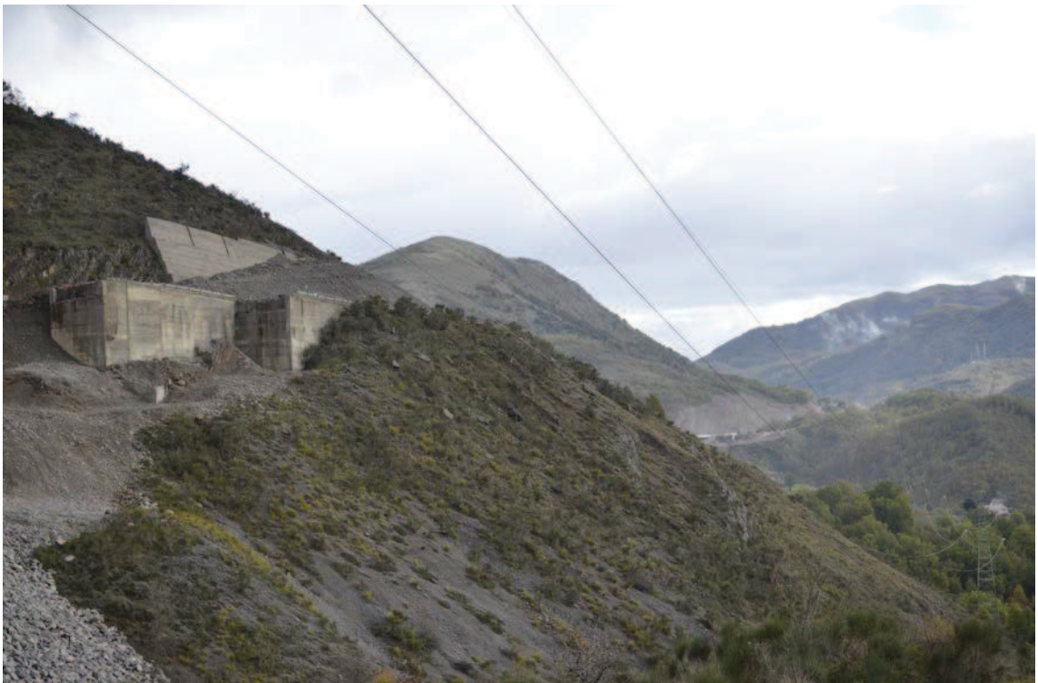
vegetazione spontanea al margine sud dell'intervento (spalla del viadotto)
