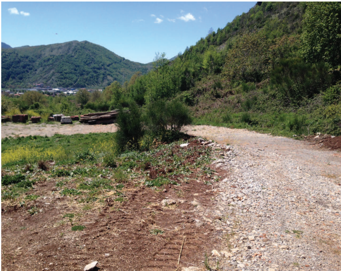
Foto 9 - Vista testa ciglio-canale piazzale inferiore (zona di riporto)
