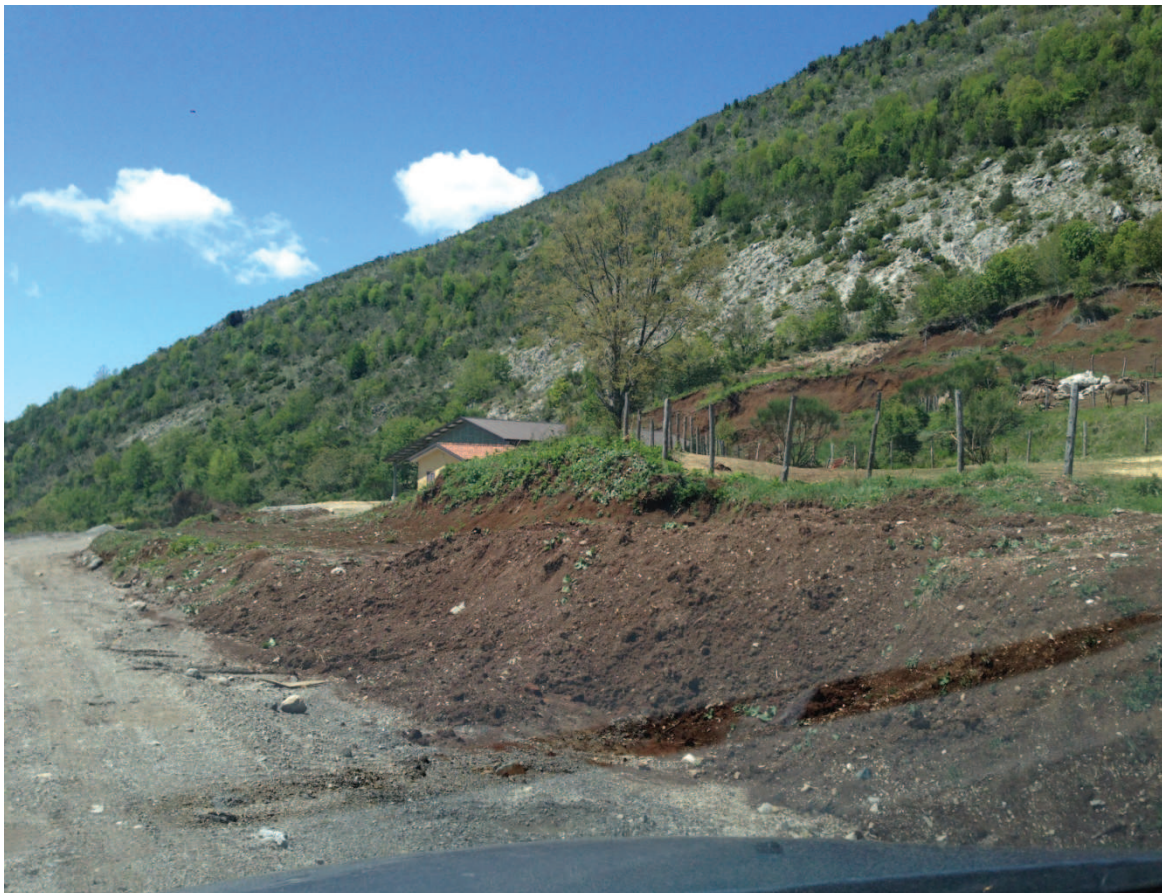
Foto 5 - Vista piazzale superiore
