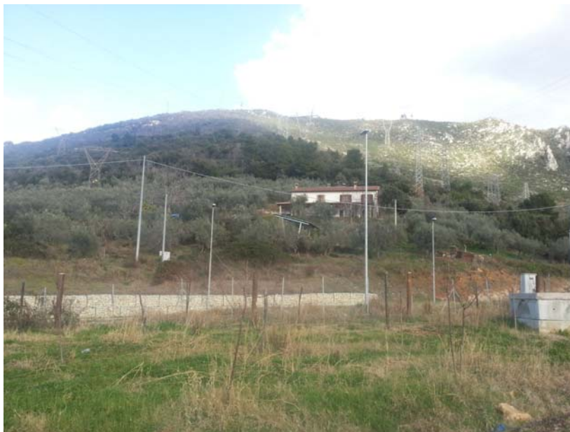
Fig. 9: Punto di vista C
