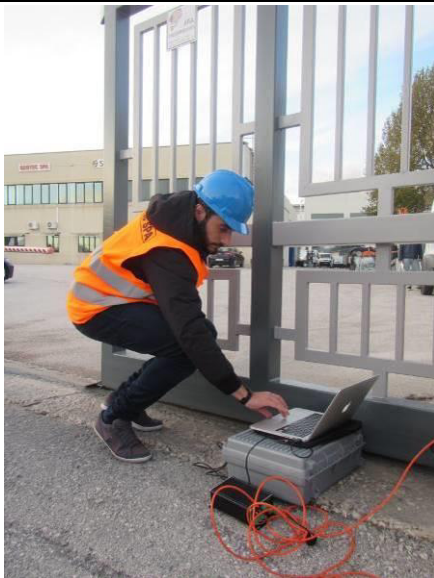
Misura trasversale allineamento vibratori: 10 m - ASFALTO
