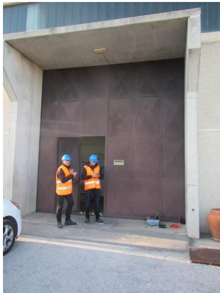
Misura trasversale allineamento vibratori: 45 m – PAVIMENTO INDUSTRIALE
