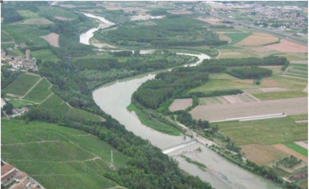
Foto Capellino da aereo con traversa efficiente - 2006
