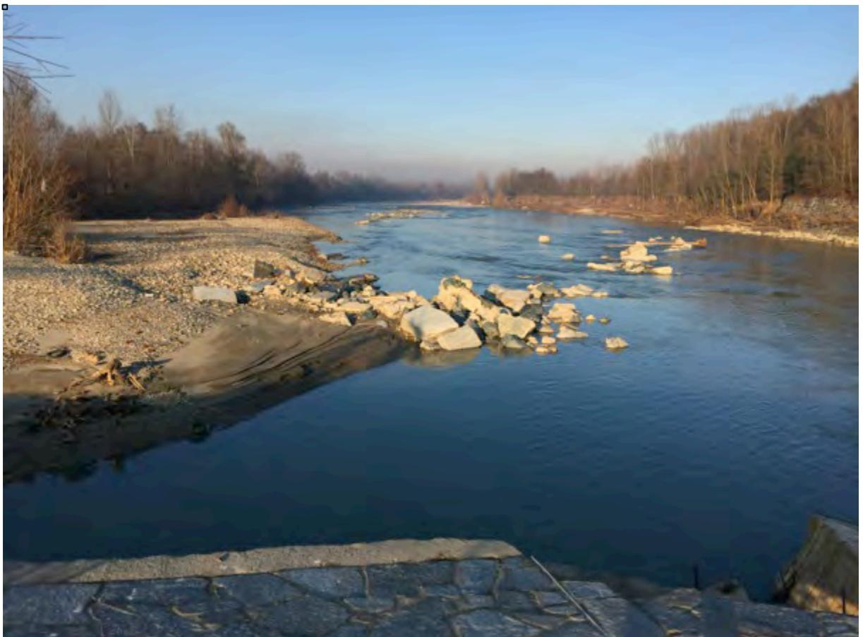
**Strutture della traversa crollate in alveo**
