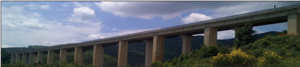
Figura 13 – Paesaggio PA07 / Viadotto Farma
