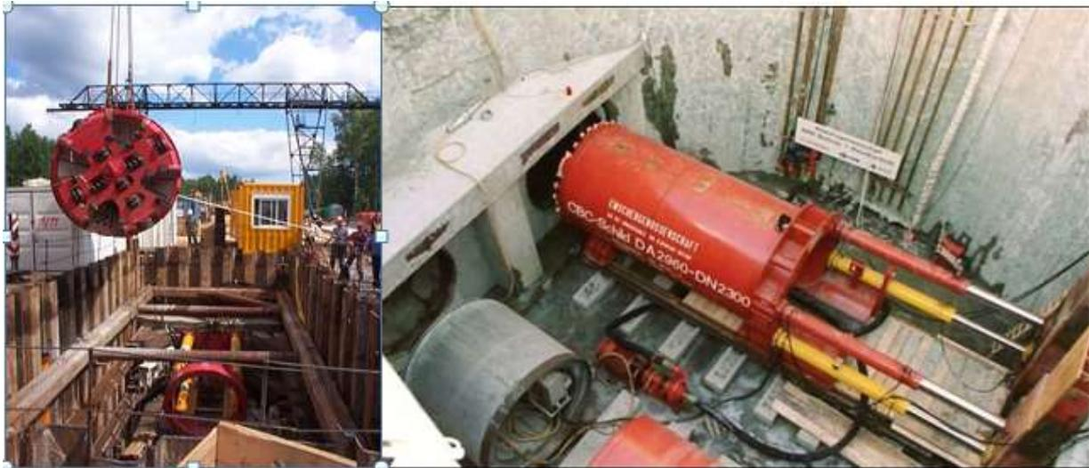
Figura 15-7- Installazione della TBM
