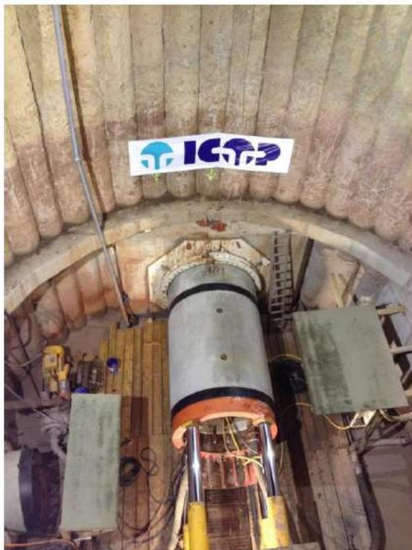
*Figura 13-1- Esempio di Pozzo di spinta eseguito con pali secanti.*
